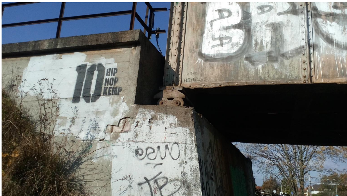
Obrázek 21: Detail pohyblivé podpory
