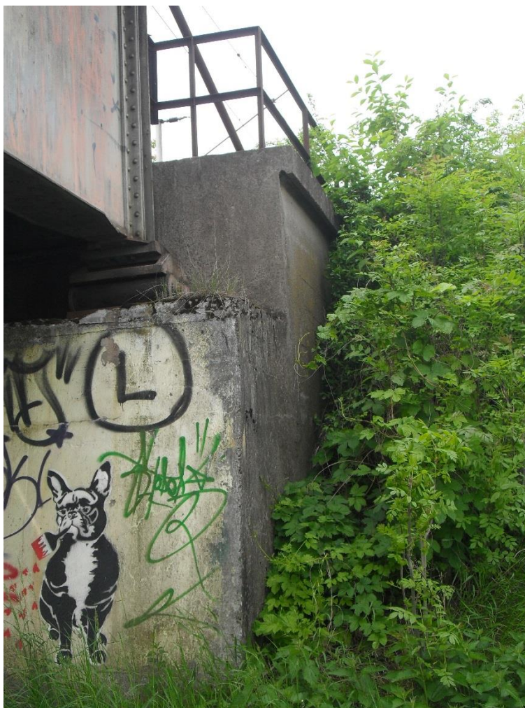
Obrázek 9: Opěra s křídlem ve směru Chlumeck nad Cidlinou
