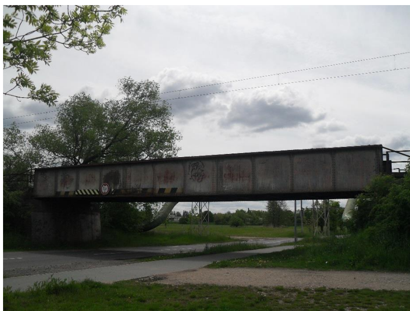
Obrázek 3: Skutečný stav mostní konstrukce
