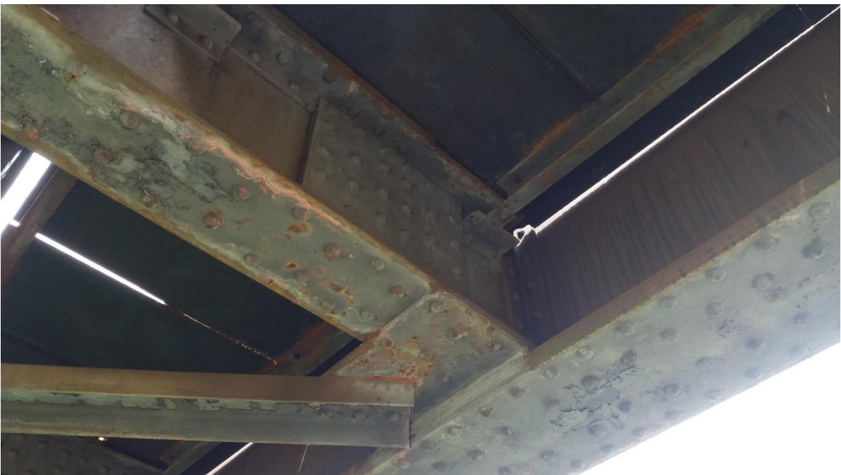
Obrázek 14: Detail upevnění - příčník a hlavní nosník
