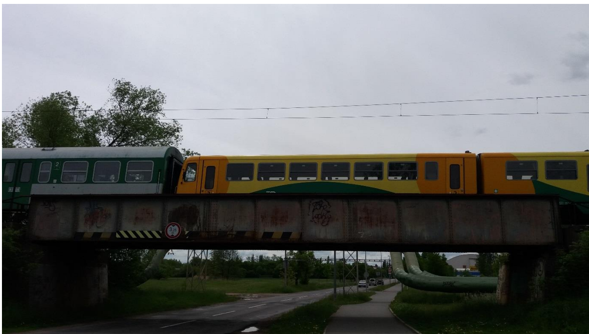
Obrázek 22: Konstrukce zatížená dopravou (1)
