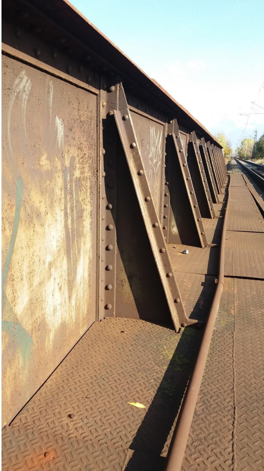
Obrázek 19: Detail svislé výztuhy
