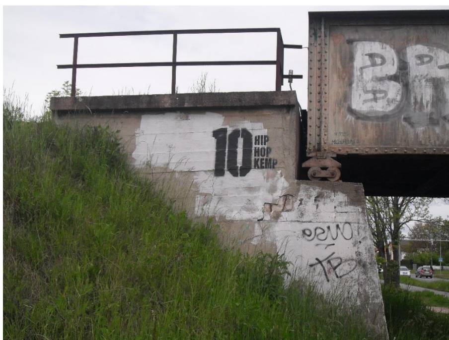
Obrázek 10: Zábradlí na křídle ve směru Chlumeck na Cidlinou
