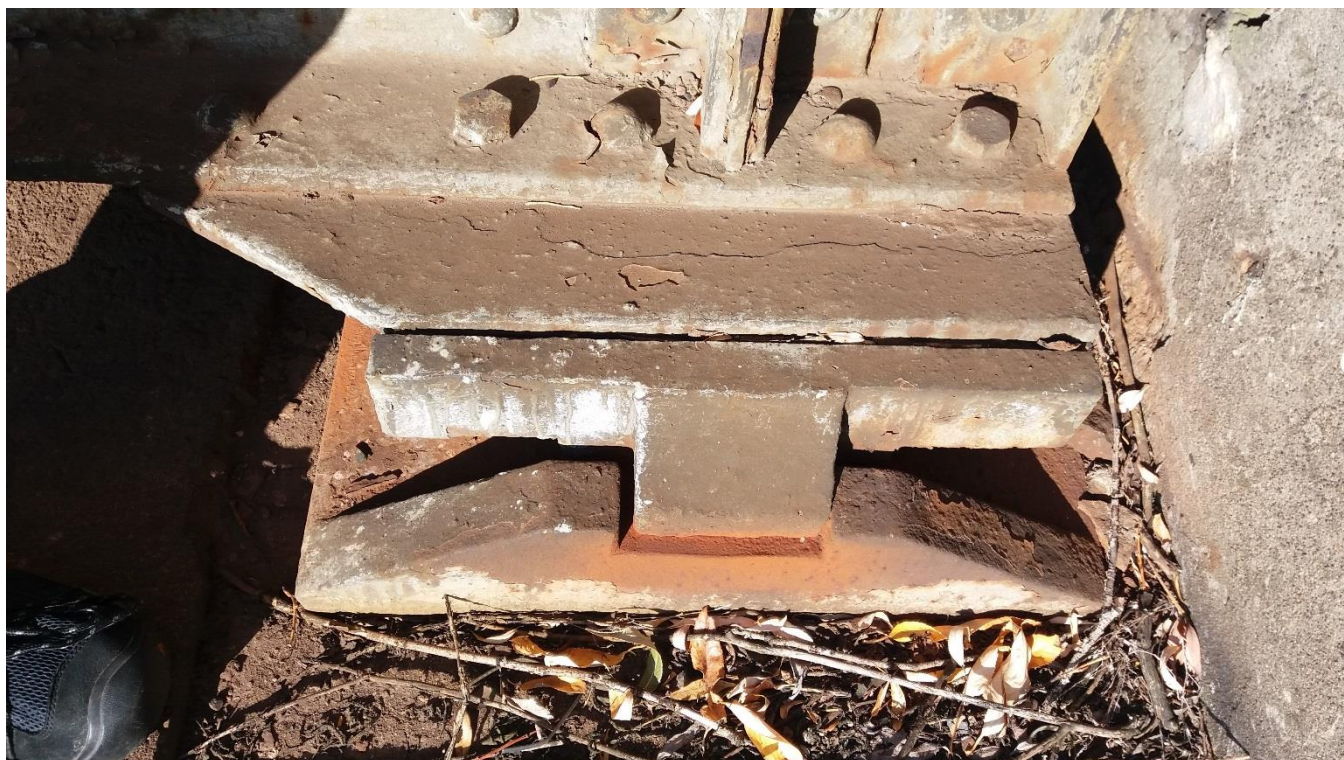
Obrázek 20: Detail pevné podpory
