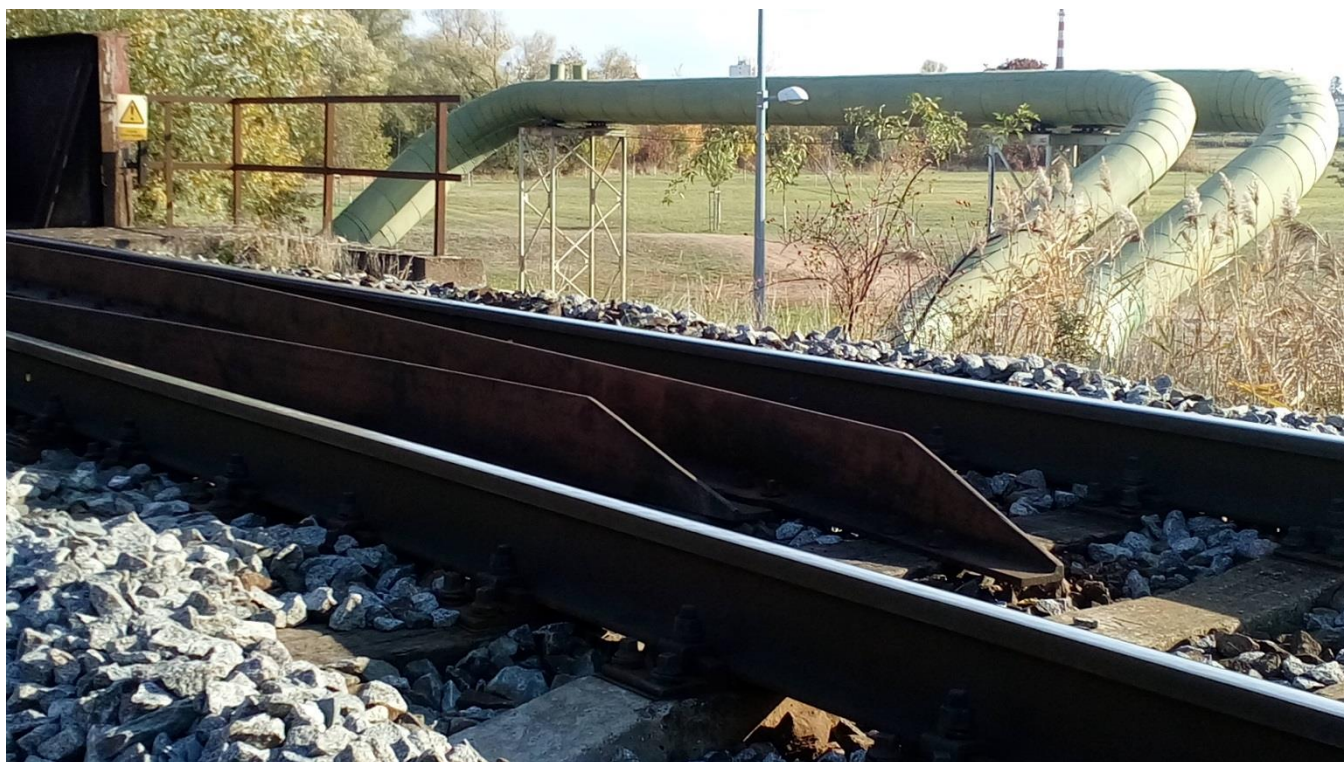
Obrázek 18: Detail ukončení pojistných úhelníků
