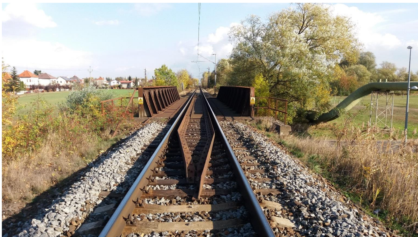
Obrázek 16: Horní pohled na konstrukci směrem na Miedzylesie
