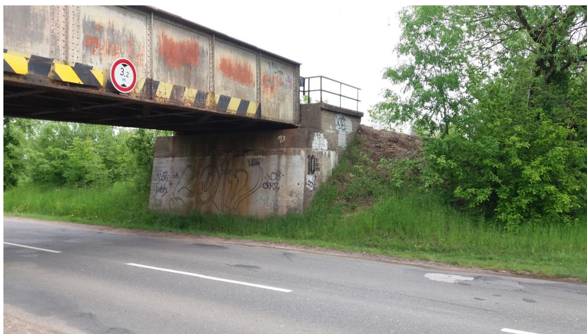
Obrázek 8: Pohled na opěru ve směru Miedzylesie
