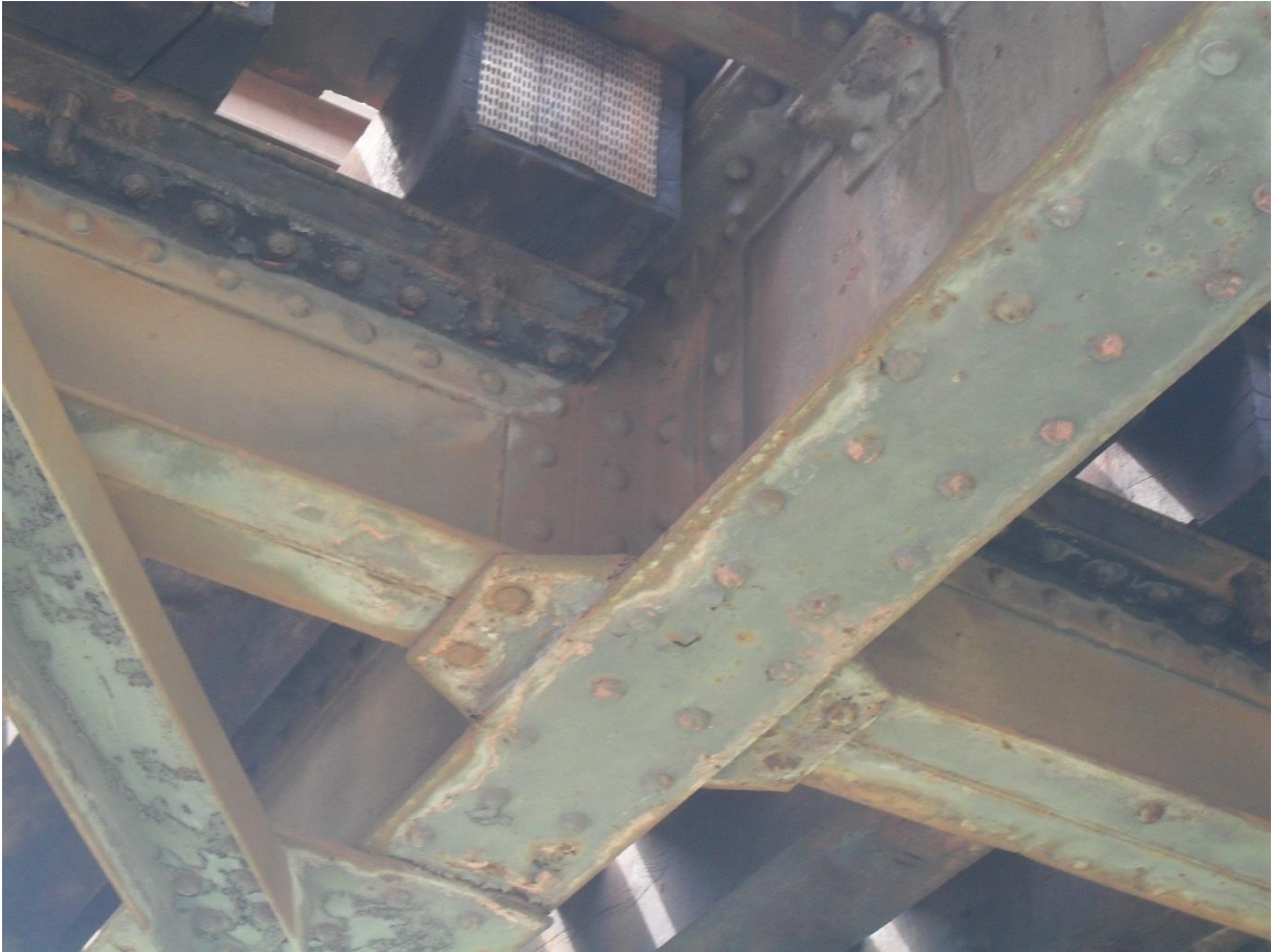
Obrázek 13: Detail upevnění - podélník a příčník
