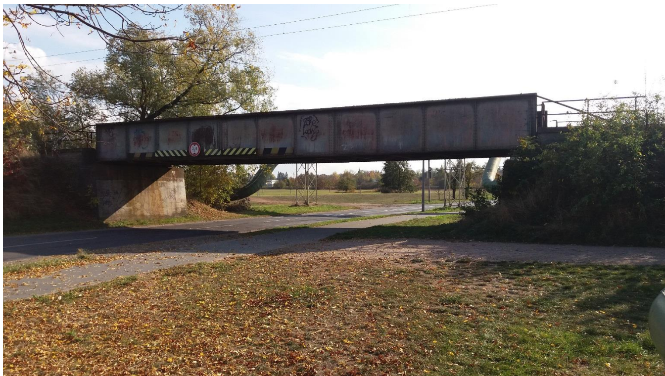
Obrázek 11: Pohled na mostní konstrukci ve směru do centra města
