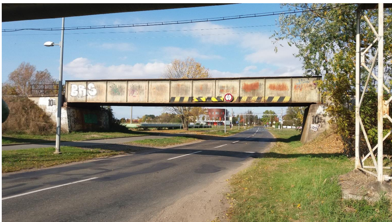
Obrázek 12: Pohled na mostní konstrukci ve směru městská část Věkoše
