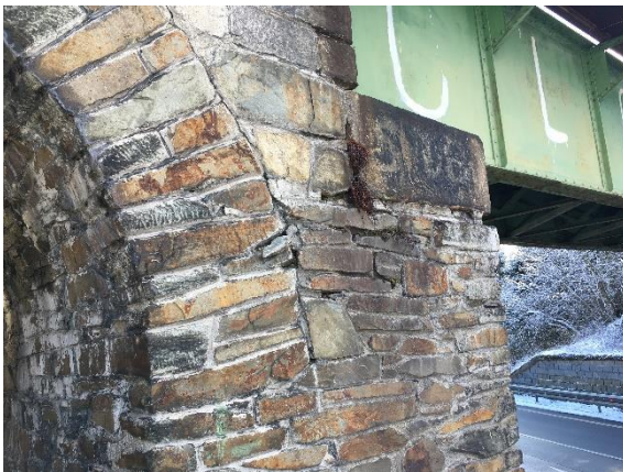
Obrázek 21. - Vyrůstající vegetace pilíř P02
