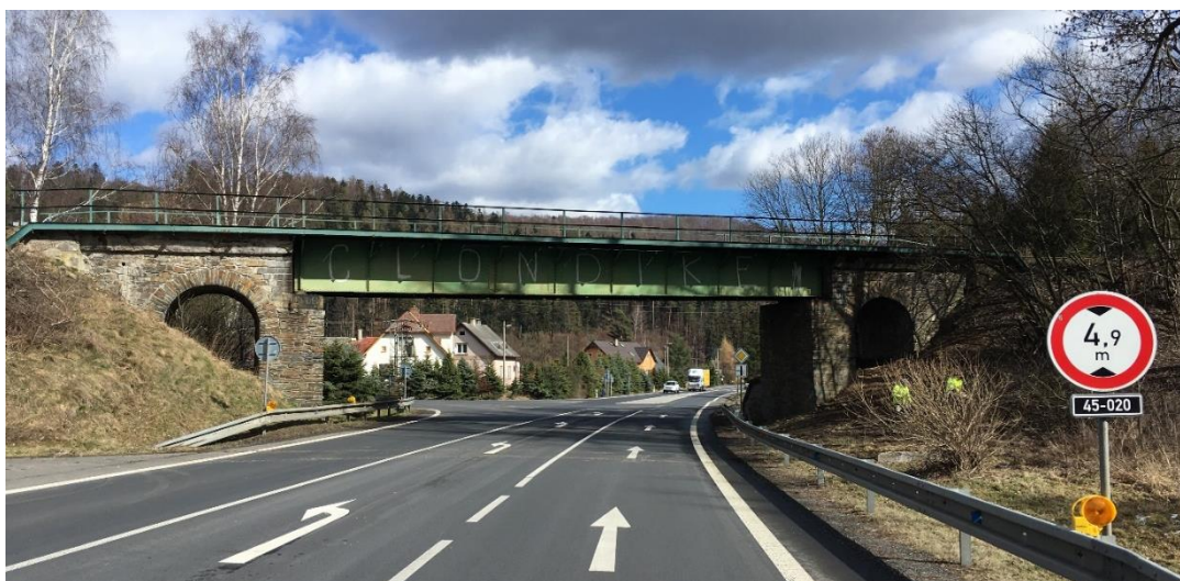
Obrázek 16. - Celkový pohled na most směrem Opava
