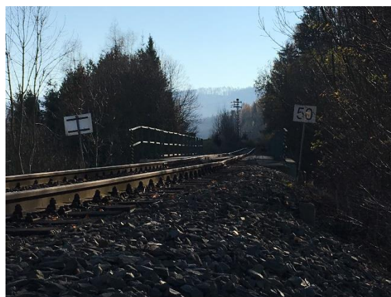
Obrázek 32. - Sednutí svršku obou předpolích
