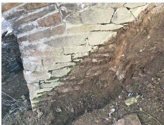
Obrázek 49. - Ručně kopaná sonda OP1 pohled směr Bruntál
