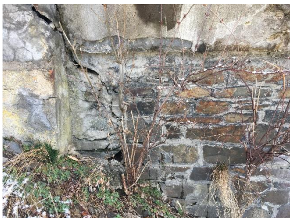
Obrázek 25. - Vznik svislé praskliny
