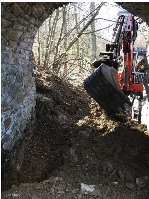
Obrázek 51. - Strojně kopaná sonda OPI
