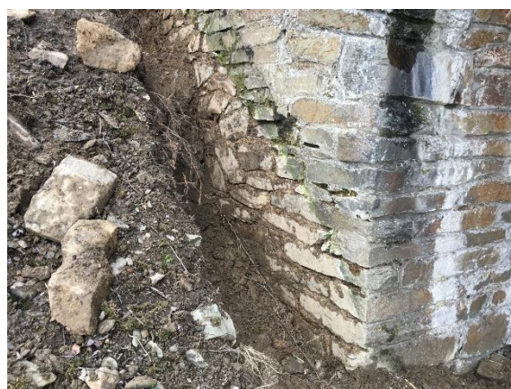
Obrázek 50. - Ručně kopaná sonda OP2 pohled směr Opava
