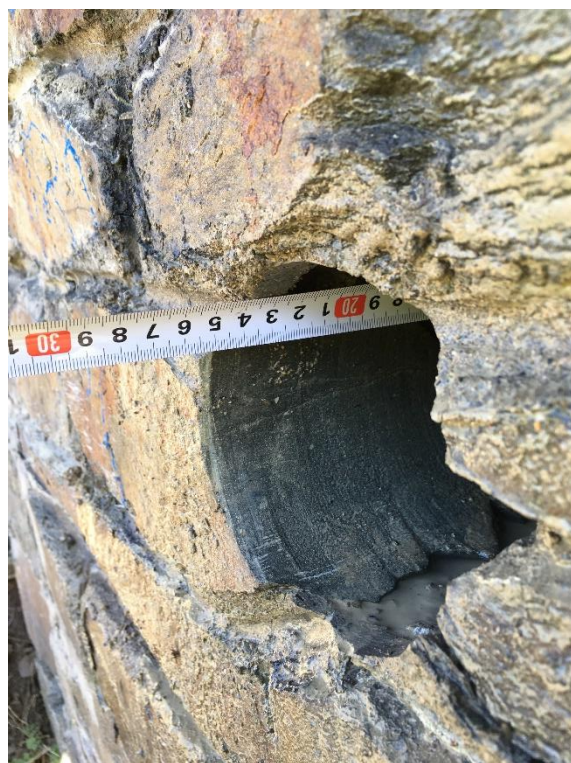
Obrázek 38. - Jádrový délka 250 mm
