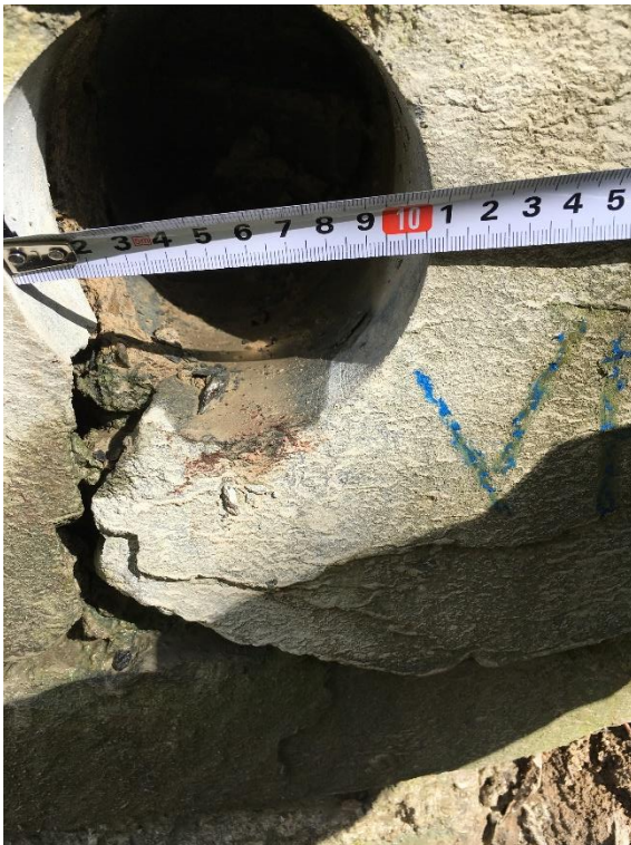
Obrázek 45. - Jádrový vrt průměr 100 mm
