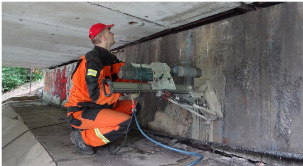
Obrázek 12. - Realizace jádrového vrtu při provádění diagnostiky
