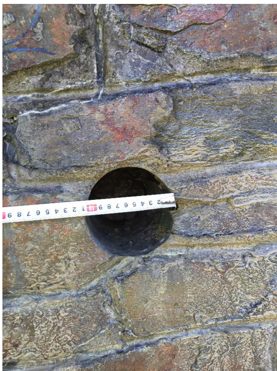
Obrázek 37. - Jádrový vrt průměr 100 mm
