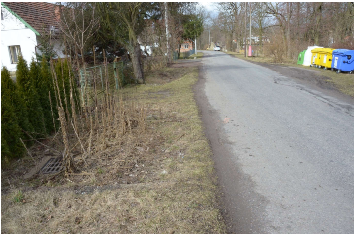
Obrázek 14: km 0,250 Vpust, část původního příkopu
