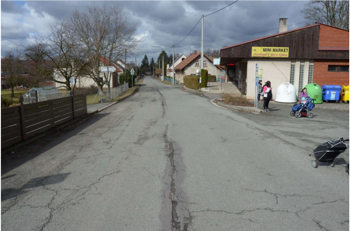
Obrázek 7: km 0, 040 Pohled na prostor zastávky BUS vlevo
