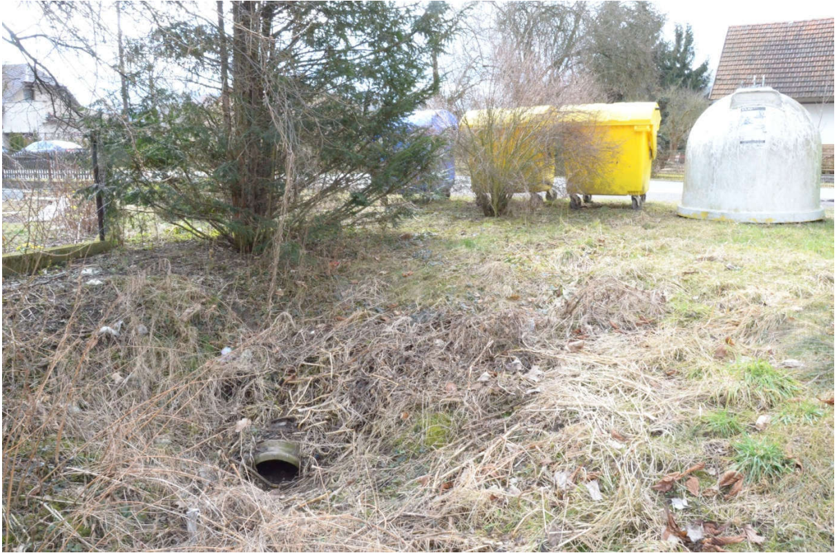
Obrázek 15: km 0,260 Výtok odvodnění
