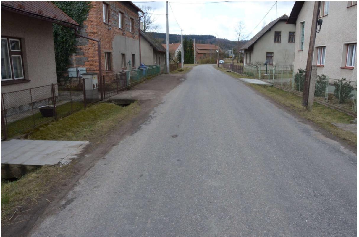
Obrázek 23: km 0,690 Zpevněné sjezdy k nemovitostem nad původním zaneseným příkopem
