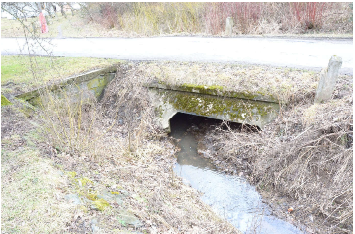
Obrázek 25: km 0,840 Propust - přemostění vodoteče
