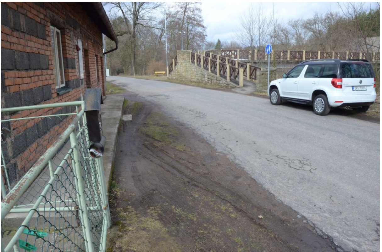
Obrázek 16: km 0,320 Zúžený prostor mezi domem ČP 67 a lávkou přes Orlici
