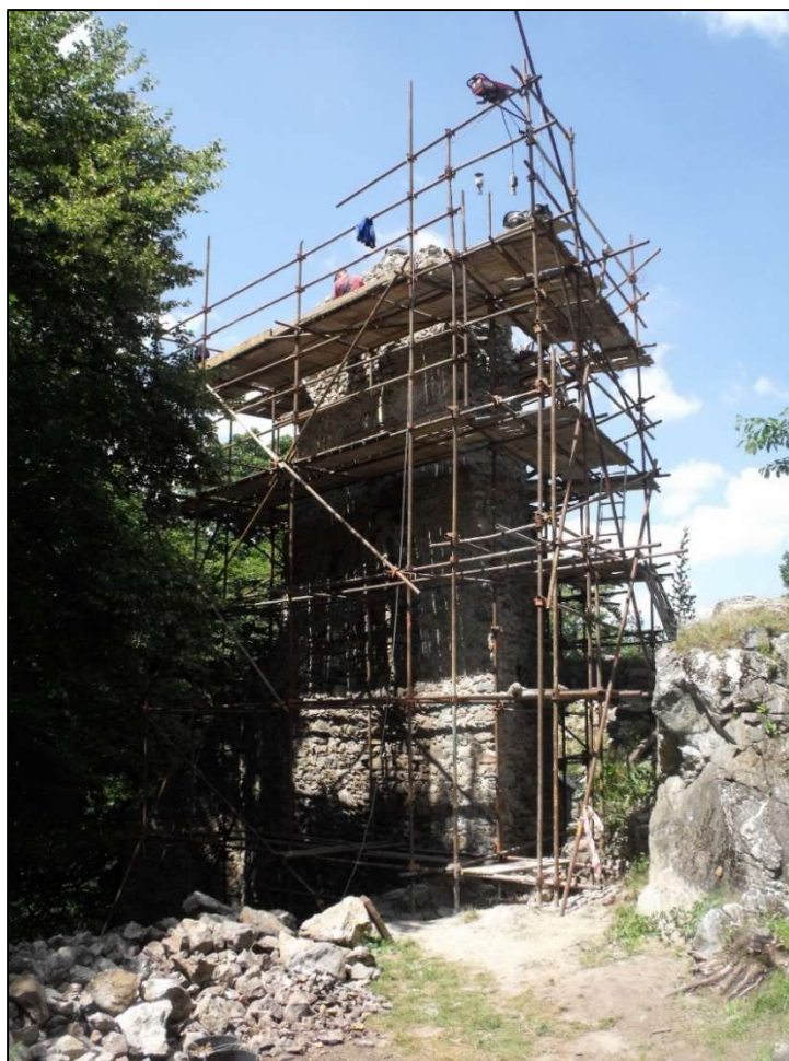
Obr. 17 Opravy střepu zdiva jihozápadního úseku obvodové hradby. Foto J. Šteňha 8. 6. 2016.
