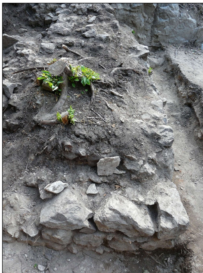
Obr. 12 Odhalené základové zdivo pilíře č. 4 po vykopání sondy č. 1 – Pilíř donjonu. Foto J. Musil 24. 6. 2014.
