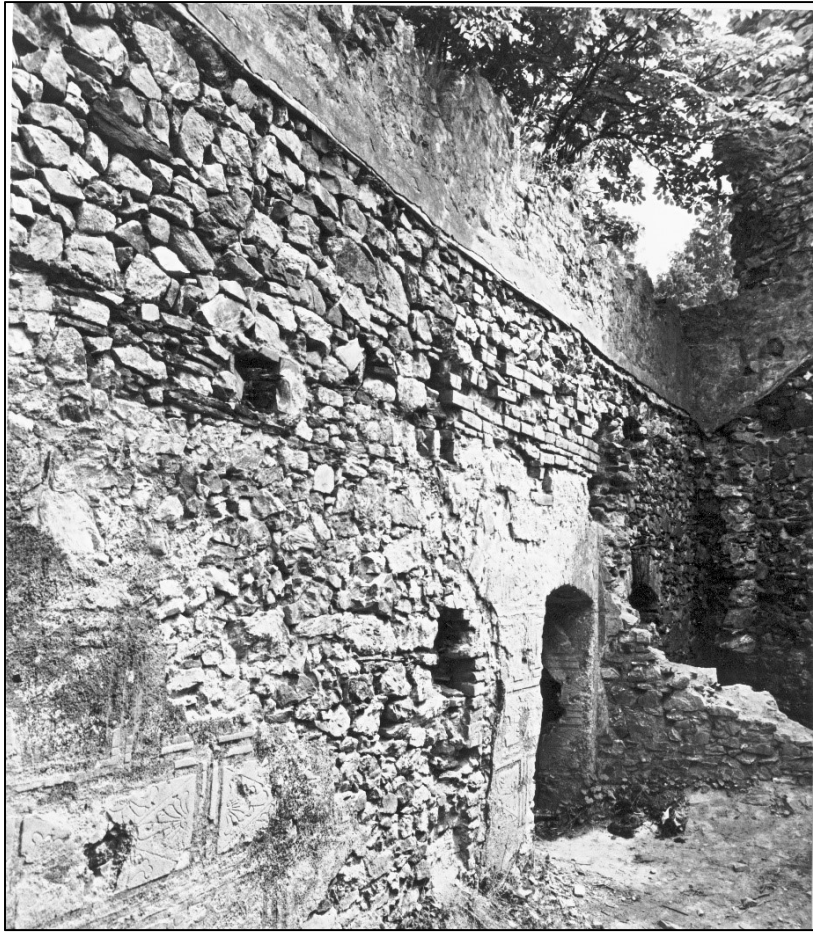
Obr. 5 Zdevastovaný interiér letohrádku a dosud zachovaná nádvoří stěna v roce 1979. Sbírká fotografií V. Nováka.
