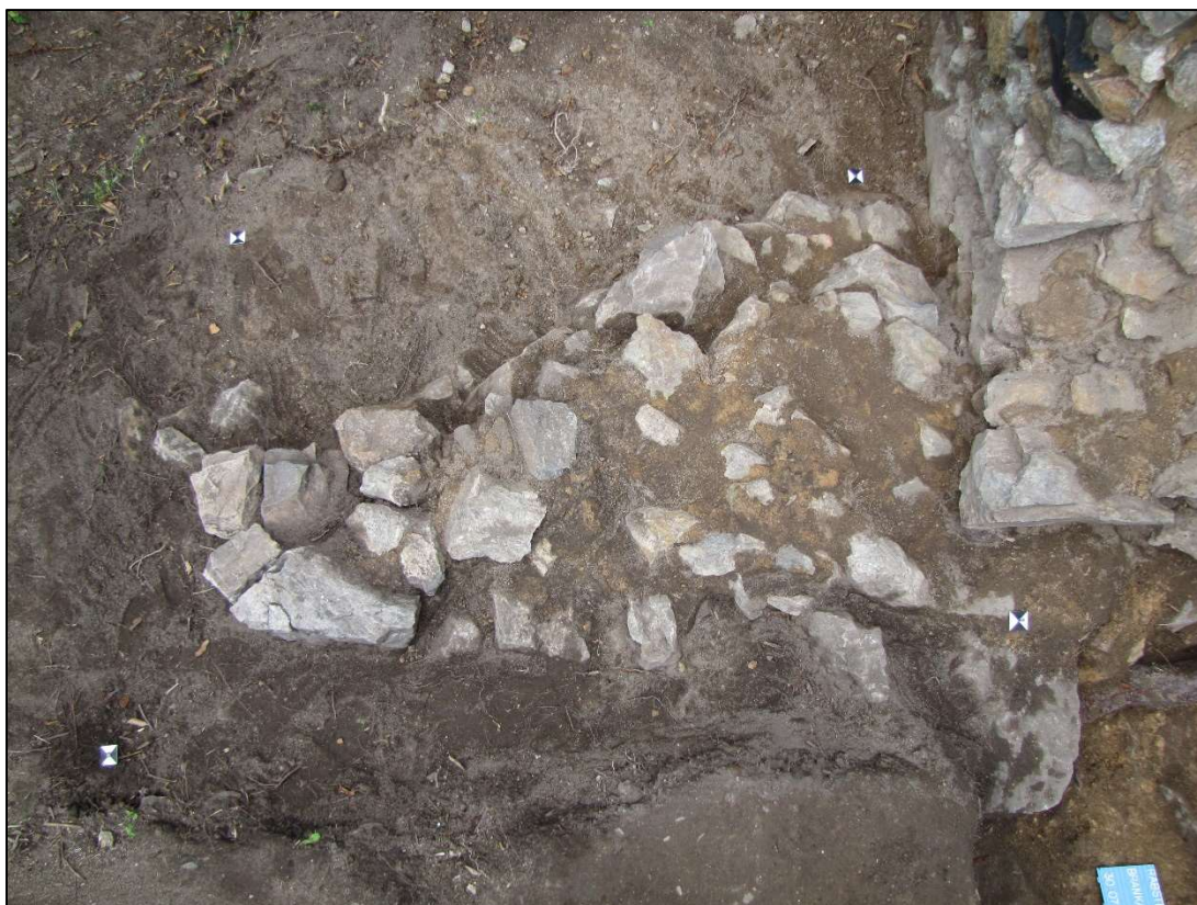
Obr. 15 Základ zdiva branského objektu odhalený při výkopu sondy č. 3 – Branka. Foto J. Musil, 30. 7. 2014.
