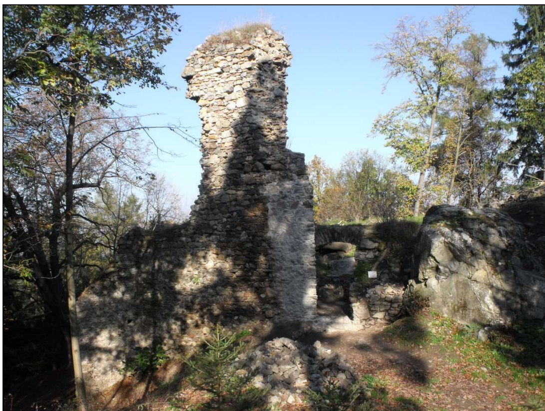
Obr. 16 Vstupní strana hradního jádra po provedené rekonstrukci líce obvodové hradby. Foto J. Musil 24. 10. 2014.
