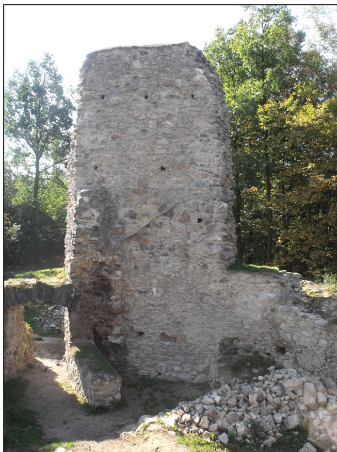
Obr. 19 Pohled na nádvoří stranu střepeu obvodové hradby po konzervaci. Foto J. Šteňha 2. 8. 2016.
