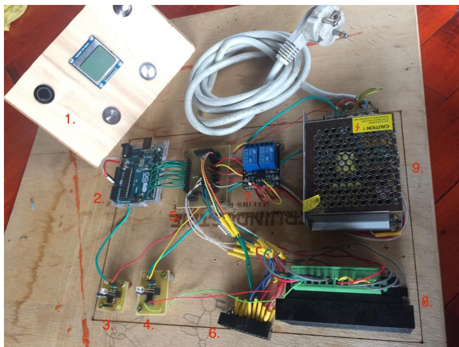
Obr. F. 1 – Pohled na elektroinstalaci ze shora
