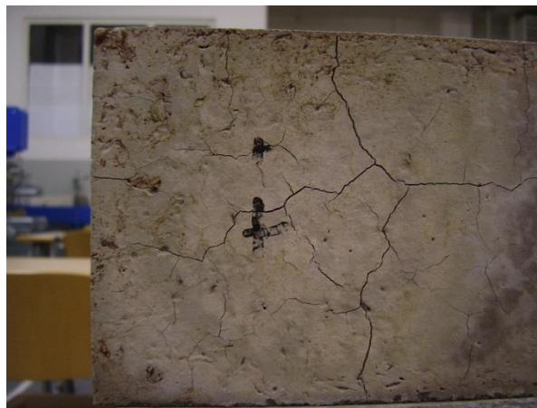
Obrázek A 26 Těleso protkané sítí trhlin po teplotním lokálním namáhání – (LWSCCžih) zatíženo na ~ 1049 °C
