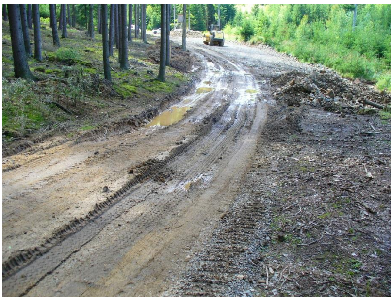
Obrázek 30. Průběh stavby na lesní cestě Zíchov
