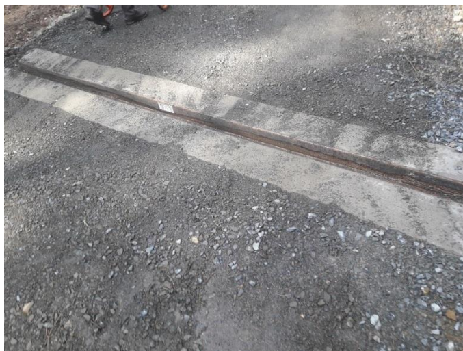
Obrázek 8. Ocelová svodnice uložená do betonu
