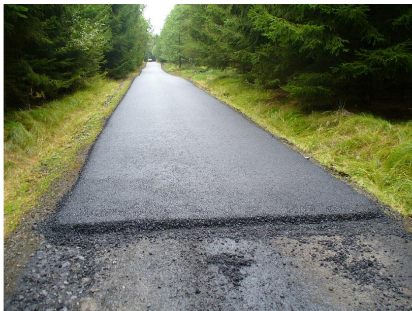
Obrázek 34. Průběh stavebních prací na lesní cestě Chejlava 63
