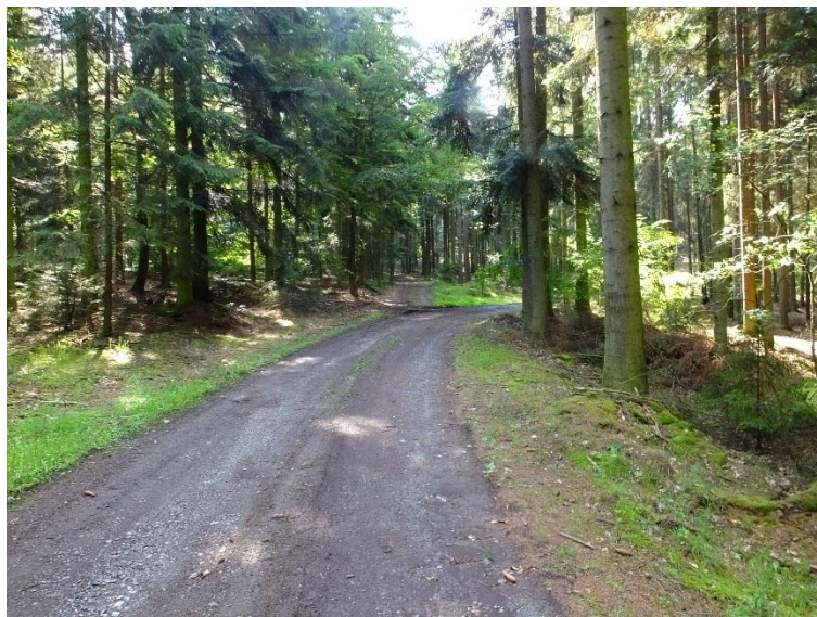
Obrázek 23. Svážnice Strýčkovice před stavebními úpravami
