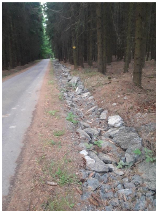
Obrázek 10. Zához příkopu lomovým kamenem
