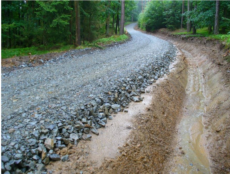
Obrázek 27. Průběh stavby na SV Zichov
