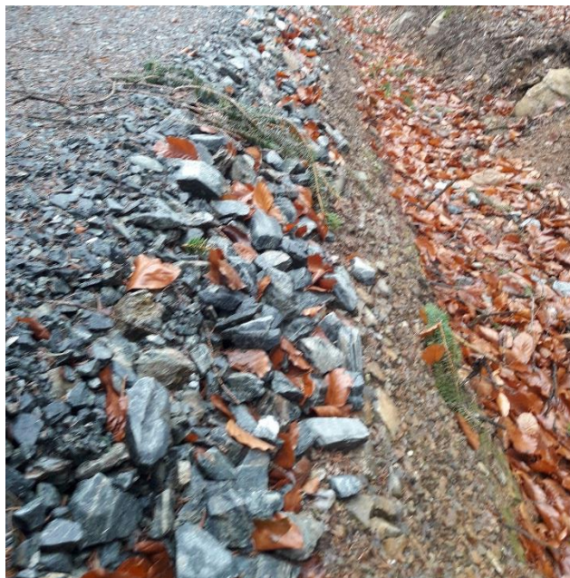
Obrázek 12. Konstrukce komunikace ze štěrkodrti
