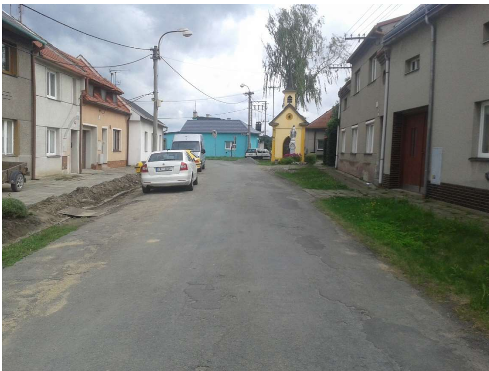
Pohled stavu stávajícího krytu ve střední části rekonstrukce
