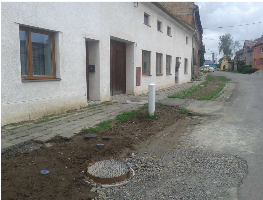
Pohled na stávající stav chodníku, odvodnění a krytu vozovky
