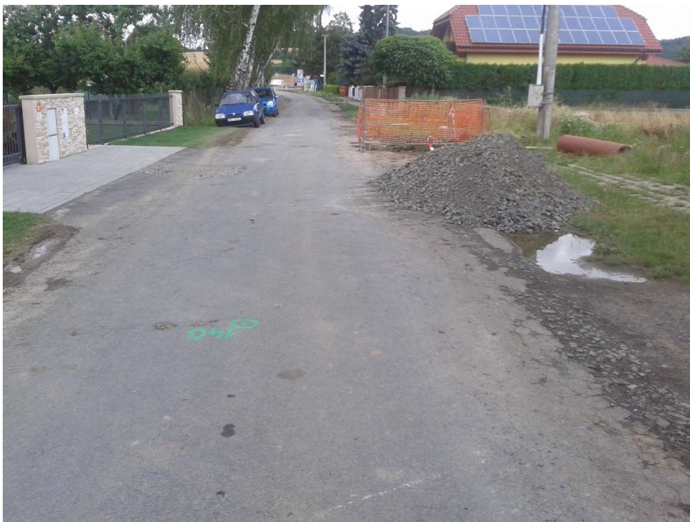
Pohled na stávající stav odvodnění a krytu
