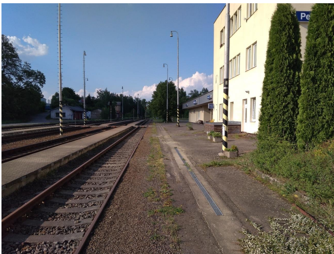
Obrázek 13 - železniční stanice v Pelhřimově na trati 237
