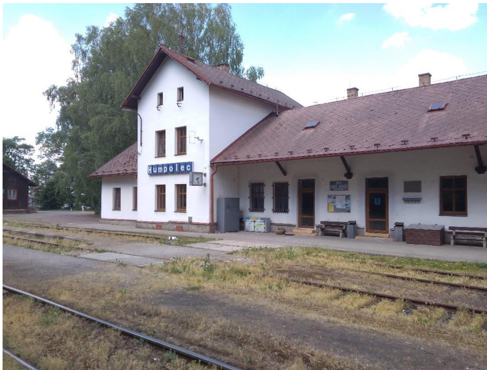
Obrázek 2 - drážní budova železniční stanice v Humpolci
