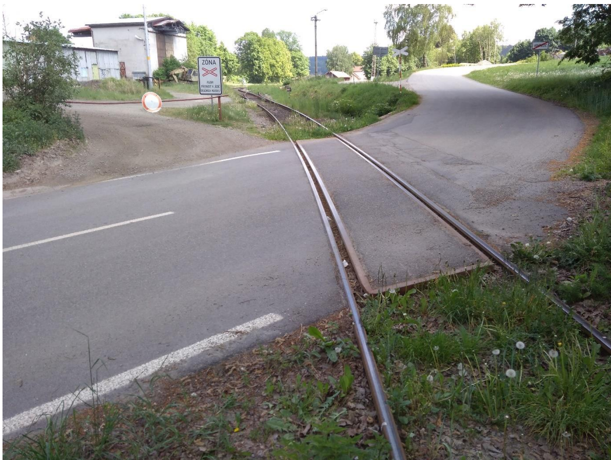
Obrázek 4 - přejezd na trati směrem od napojujícího místa pohledem k drážní budově Humpolec
