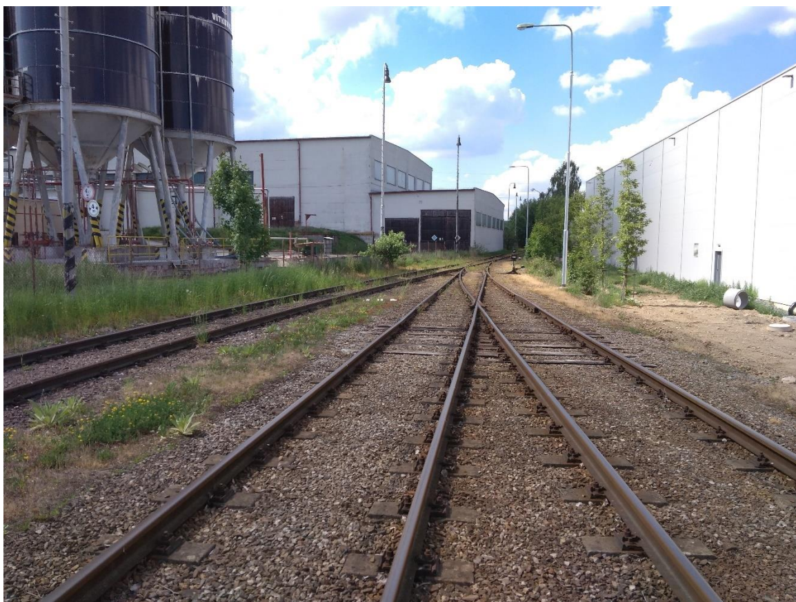
Obrázek 7 - pohled na výhybky směrem k místu napojení trasy na trať 224
