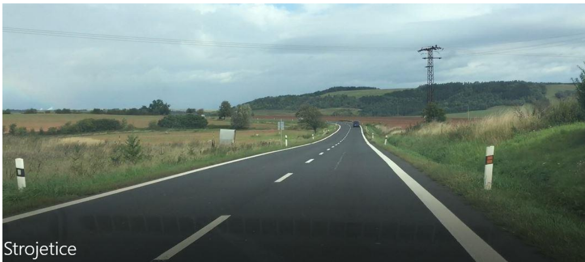
Pohled 1 - ZÚ – staničení 0,000 – Nová hranice obce s vjezdovou bránou
