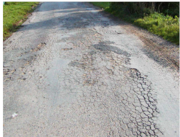
Obr. 41: Plošná deformace vozovky (vlevo), plošná deformace se ztrátou únosnosti vozovky (vpravo). [23]
