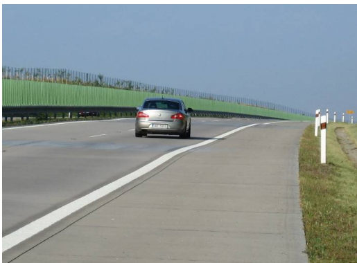
Obr. 42: Zvlnění cementobetonového krytu. [24]
