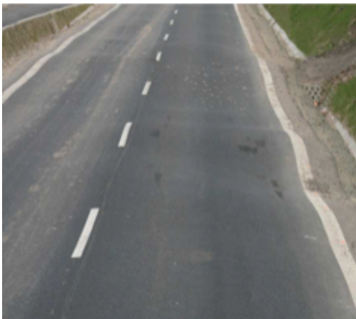
Obr. 41: Plošná deformace vozovky (vlevo), plošná deformace se ztrátou únosnosti vozovky (vpravo). [23]
