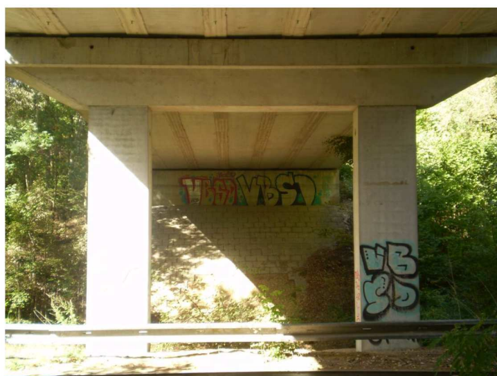
pohled na 1.pilíř od začátku mostu
