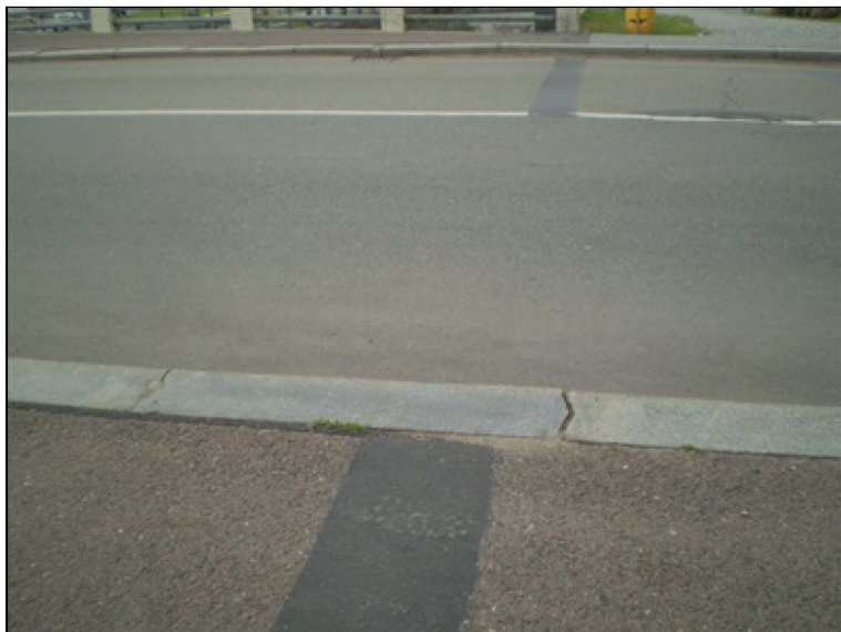
Mostní závěr na konci mostu.JPG
