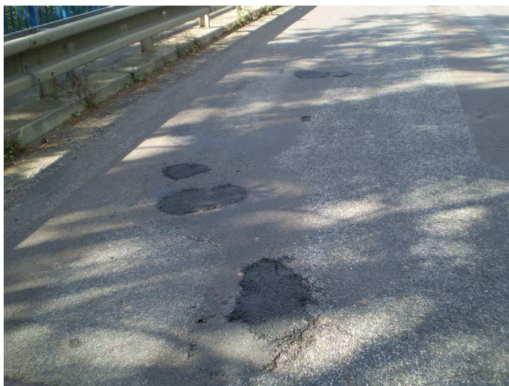
opravovaný kryt vozovky na začátku mostu
