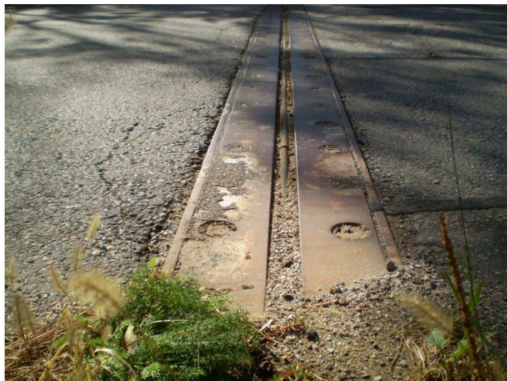
mostní závěr na začátku mostu
