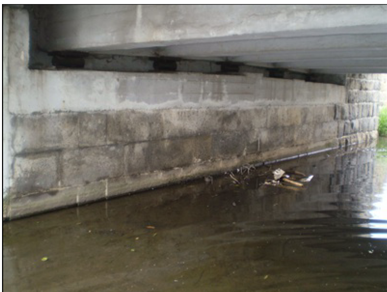
Opěra na konci mostu OP2.JPG
