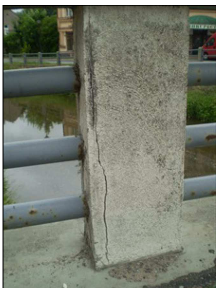
Trhlina v betonovém sloupku zábradlí vpravo.JPG
