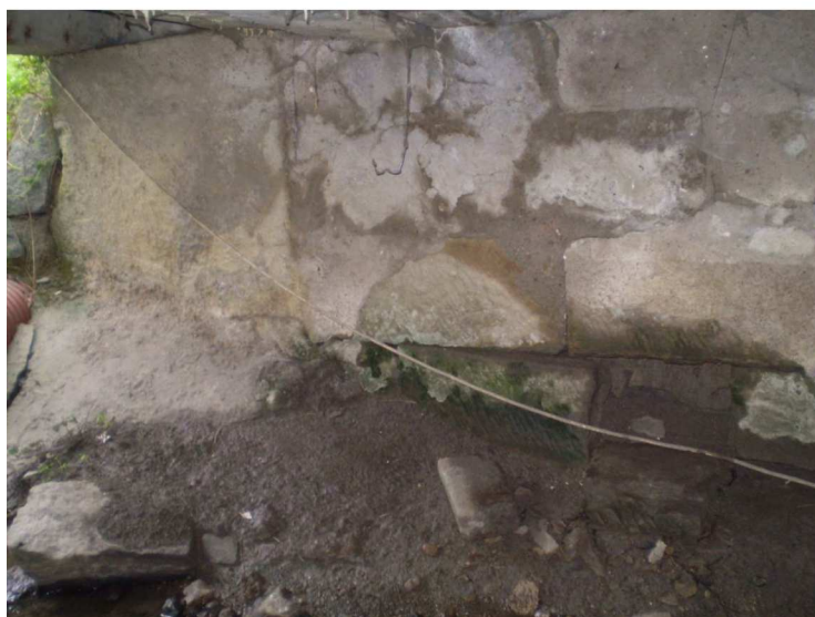
Levá strana opěry na konci mostu
