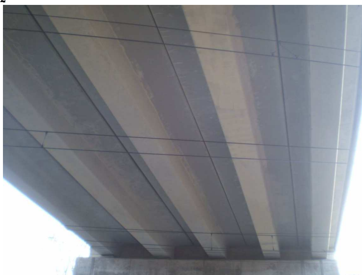
podhled nosné konstrukce u OP1
