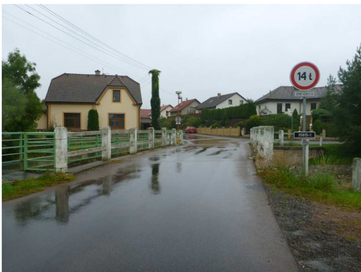
poškozené zábradlí na konci vlevo
