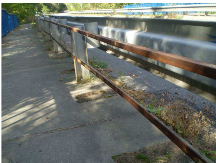
poškozený povrch levého chodníku na konci
