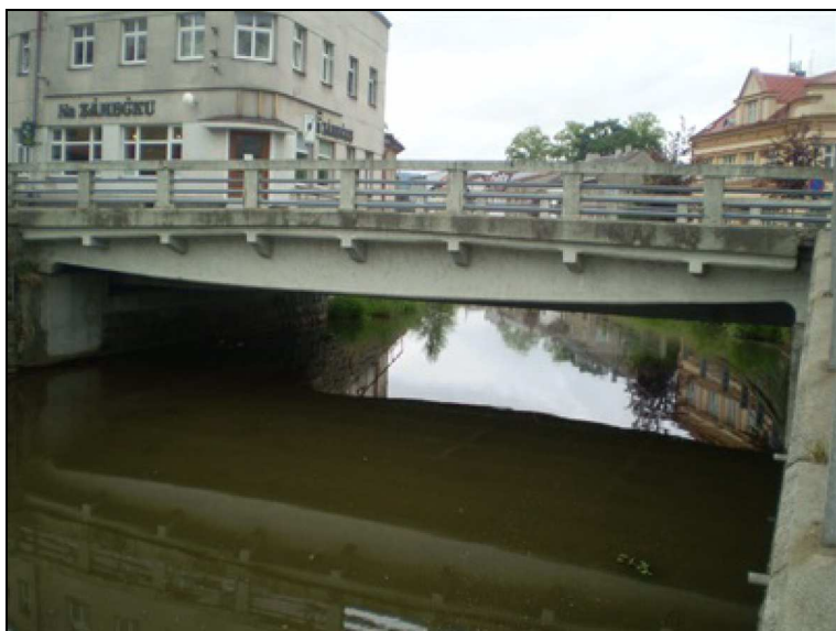
Levá strana mostu.JPG
