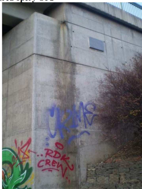
svislá trhlina š.0,4 mm cca uprostřed opěry OP2
