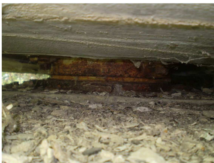
obnažené zkorodované třmínky vpravo v 1.poli
