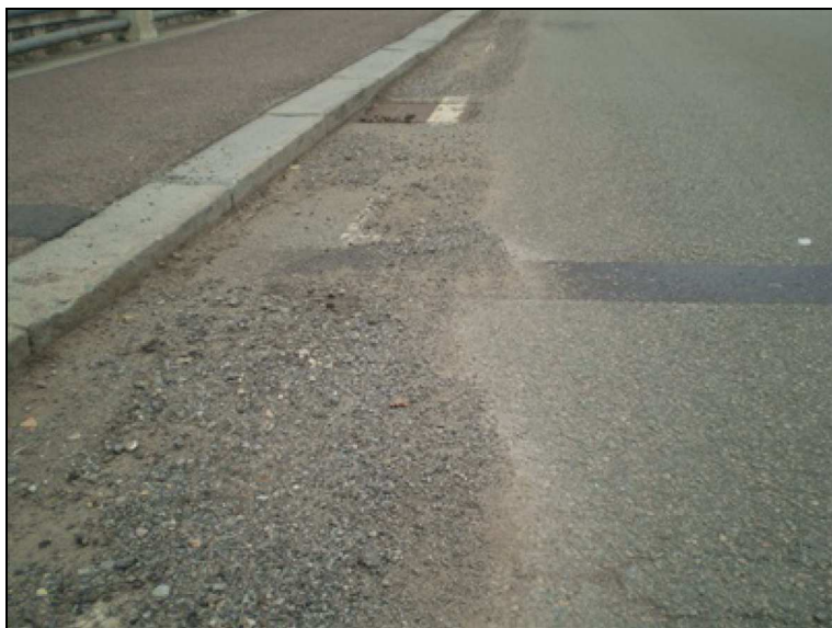
Vyjetý most.závěr na začátku mostu vlevo.JPG
