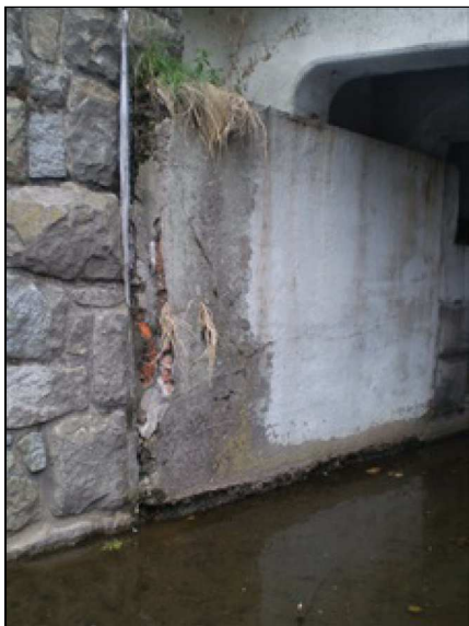
Levá strana opěry OP2.JPG
