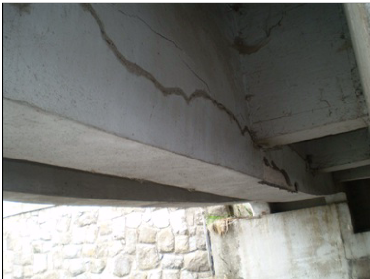
Podhled 2.trámu na konci.JPG
