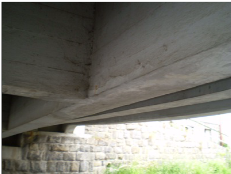
Vápenné výluhy uprostřed 7.trámu.JPG
