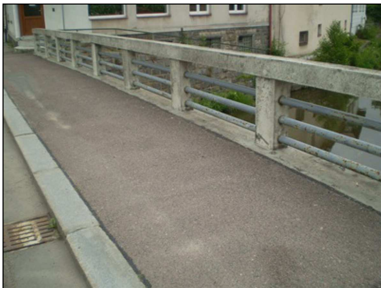
Trhlina v betonovém sloupku zábradlí vpravo.JPG
