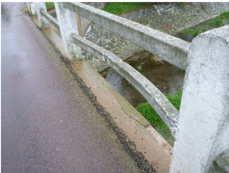
poškozené zábradlí na konci vlevo
