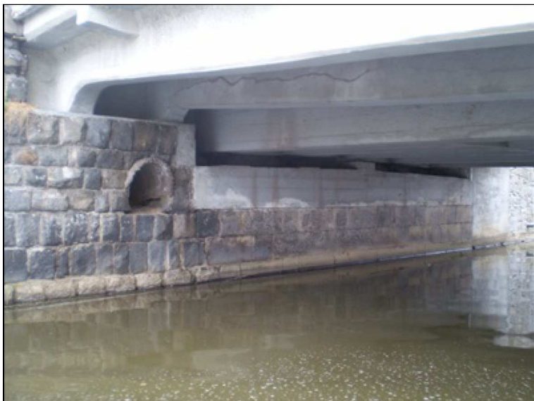
Opěra na začátku mostu OP1.JPG
