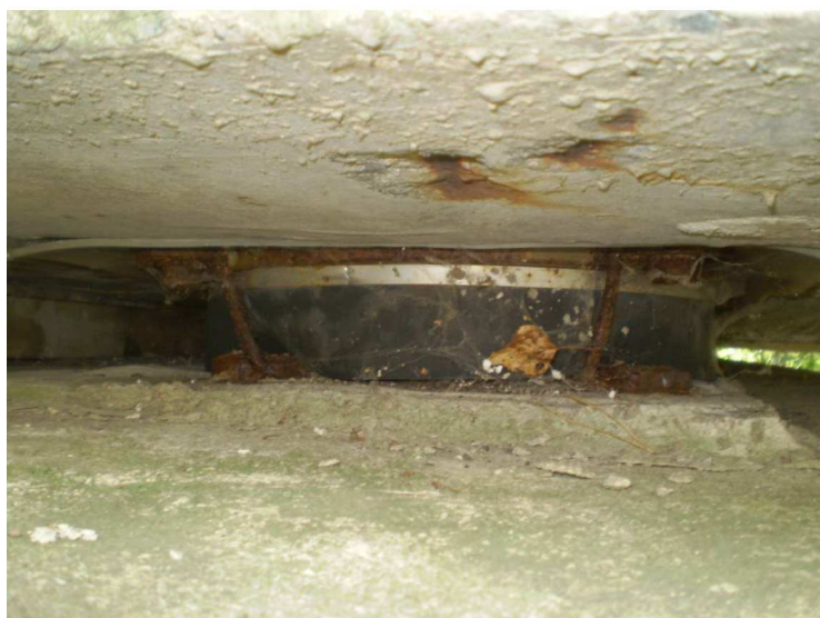
pravé krajní ložisko nad opěrou OP1
