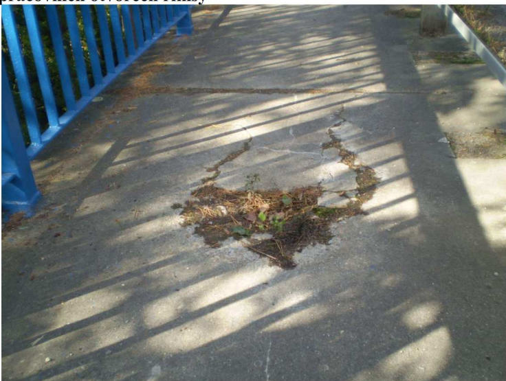
poškozený povrch levého chodníku na konci
