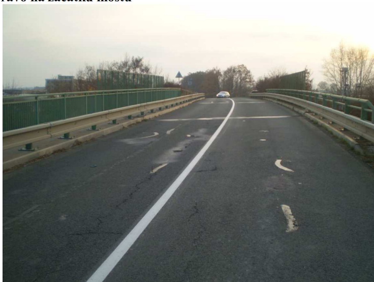
zarostlé schodiště vpravo na začátku mostu
