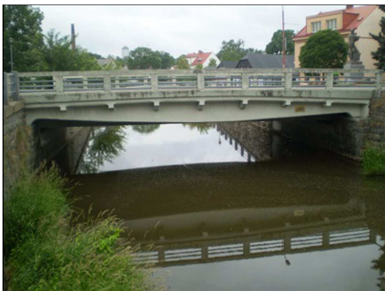
Pravá strana mostu.JPG
