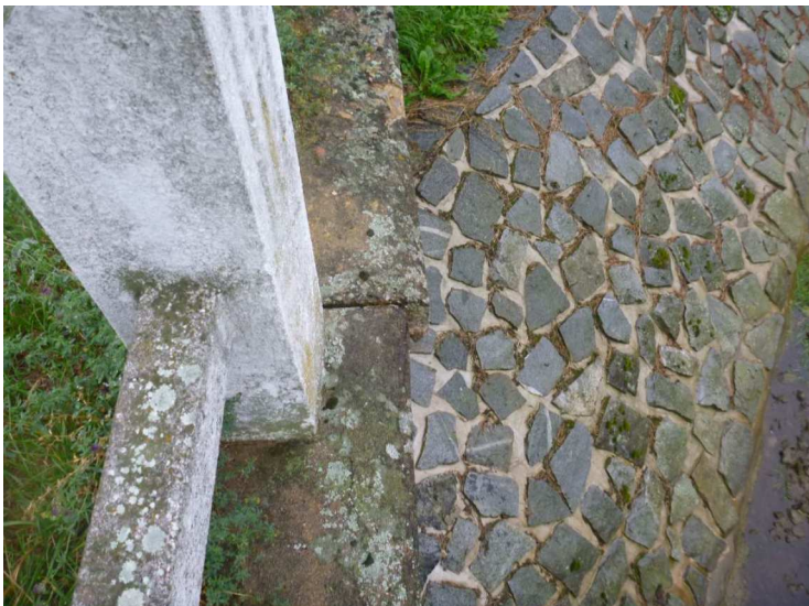
vysunutá římsa křídla na začátku vlevo
