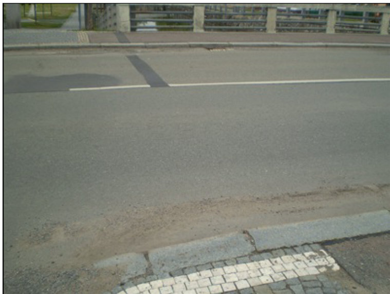
Mostní závěr na začátku mostu.JPG
