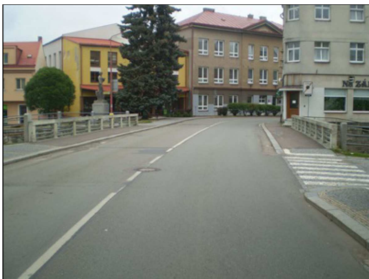
Pohled ve směru staničení.JPG
