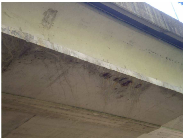
obnažené zkorodované třmínky vpravo v 1.poli
