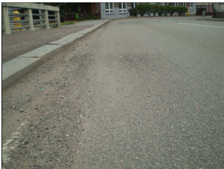
Vyjeté koleje u levého chodníku.JPG
