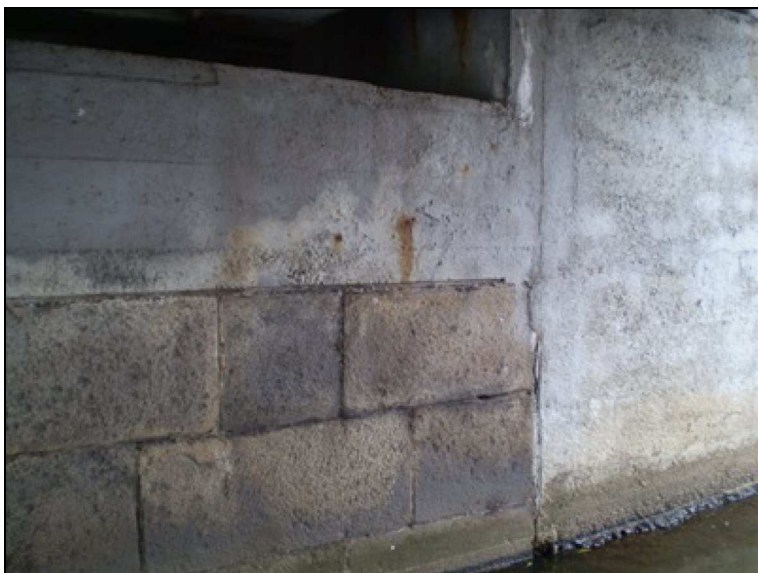
Levá strana opěry OP1.JPG
