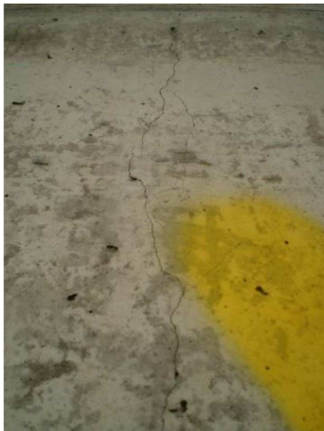
svislá trhlina š.0,4 mm cca uprostřed opěry OP2
