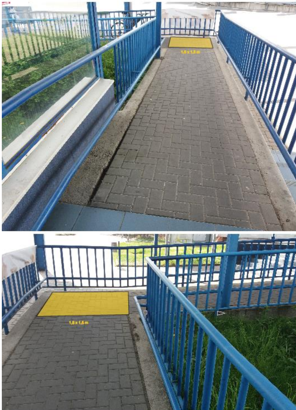
Obrázek 36 Rampa se upravenou podestou
