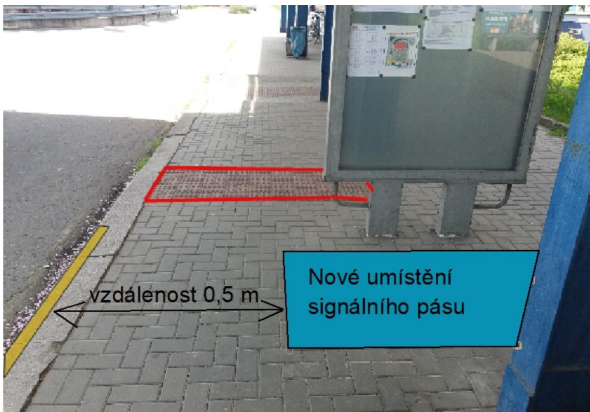
Obrázek 38 Úprava olomoucké autobusové zastávky
