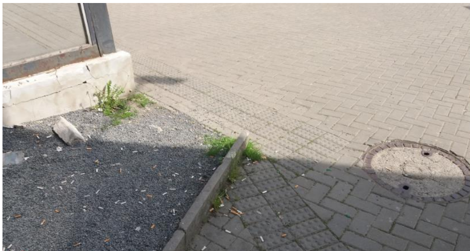
Obrázek 15 Vchod do podchodu
