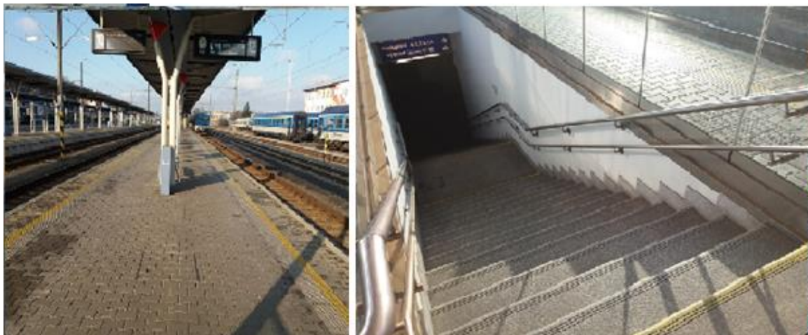
Obrázek 8 Ostrovní železniční nástupiště
