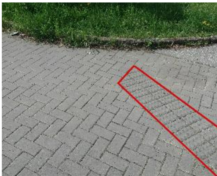
Obrázek 40 Chybná vodící linie
