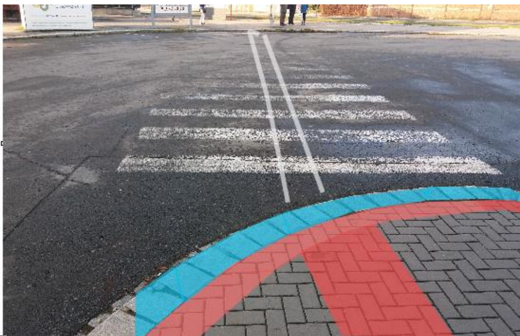
Obrázek 39 Úprava přechodu z ostrovního nástupiště
