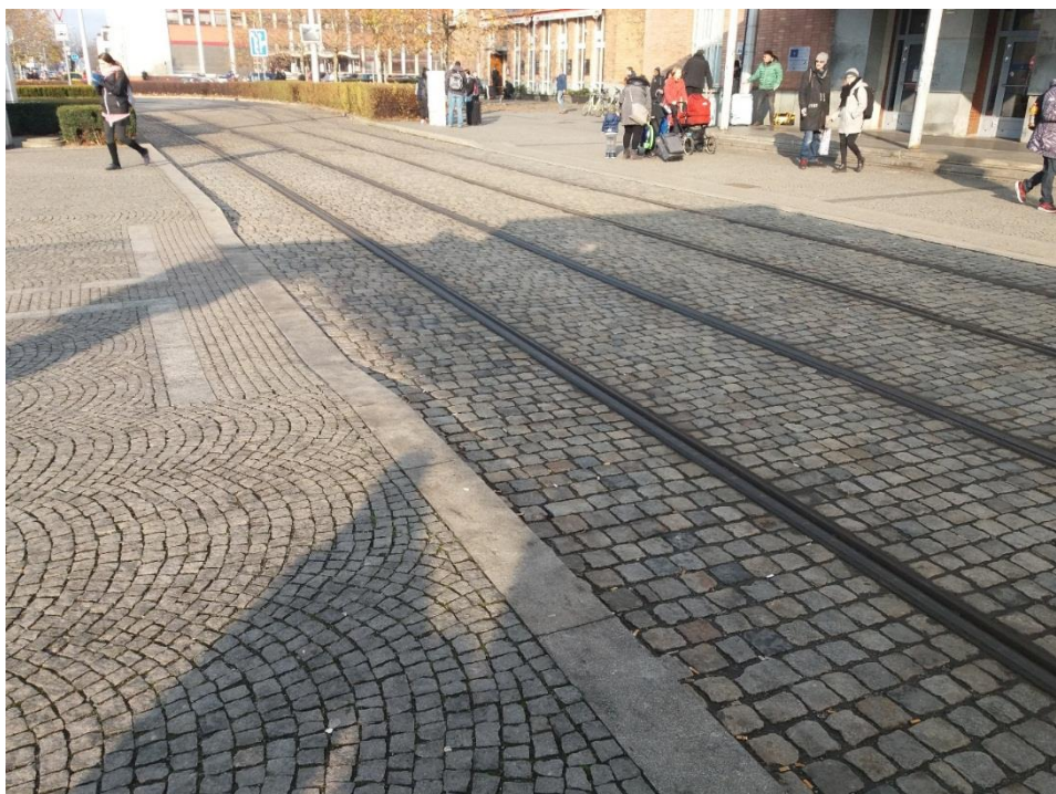
Obrázek 4 Koridor pro přecházení tramvajového pásu u nádražní budovy
