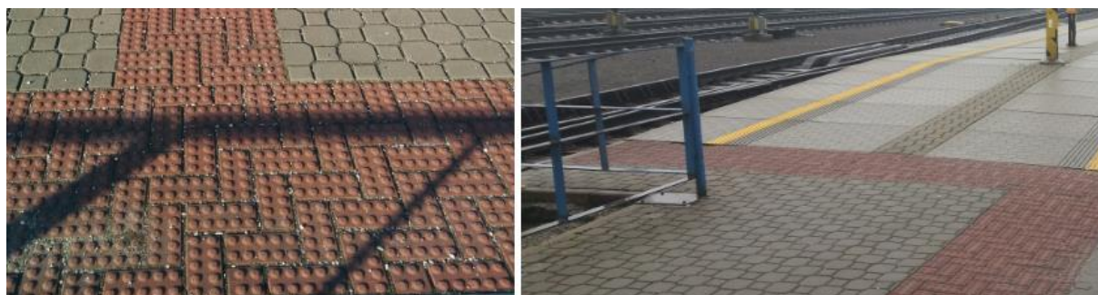
Obrázek 26 Signální pás na nástupišti
