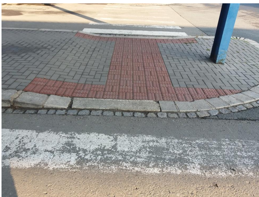
Obrázek 12 Snížený začátek nástupiště
