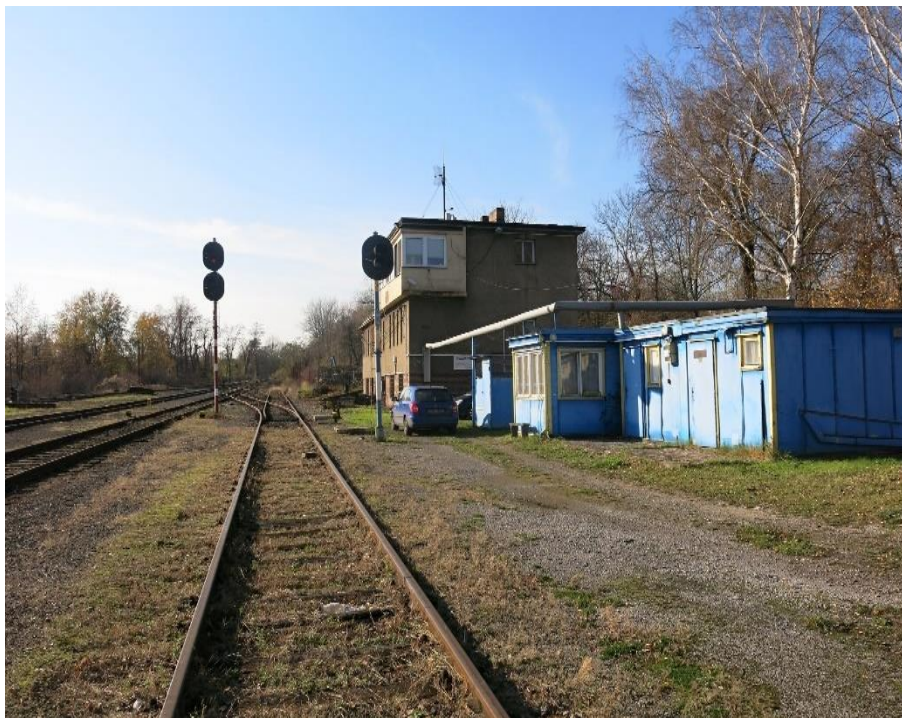
Obrázok 15: Bývalá staničná budova v žst Doubrava (autor, 2018)
