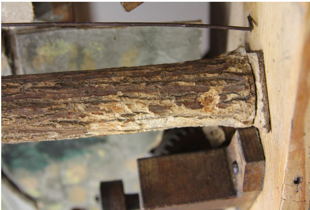
Obr. 43. Spodní část pumpy po tmelení pilinovým tmelem lepeným dispersním lepidlem na dřevo.
