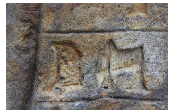
Obr. 41 – detail vysekané „značky“ odkryté při snímání tmelů
