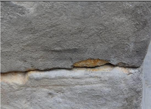
Obr. 13 - místo odlomení s odloupávající se zcelující povrchovou úpravou
