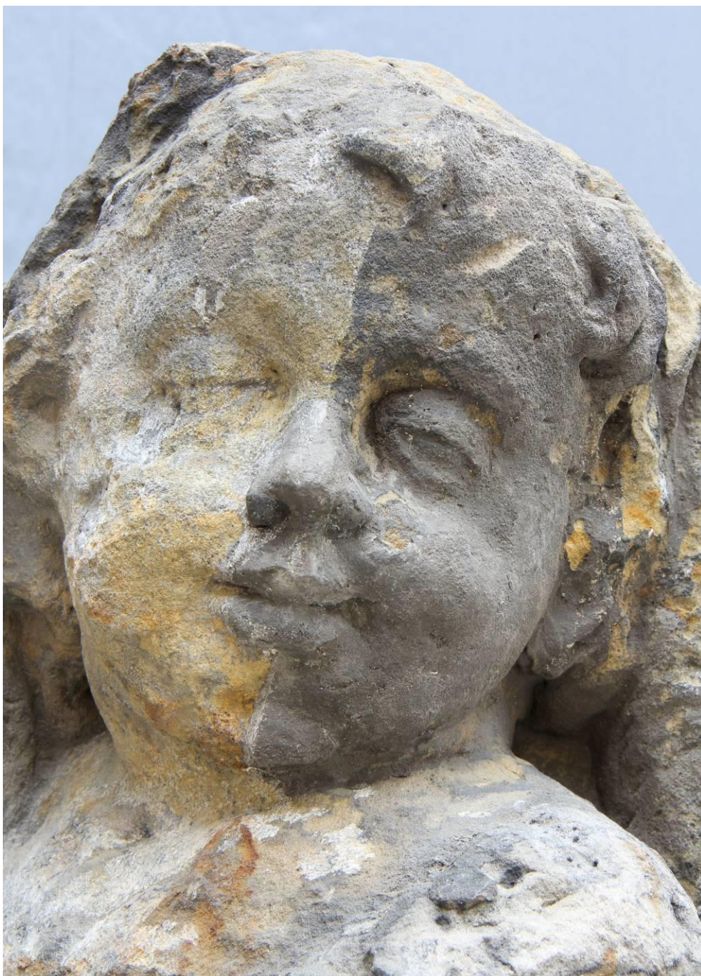
Obr. 48 - průběh snímání nevhodných tmelů
