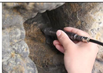
Obr. 35 -ukázka snímání tmelu pneumatickou tužkou
