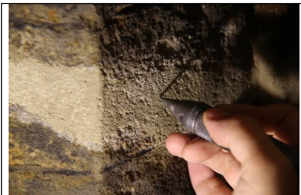
Obr. 40 - vytváření plastické struktury pomocí pneumatické tužky s využitím bočního světla
