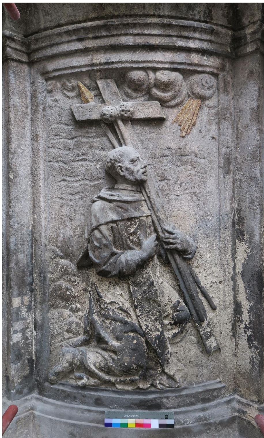
Obrázek 17 – Stav před restaurováním – celkový pohled
