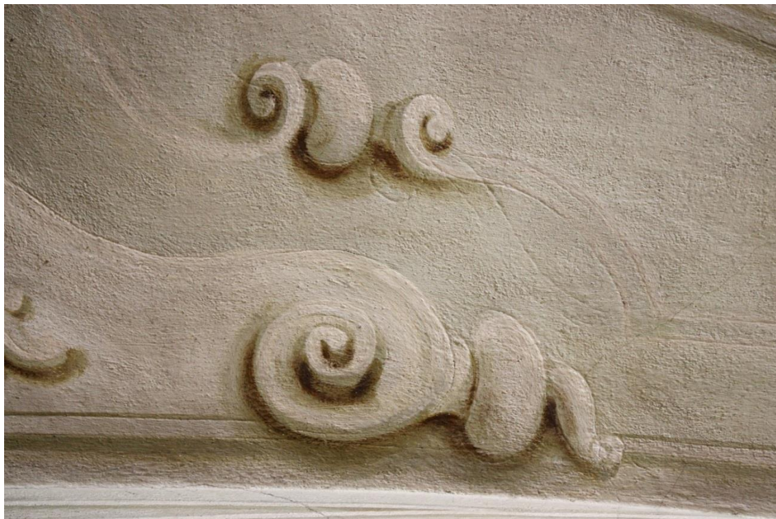
Obr. 16 J. Hager – rytá kresba. Detail nástěnné malby iluzivní architektury v kapli v kanovnickém domě Emanuela Arnošta z Valdštejna v Praze. Zdroj: autorka.
