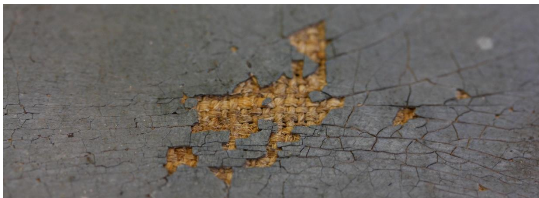
Obrázok 113 Detail drolenia farebnej vrstvy
