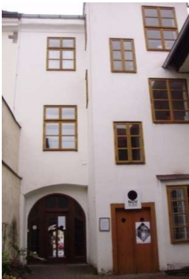
Fotografie č. 3: Dvorní pohled na schodišťový rizalit s hlavní budovu (Zdroj: Vlastní fotografie)
