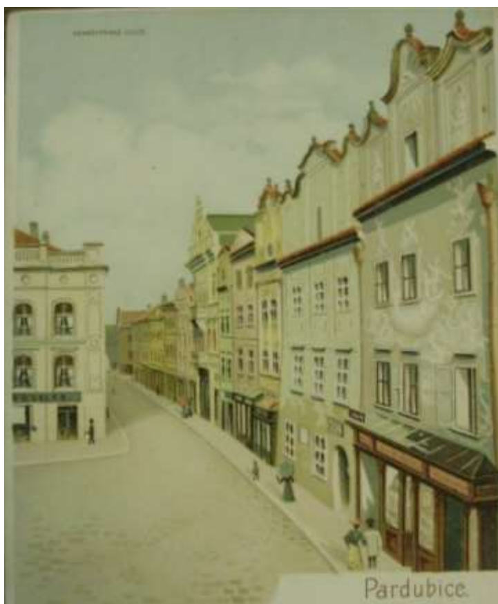
Kresba č. 2: Východní blok domů Pernštýnského náměstí, pohled od kostela (Zdroj: státní okresní archiv Pardubice)
