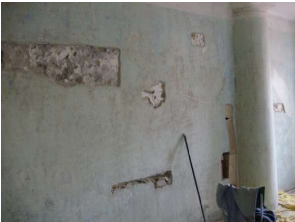
Fotografie č. 26: Detail jednotlivých sond v severovýchodní místnosti ve 3. Nadzemním podlaží (Zdroj: Vlastní fotografie)
