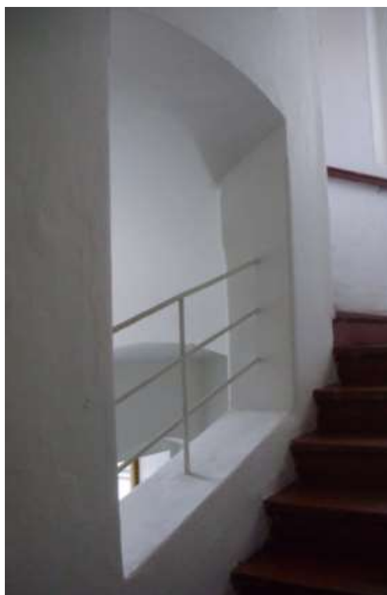
Fotografie č. 15: Výstup po schodišťové konstrukci do 3. Nadzemního podlaží (Zdroj: Vlastní fotografie)
