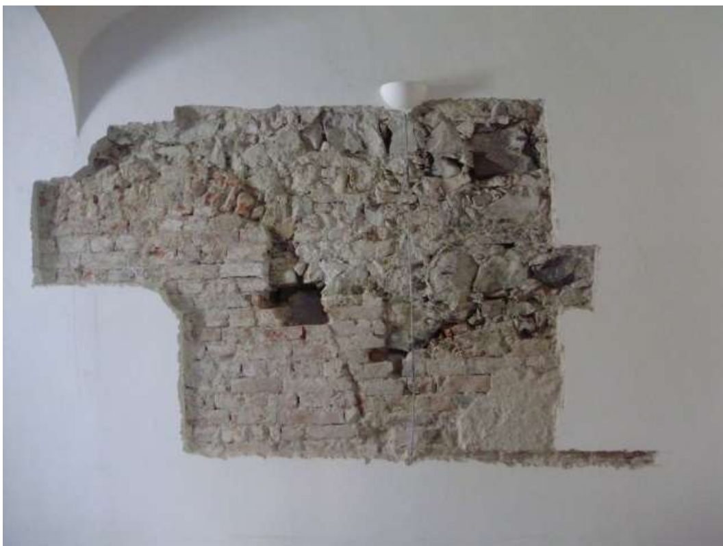
Fotografie č. 18: Detail odkryté omítky na spojovací stěně mezi čp. 49 a 50 v jihovýchodní místnosti ve 2. Nadzemním podlaží (Zdroj: Vlastní fotografie)
