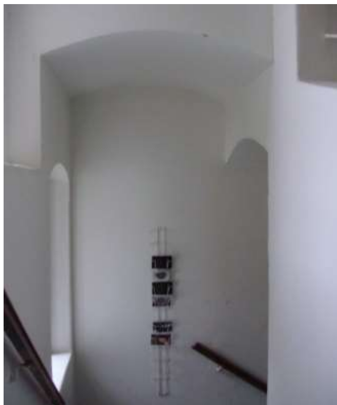
Fotografie č. 14: Zpětný pohled z mezi-podesty 2. Nadzemního podlaží na pohled schodišťové konstrukce (Zdroj: Vlastní fotografie)
