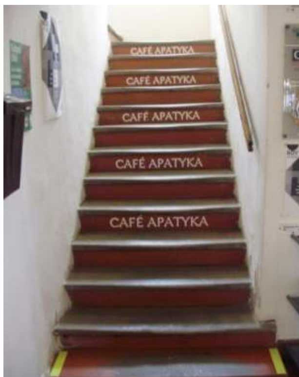
Fotografie č. 13: První schodišťové rameno, pohled z 1. Nadzemního podlaží (Zdroj: Vlastní fotografie)
