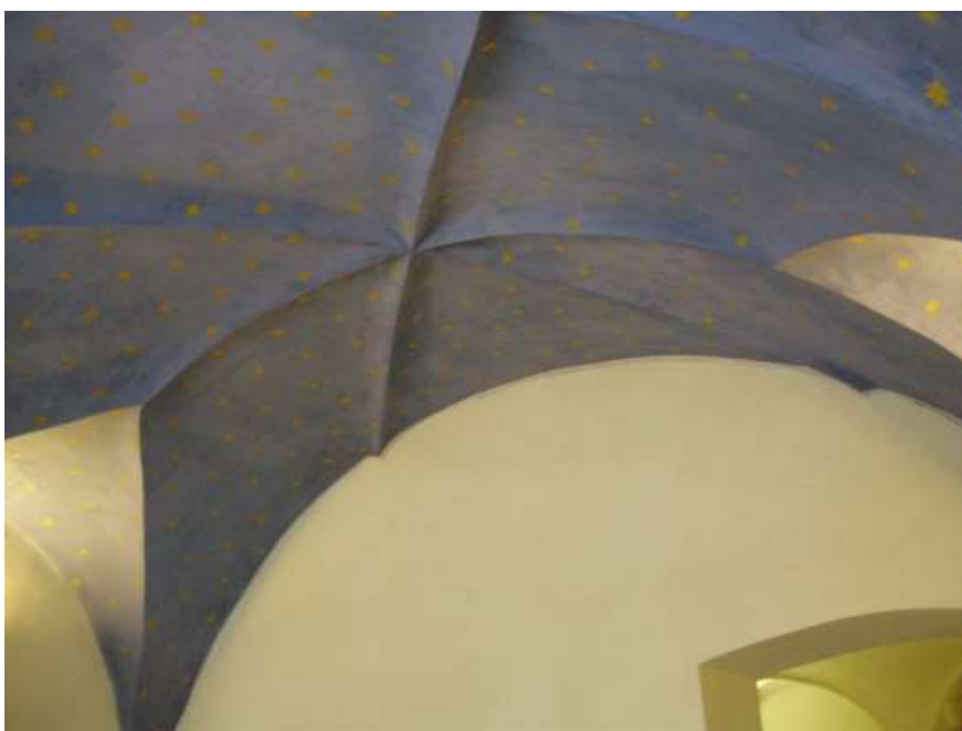
Fotografie č. 19: Severní místnost blíže k náměstí v 2. Nadzemní podlaží, pohled na klenbu (Zdroj: Vlastní fotografie)
