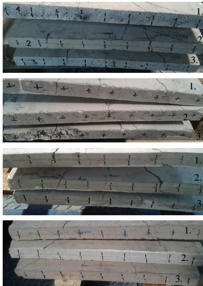
Obrázek 57. – Detail ukládání sítí a trhlin v deskách ROCKMESH
