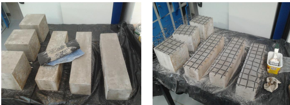
Obrázek 23. – Příprava povrchu na levé straně a lepení výztužné sítě na pravé straně
