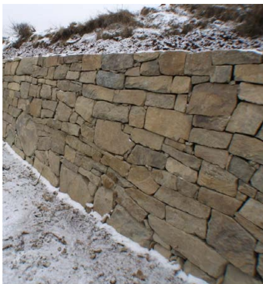
Obrázek 1: Pohled na líc skládané (suché) kamenné zdi
