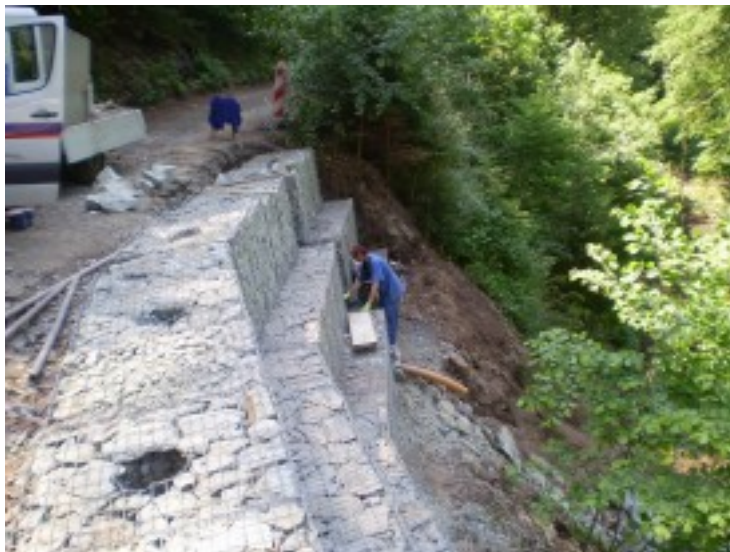
Obrázek 4: Pohled na postup provádění opěrné zdi z gabionů
