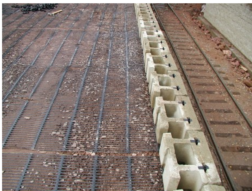
Obrázek 19: Aplikace geomříže v konstrukci opěrné stěny
