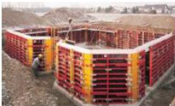
Obrázek 5 Rámové bednění DOMINO[1]
