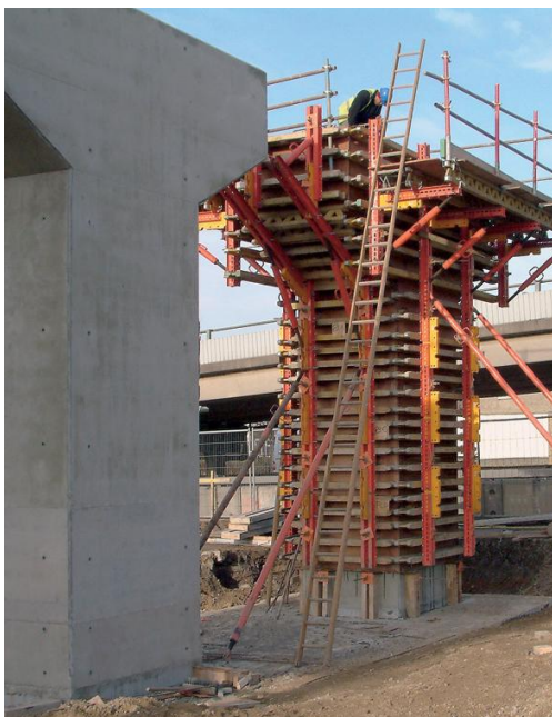
Obrázek 16 Bednění pilíře[3]
