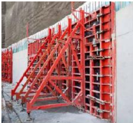
Obrázek 1 Zachycení vodorovných sil u jednostranného bednění[1]
