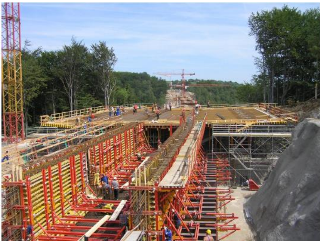
Obrázek 21 Vysouvání po segmentech[3]
