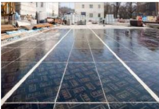
Obrázek 12 Stropní panelové bednění PERI SKYDECK[1]
