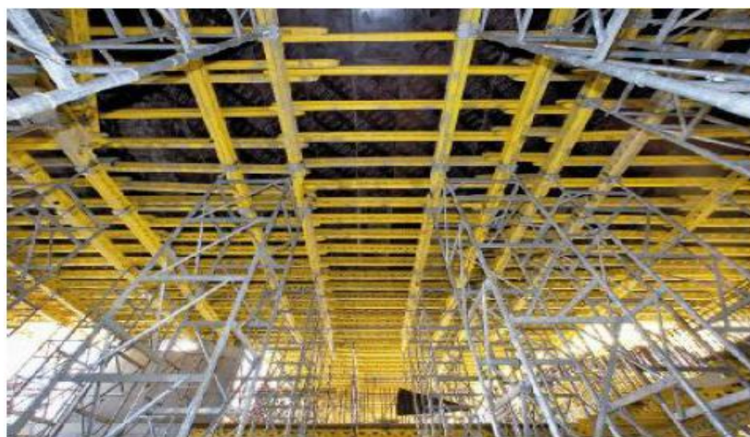
Obrázek 10 Stropní nosníkové bednění MULTIFLEX[1]
