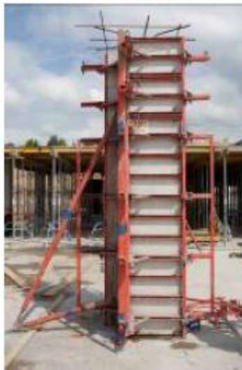
Obrázek 9 Sloupové bednění[1]
