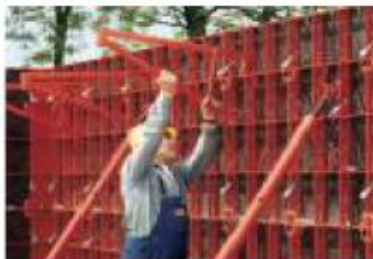
Obrázek 6 Ruční bednění HANDSET[1]
