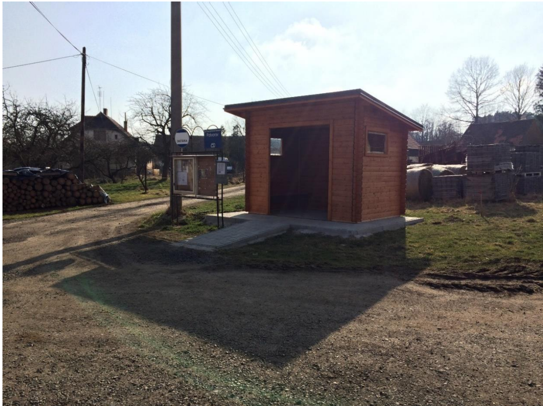
Obr. 12 Autobusová zastávka Žihle, Přehořov
