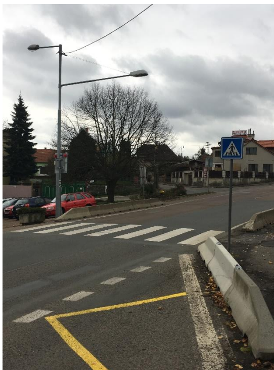
Obrázek 6 - Betonová svodidla na řešené křižovatce
