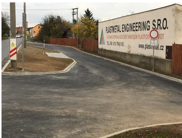
Obrázek 2 - Místo pro kontrolní vážení vozidel – Chrást
