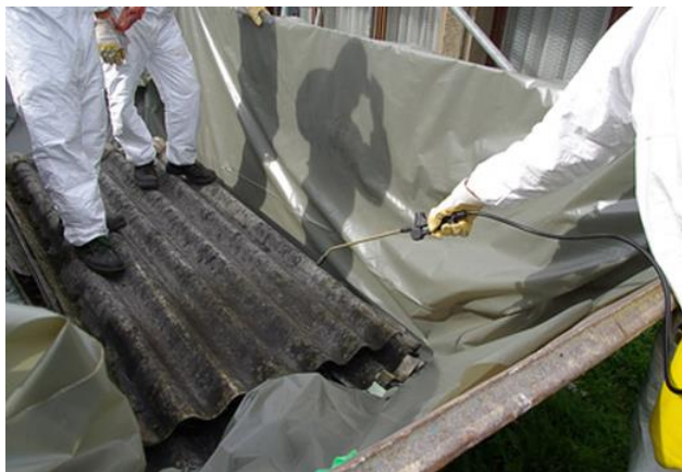
Obrázek 17 Nakládka volně loženého azbestu
