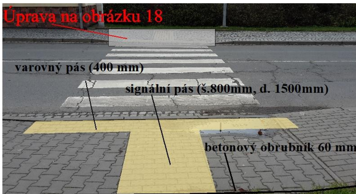
Obrázek 17 Přechod č. 6 - bližší strana
