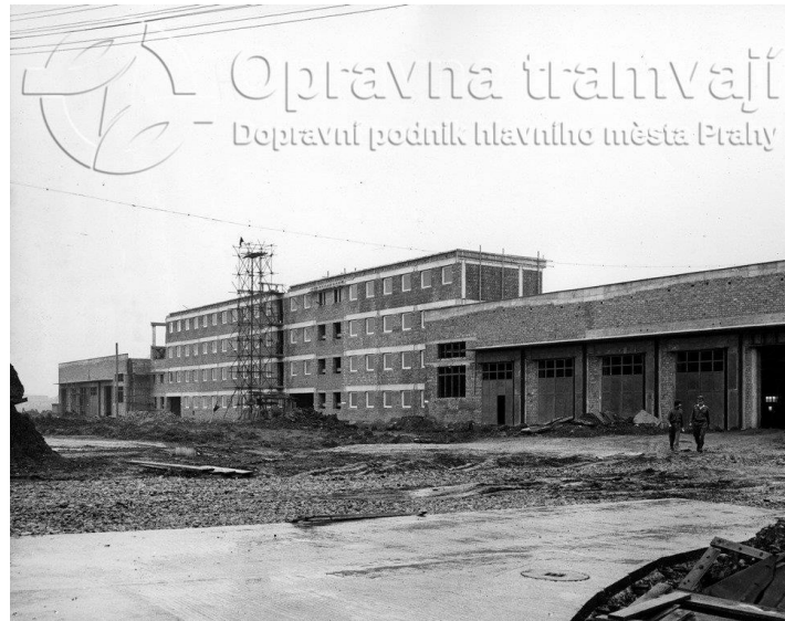
Obrázek 1- Výstavba Opravny tramvají z roku 1966
