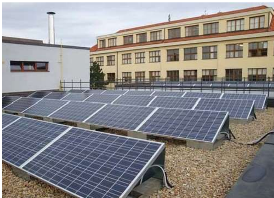
Obr. 9 Instalace solárních panelů na rovné střeše
