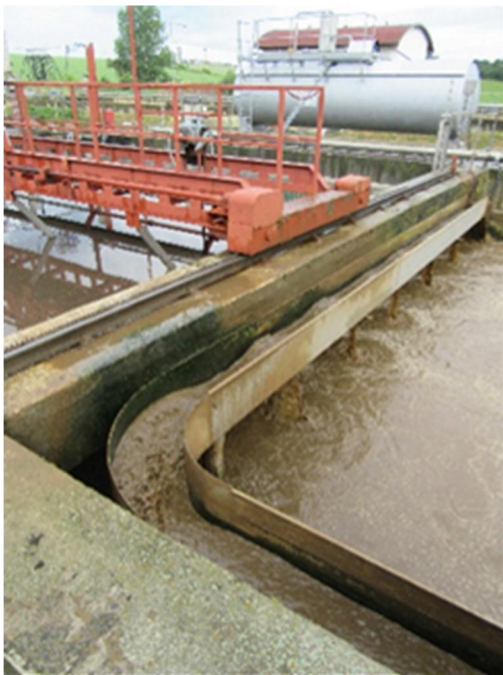
Obr. 8: Usazovací nádrž – odtékající kal se usazuje na dno
