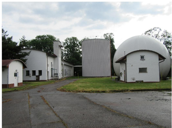
Obr. 6: Vyhňovací nádrž (uprostřed) a plynojem (vpravo)
