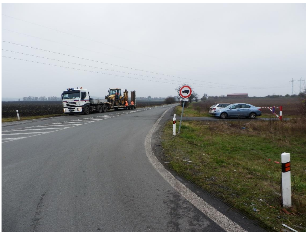
Obrázek 20: Větev 4 – pohled směr Bašť
