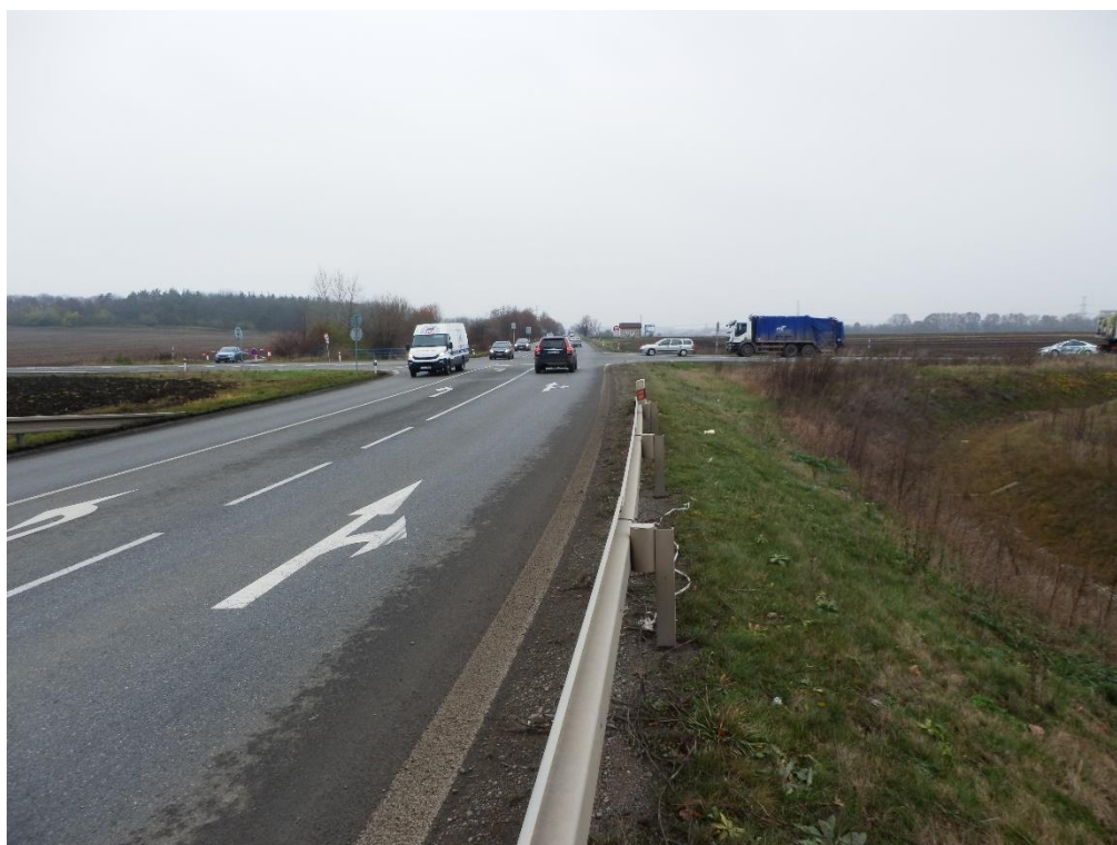
Obrázek 5: Větev 1 – pohled směr Mělník
