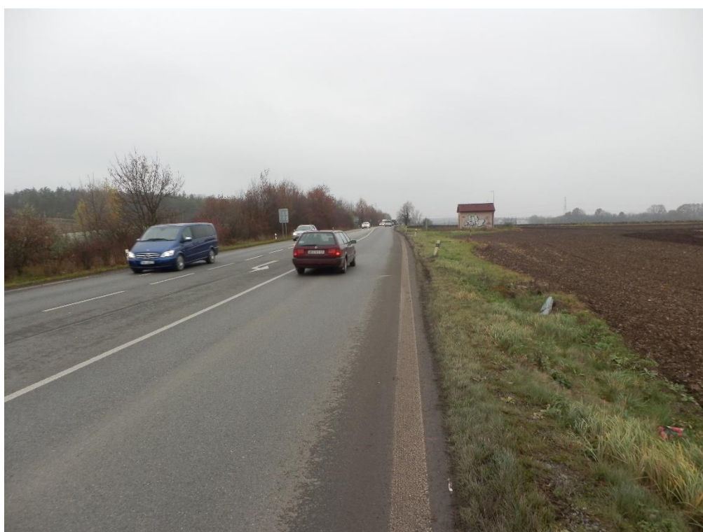
Obrázek 13: Větev 3 – pohled směr Mělník
