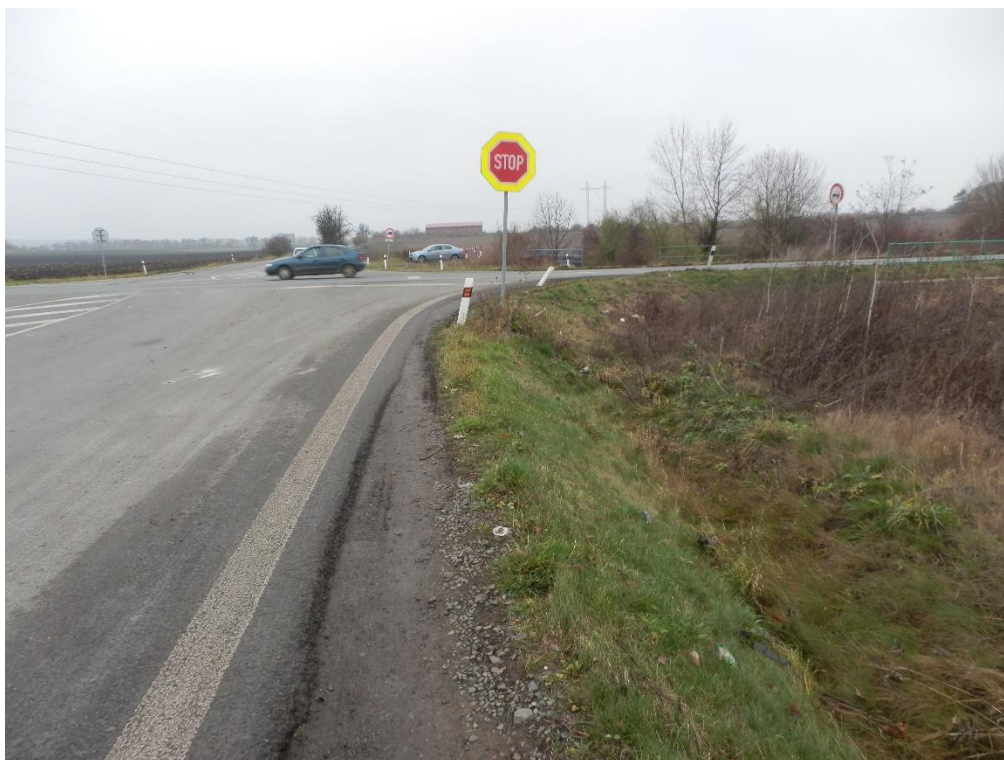
Obrázek 11: Větev 2 – pohled směr Bašť
