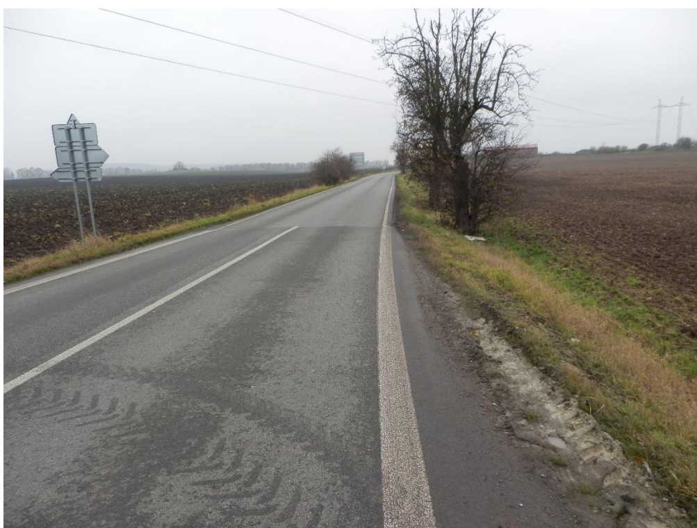
Obrázek 21: Větev 4 – pohled směr Bašť
