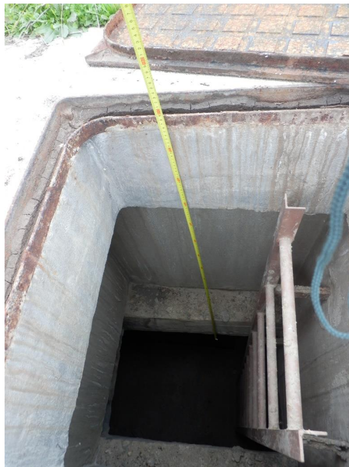
Obrázek 19: Kolektor – pohled do kontrolní šachty
