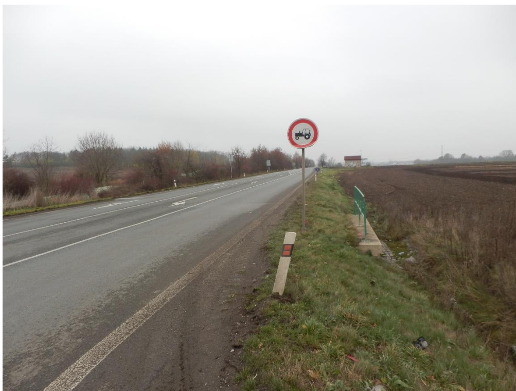
Obrázek 12: Větev 3 – pohled směr Mělník
