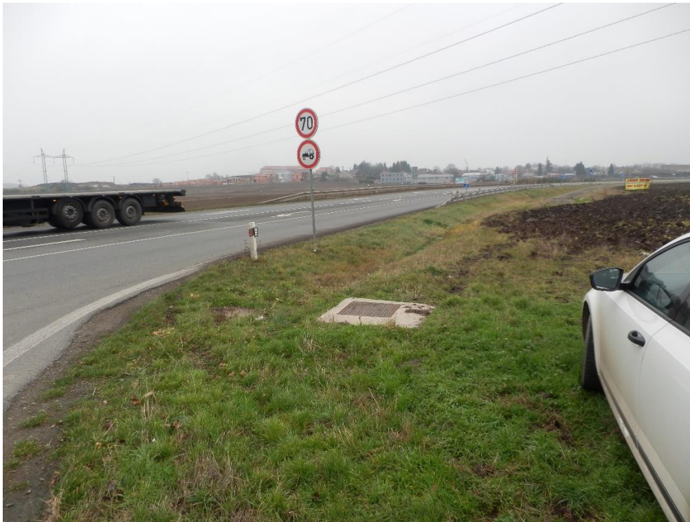
Obrázek 18: Kolektor – kontrolní šachta
