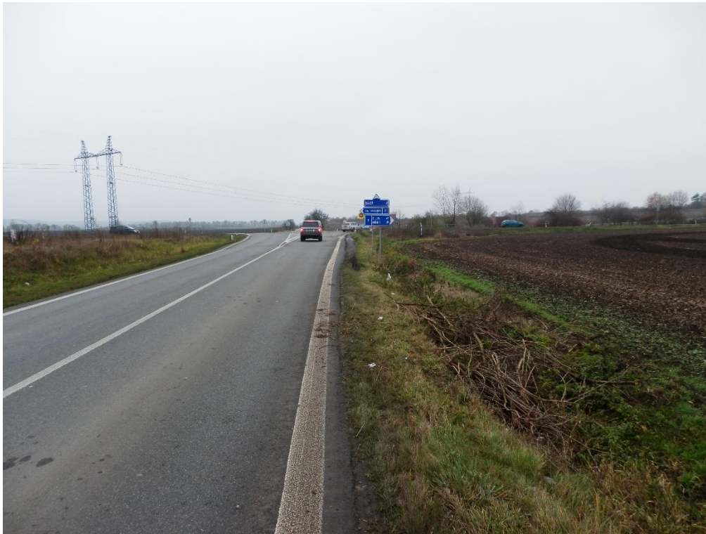
Obrázek 10: Větev 2 – pohled směr Bašť
