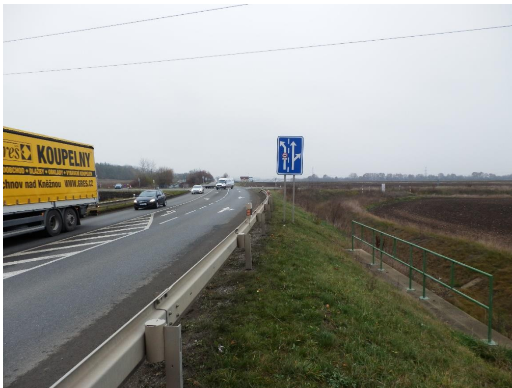
Obrázek 4: Větev 1 – pohled směr Mělník
