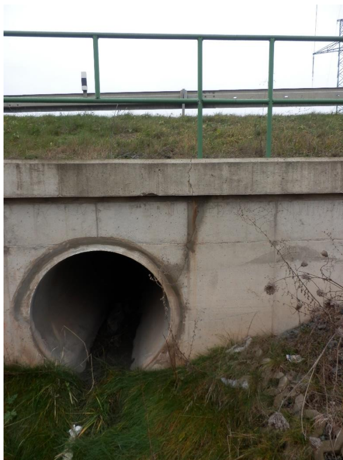
Obrázek 8: Větev 1 – čelo propustku
