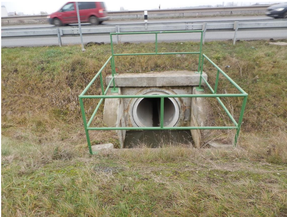
Obrázek 6: Větev 1 – vtoková jímka velká
