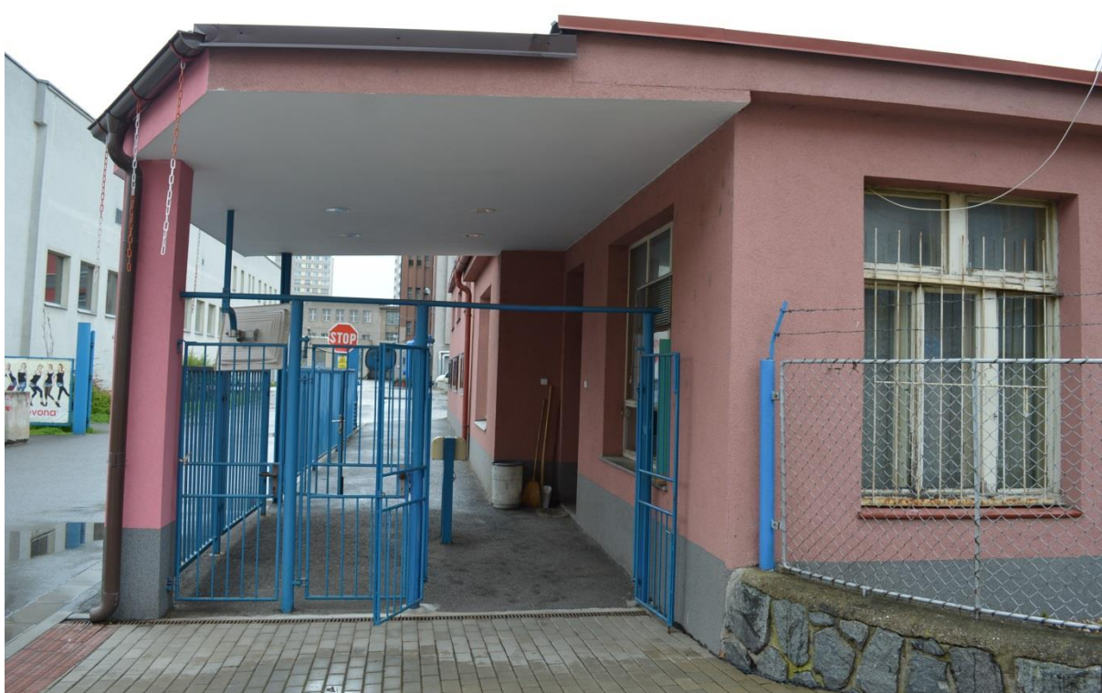
Příloha č. 8: Dnešní vrátnice a příjezdová cesta do podniku Evona Chrudim
