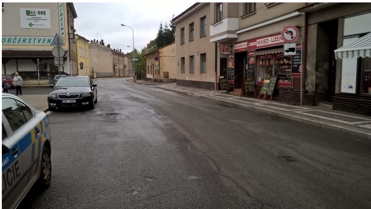
Obr. 11 – Pohled na konec úseku v ul. Regnerova, ve směru staničení.
