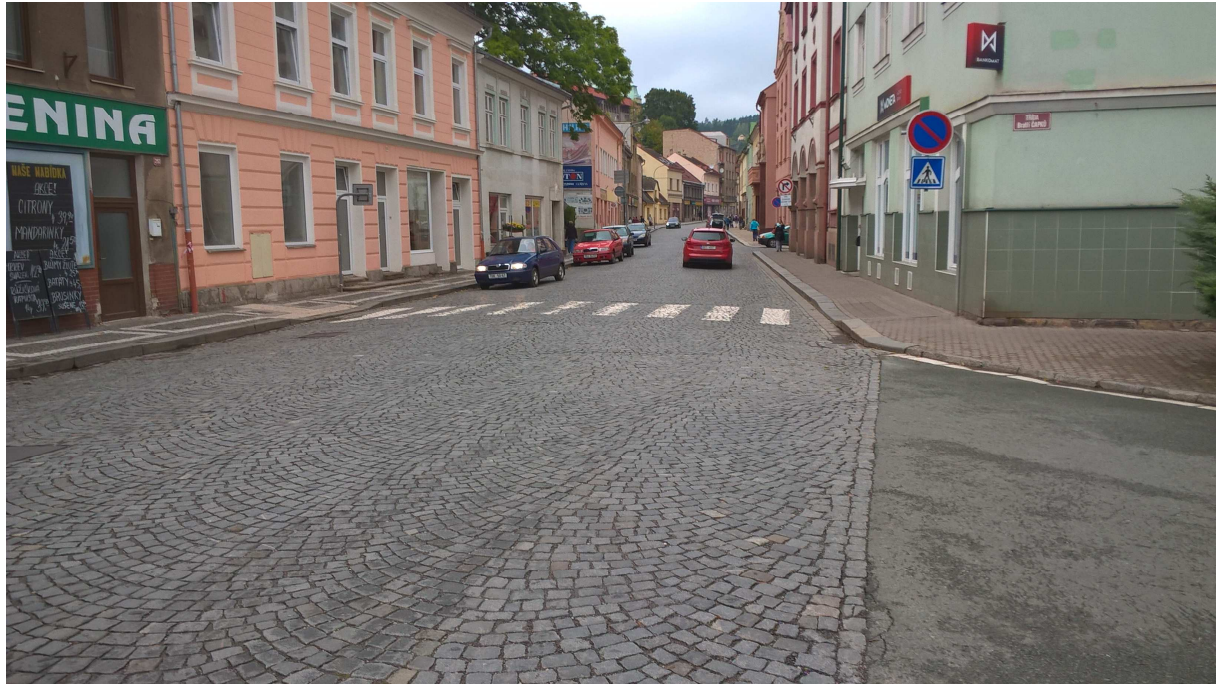
Obr. 10 – Pohled na stávající přechod pro chodce v ul. Pod Městem proti směru staničení, který se nachází u křižovatky s ul. Bratří Čapků. Tento přechod zůstane zachován, ale bude zmenšena délka přecházení, jelikož dojde k zúžení hlavního dopravního prostoru a tím k rozšíření prostoru přídružného.
