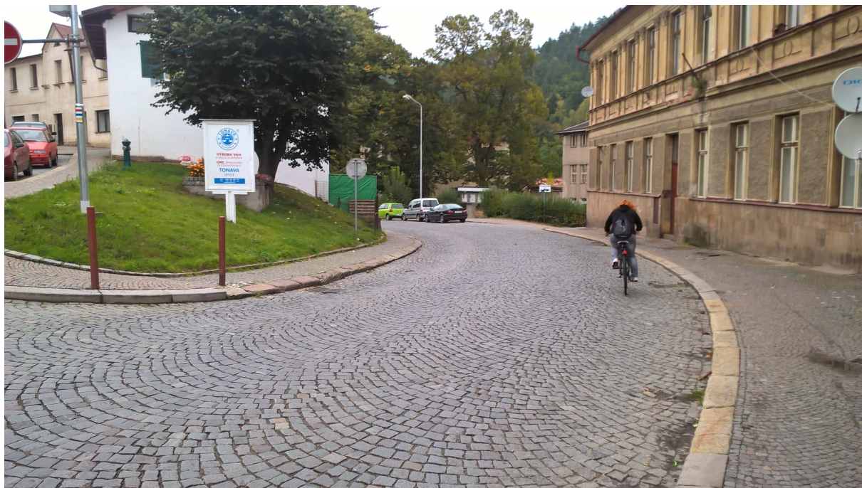
Obr. 5 – Pohled do míst ve směrovém obluku číslo 3, proti směru staničení. Zde dojde k rozšíření vozovky a úpravě přílehlého přídružného prostoru.
