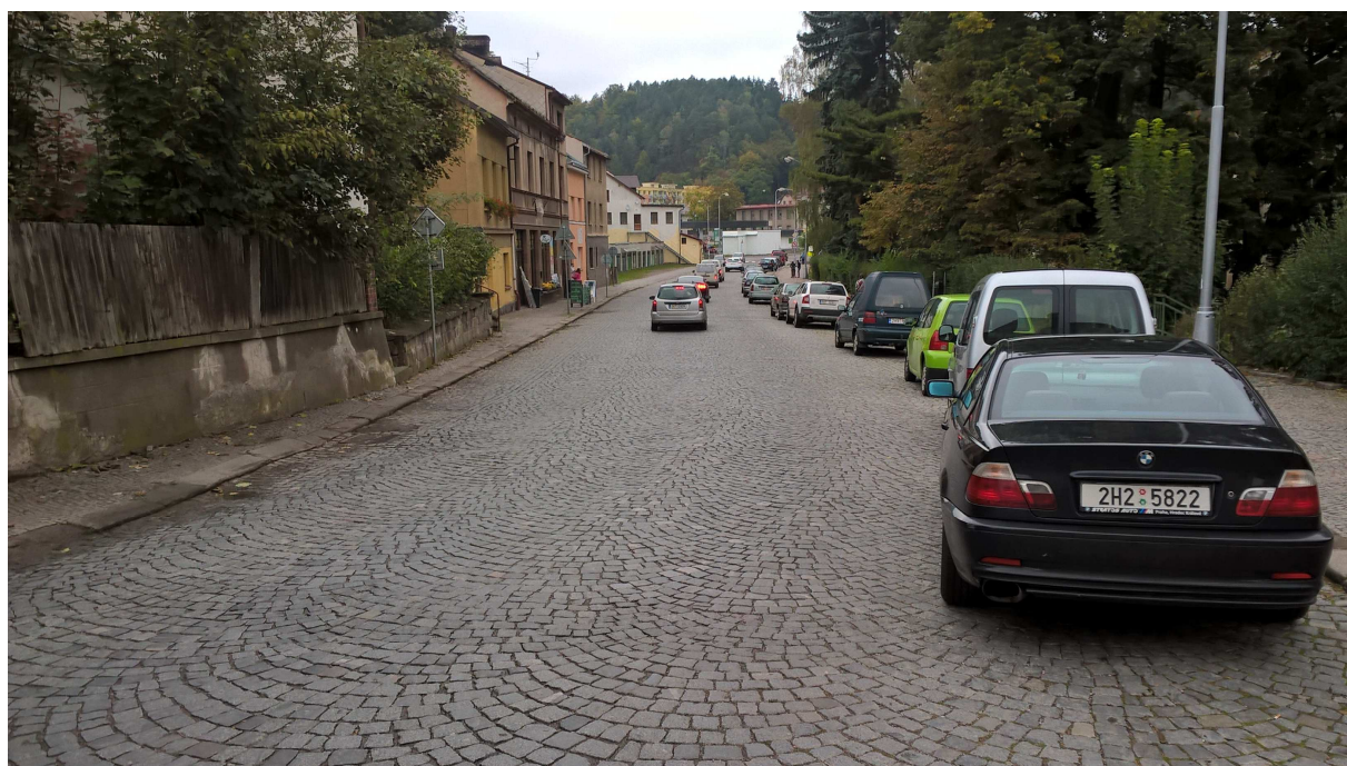
Obr. 4 – Celkový pohled na ul. Dr. A. Hejny proti směru staničení. V místech parkujících automobilů po pravé straně bude nově vytvořen, v celé délce ulice, parkovací pruh / záliv.
