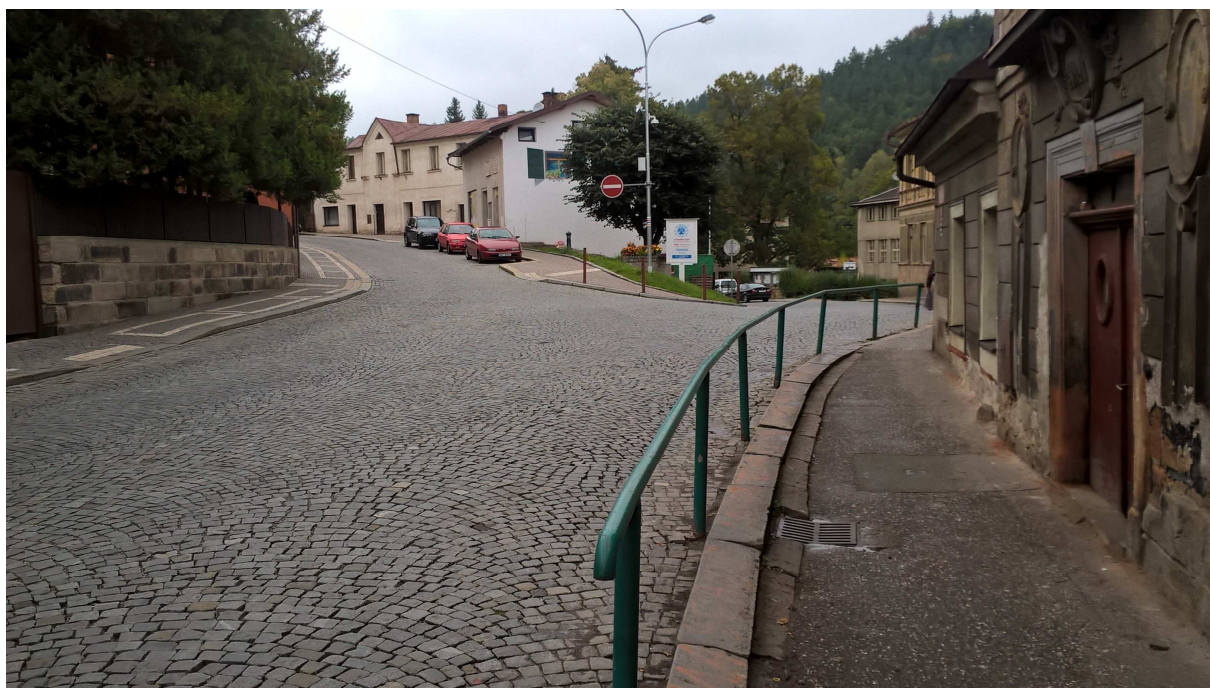
Obr. 6 – Pohled (proti směru staničení) do místa kde se na silnici II/304 napojuje místní komunikace ul. Dr. E. Beneše. V těchto místech je navržena úprava nároží křižovatky.
