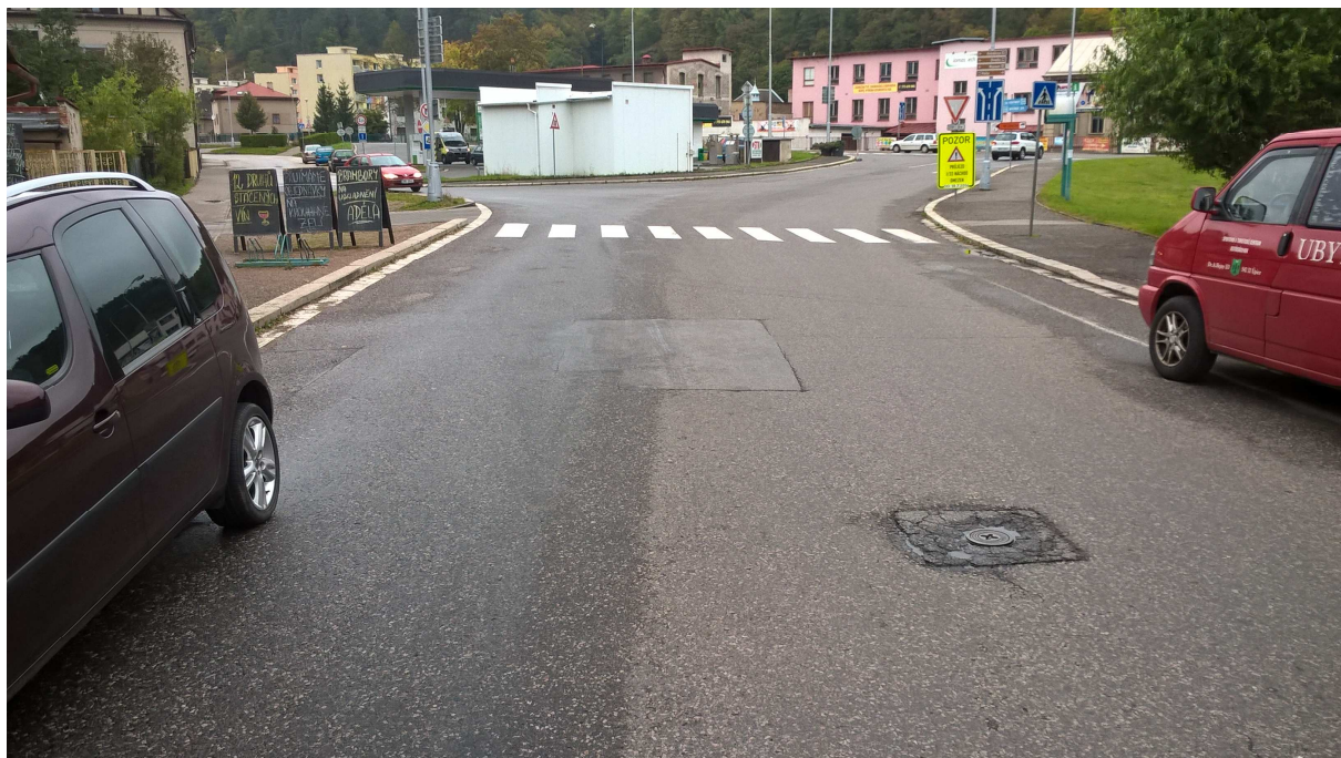
Obr. 1 - Pohled na začátek úseku ul. Dr. A. Hejny proti směru staničení.
