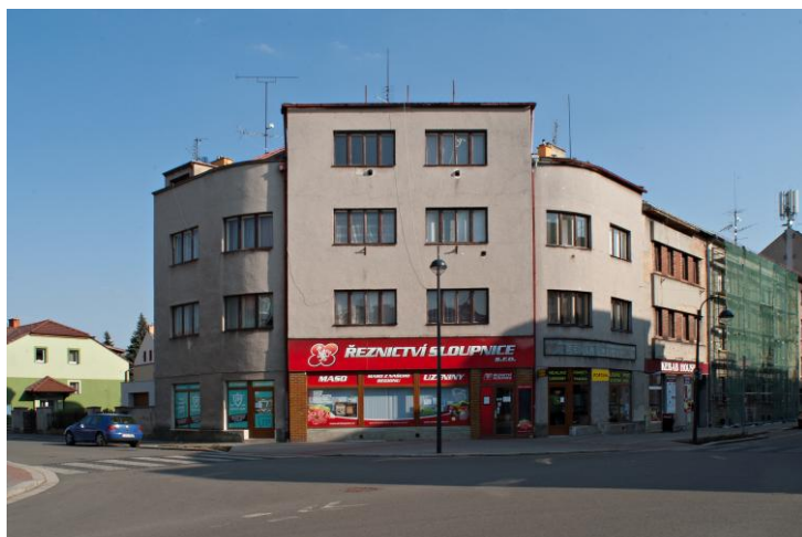
160. Obchodní dům s byty, Kollárova 934, Choceň. 1968. Foto: Martina Novozámská.
