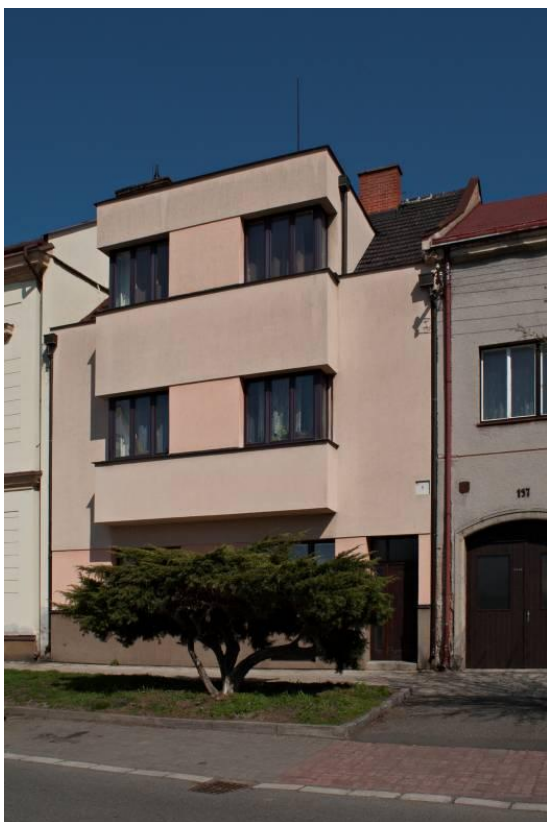
40. Bytový dům, Záměstí 158, Choceň. 1932. Foto: Martina Novozámská.
