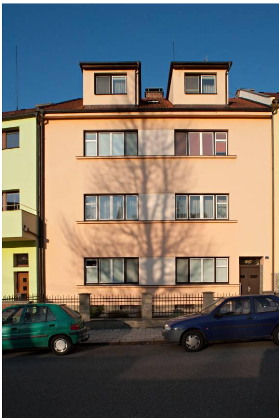
119. Bytový dům, Krawcova 1057, Choceň. 1936. Foto: Martina Novozámská.
