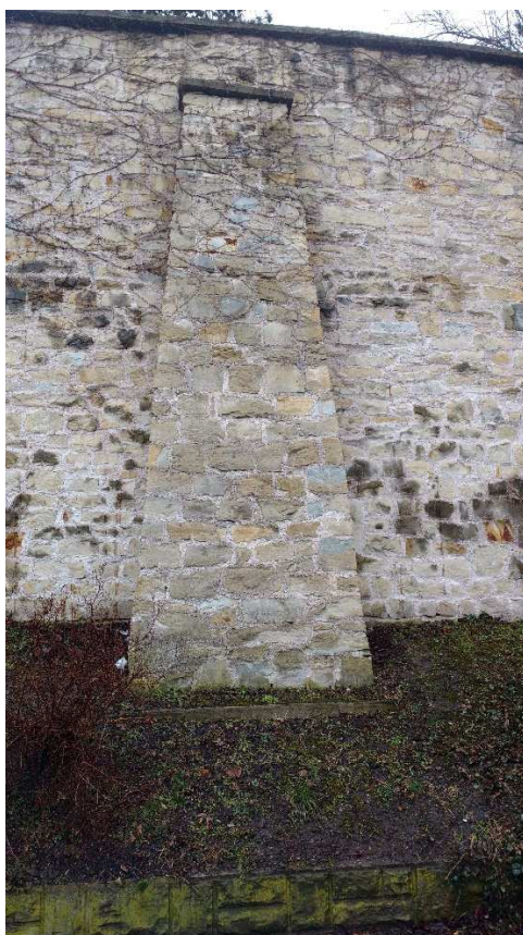
Obrázek 14 Pohled na líc parkánové zdi (opěrný pilíř). Stav v roce 2017.
