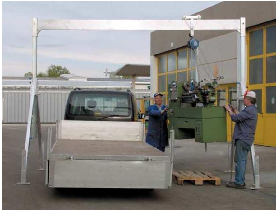
Obrázek 1.3 – Příklad využití mobilního portálového jeřábu
