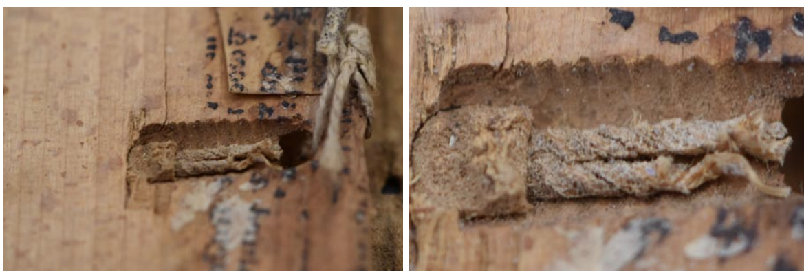
Obr.108 Viditelné rýhy po úzkém profilovaném dlátu (XIX.G.β.2)
