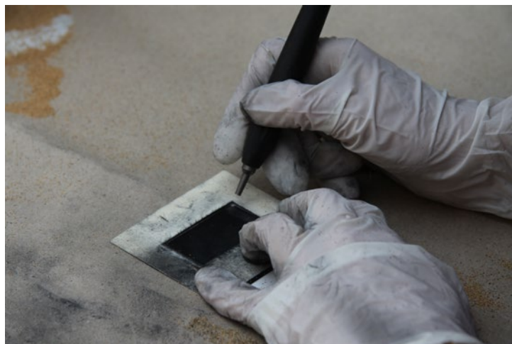
obr. č. 24 – Čistenie mikropieskovačkou
