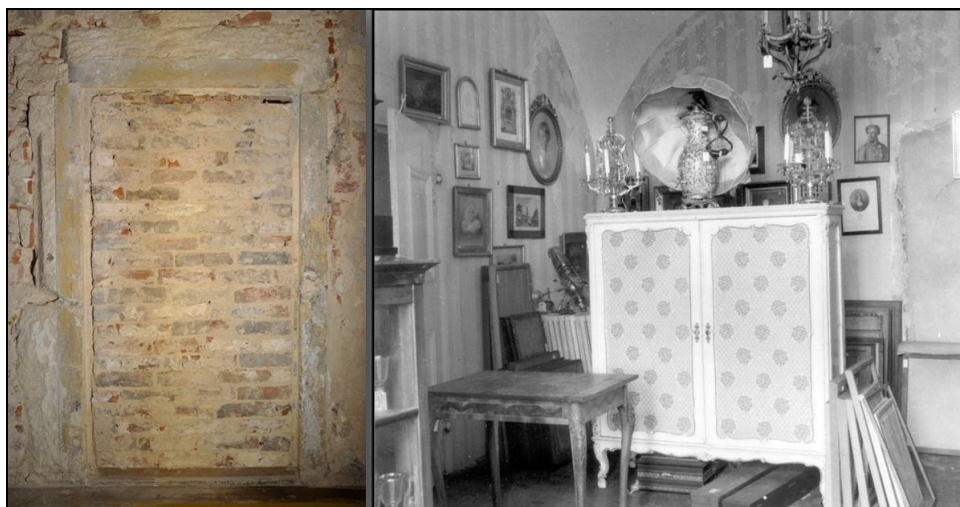
Obrázek 5 – vlevo čelní pohled na zazděný vchod na východní stěně, vpravo pohled do místnosti z roku 1958 (Vl. Fyman).
