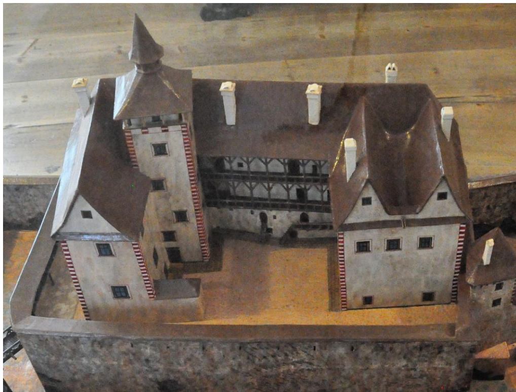
Obrázek 37 b – rekonstrukce podoby zámku po polovině 16. století, nádvorní fasáda se systémem pavlačí, M 1:100 (J. Štětina).
