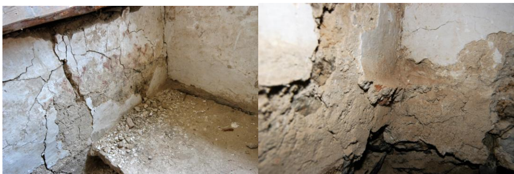
Obrázek 36 – pohled do JZ koutu sondy. Vlevo stav před částečným odstraněním maltové podlahy, vpravo patrný systém opravné omítky složený ze spodního jádra a vrchní tenké omítky s reliktem maltového náběhu podlahy.
