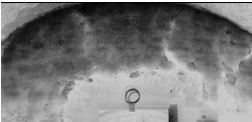
Obrázek 11 – analýza a vizualizace vnitřní skladby a struktury zdiva severní stěny na negativu termogramu. Patrné jsou vrstvy rozměrově nevytřídněného lomového kamene se střídáním vodorovných řádků vzájemně provázaných maltovou směsí, negativ snímku (ÚTAM AV ČR, 2017).
