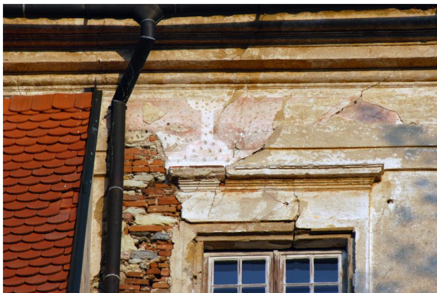
Obrázek 30 – sonda na západním průčelí odhalující fragment malované barokní fasády (malovaný lizénový vlys v růžovo-bílé barevné kombinaci).
