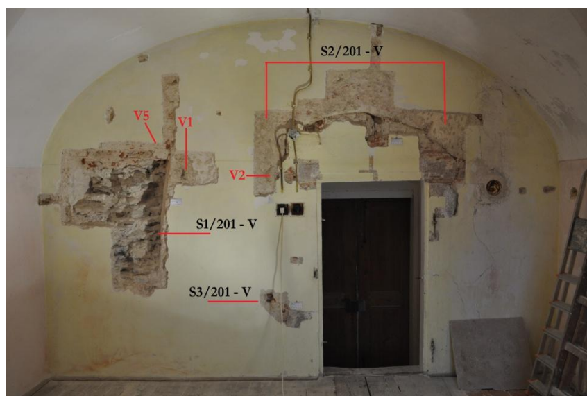
Obrázek 39 – čelní pohled na východní stěnu místnosti 201 s odkrytým záklenkem vstupního otvoru (sonda S2 vpravo) a špalety okenního otvoru (sonda S1 vlevo) z 2. poloviny 13. století a lokalizací sond a odebraných vzorků.
