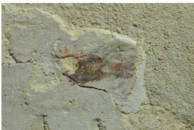
Obrázky 7, 8 – ukázka tmelení okrajů omítek na západní stěně.
