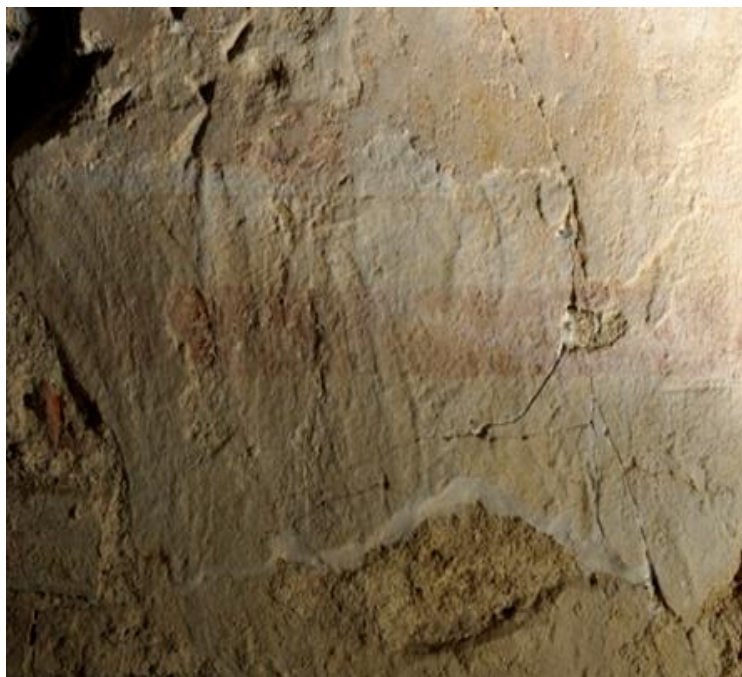
Obrázek 68 – spodní úsek malby na severní stěně v boční světle s patrným rozhraním obou gotických omítek (OM I. a OM. II.)
