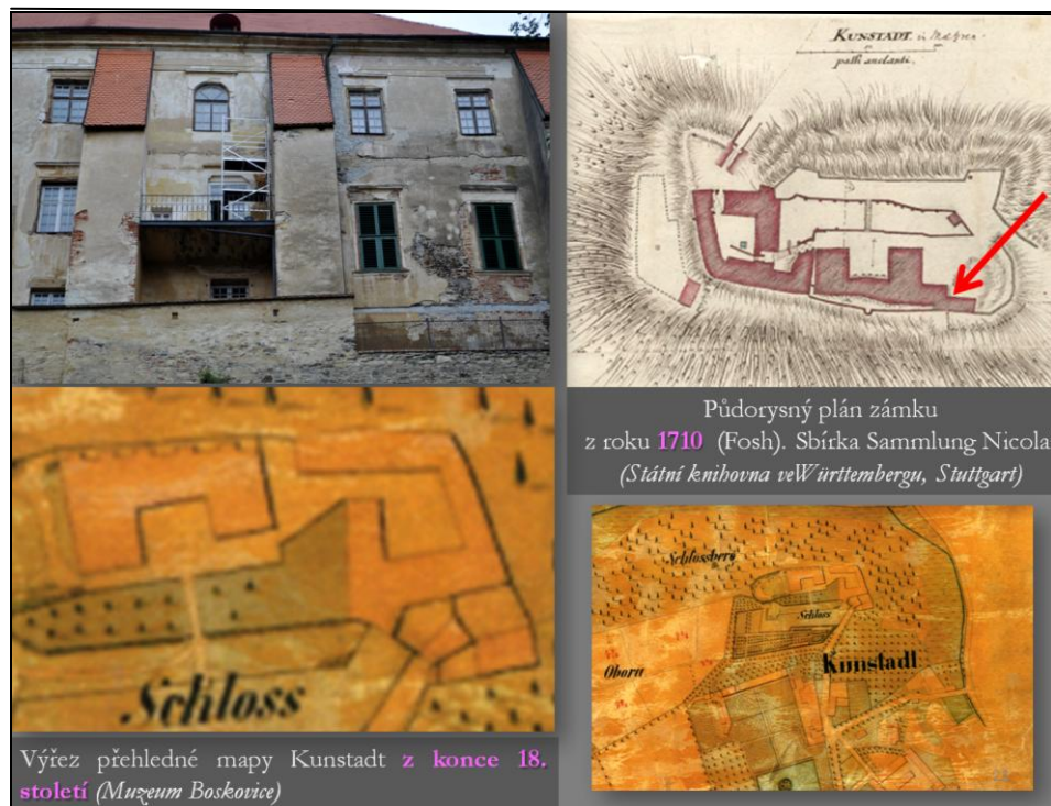
Obrázek 31 – dodatečně přistavěné opěrné pilíře při západní obvodové zdi - pravděpodobně na sklonku 18. století (snímek vlevo nahoře). Situační plán z roku 1710 s odsazeným výběžkem západního křídla (snímek vpravo nahoře), půdorysný plán zámku z roku 1727 (sbírka S. Nicolai, Státní knihovna ve Württembergu, Stuttgart ) a výřez přehledné mapy Kunstadt z konce 18. století ( Muzeum Boskovice ). Šipka označuje jižní výběžek křídla.
