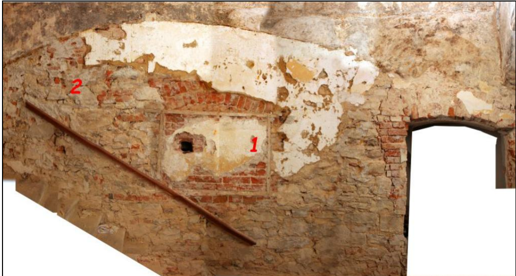
Obrázek 63 – příklad dokumentace cihlového zdiva na východní stěně místnosti v přízemí místnosti 111. Čelní pohled po odkrytí recentních vrstev. Barokní zazdívka stlačeného oblouku s odhaleným dodatečně zazděným segmentově zaklenutým průchodem (2) do místnosti 117/119 a zazděná nika z 18. století (1), složená fotografie (D. Zeman a kol., 2014).
