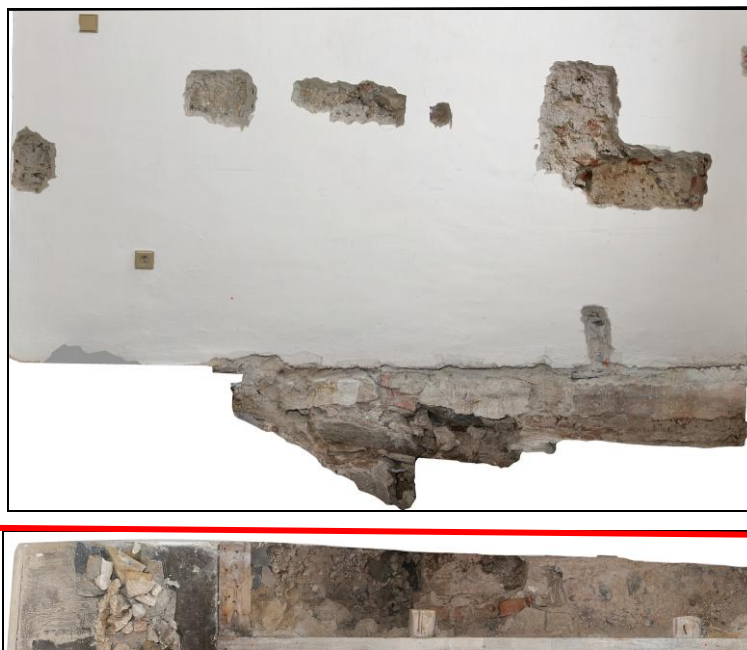
Obrázek 37 a – fotogrammetrické zaměření sond na jižní stěně místnosti 304 a podélné sondy v podlaze u téže stěny (J. Vidman).
