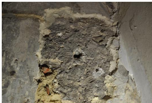
Obrázky 40a – sonda na východní stěně místnosti 115 s charakteristicky utvářeným povrchem omítky (OM II.). Vpravo povrch omítky s patrnými depozity (zvětšeno 60x).
