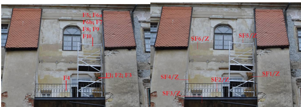
Obrázek 11 – část západní fasády s lokalizací sond a odběrů vzorků
