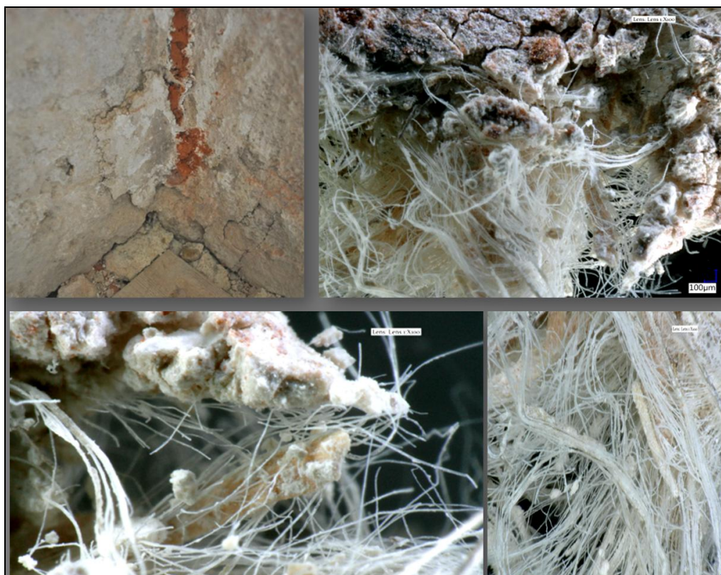
Obrázek 71 – barokní opravná malta (V30) s výztuží použitá k výpravě JZ koutové trhliny (Keyence VHX 900F).
