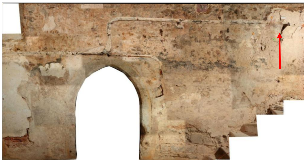
Obrázek 43 – celkový pohled na západní stěnu místnosti v přízemí 111 s gotickým lomeným portálem s okosenou hranou, omítkami a sondou staršího vstupního portálu, složená fotografie (D. Zeman a kol., 2013).
