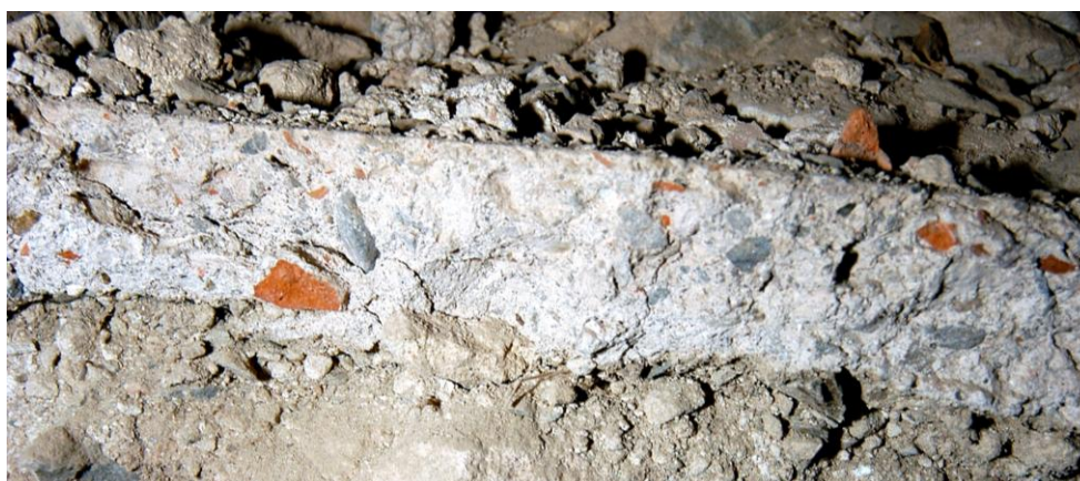
Obrázek 83 – pohled na příčný řez maltové podlahy s patrnou strukturou plniva. Zhutněná maltová směs spočívá na klenebním zásypu (hrotitá valená klenba v přízemí jižního konce západního křídla, místnost 106).
