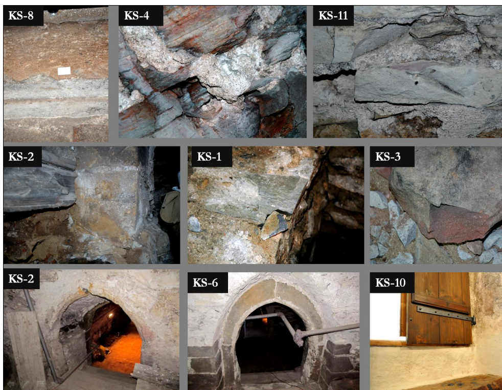
Obrázek 58 – přehled kamenných prvků ve sklepních prostorech.
