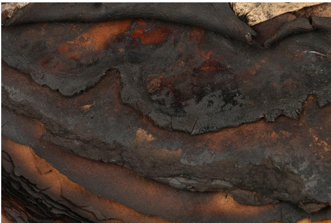
Obrázek 49 Detail poškození desky a usňového pokryvu
