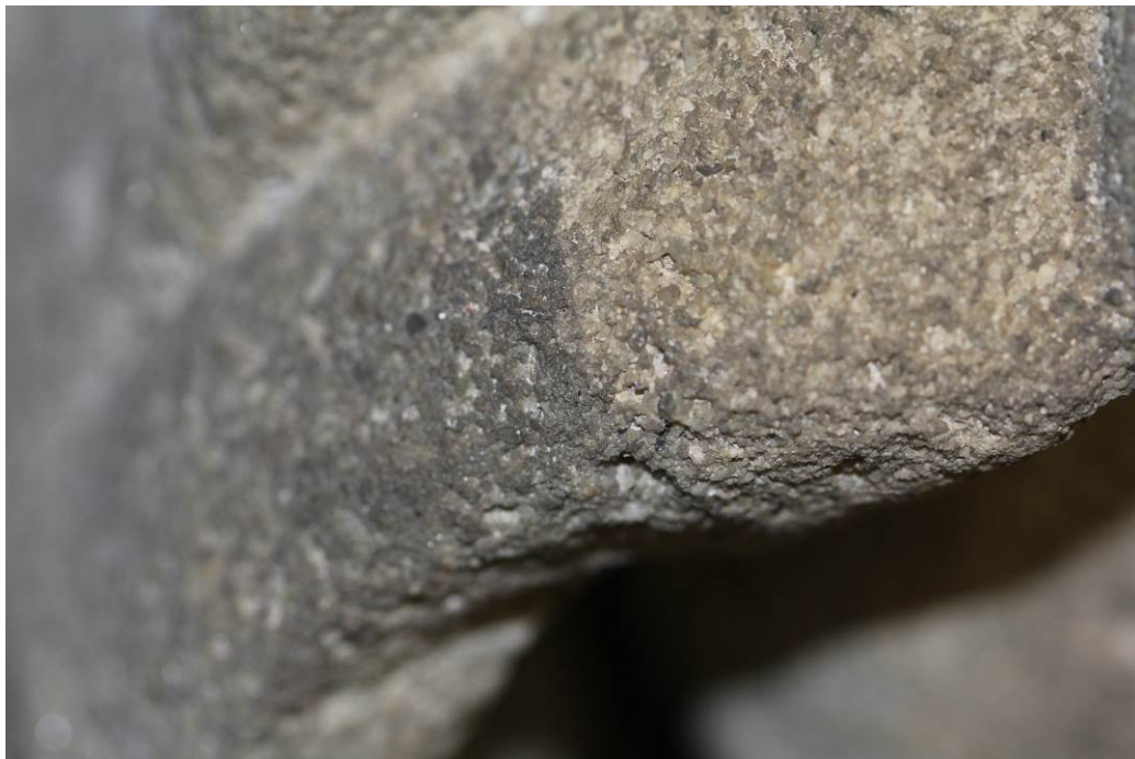
Obrázek 10 detail - rozhraní čištěné a nečištěné plochy
