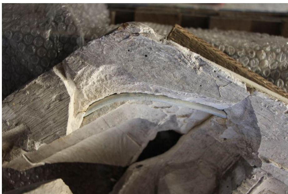
Obrázek 65 Ošetření kovových armatur - po aplikaci ochranného alkytonového nátěru
