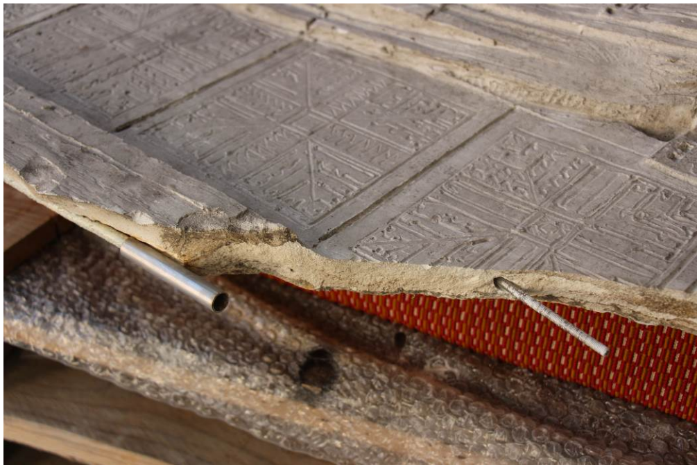
Obrázek 69 Detail - před lepením - nerezový čep a vysprávka rozříznuté armatury
