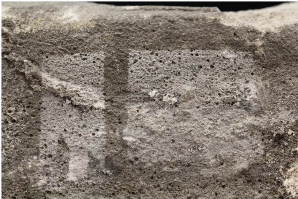
Obrázek 105 Zkouška mikropískování - degradovaný povrch - po
