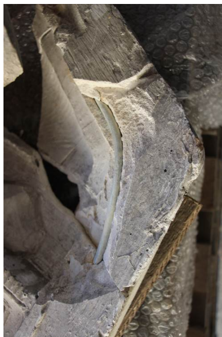
Obrázek 80 Detail – armatura po ošetření
