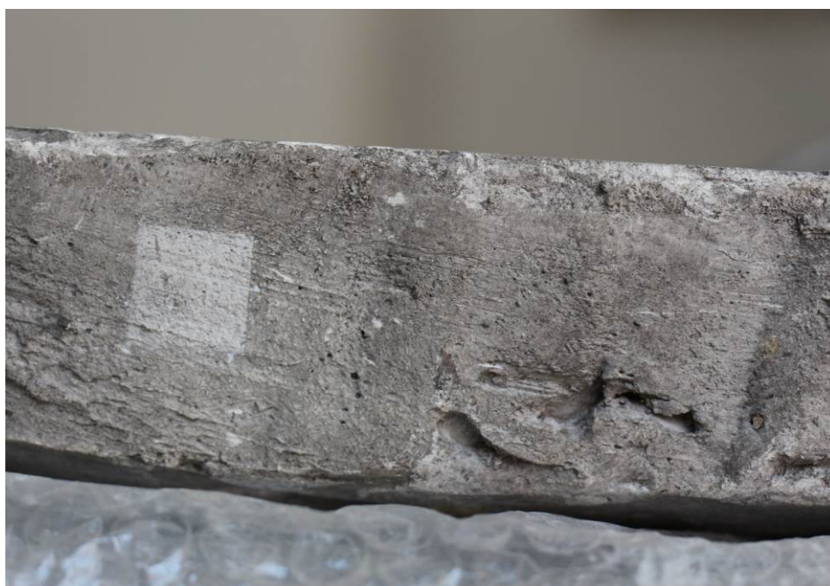
Obrázek 104 Zkouška mikropískování - hladký povrch - po
