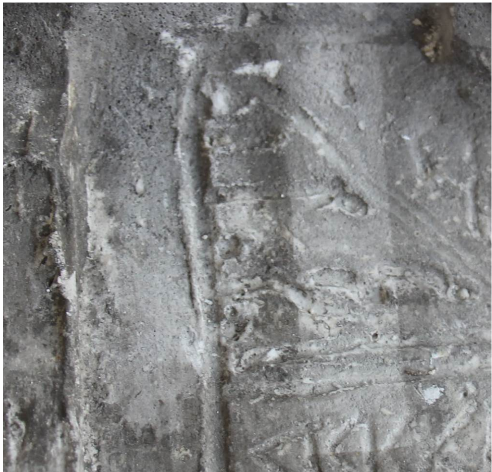
Obrázek 100 Detail zkoušky čištění - srovnání – zleva: agar, mikropískování
