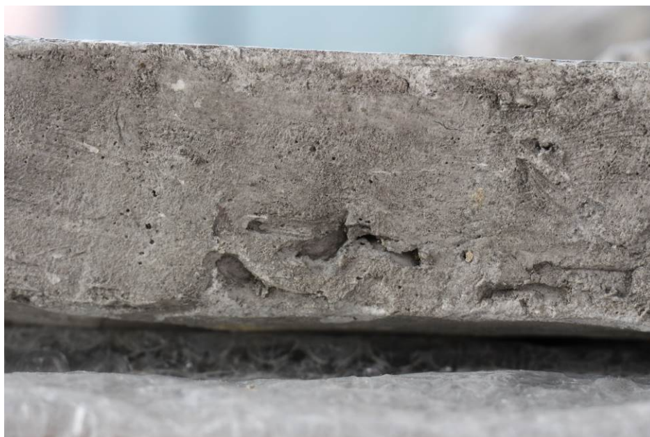
Obrázek 103 Zkouška mikropískování - hladký povrch - před
