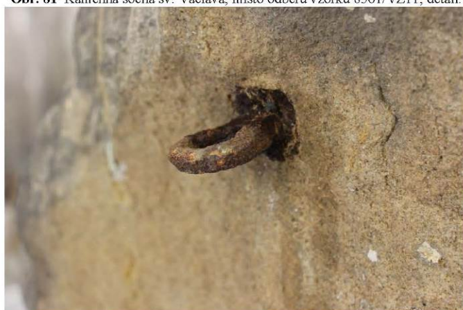
Obr. 82 Kamenná socha sv. Václava, místo odběru vzorku 8562/VZ12, zalévací hmota očka, detail.
