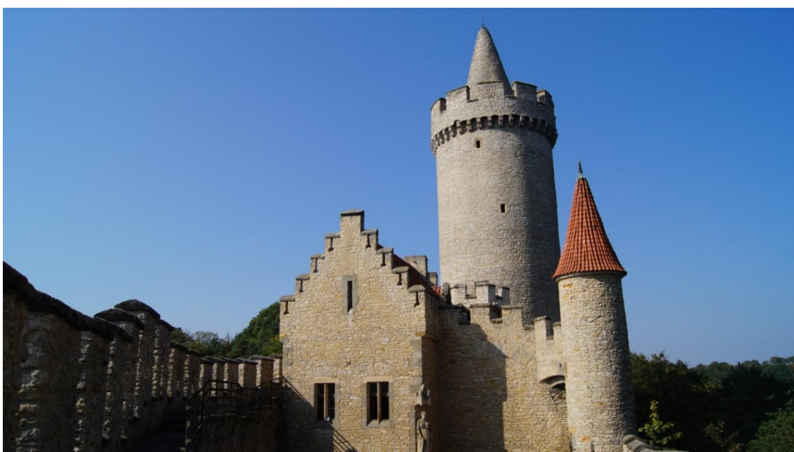
Obr. č. 50. Nový palác Kokořina s bergfritovou věží v pozadí. Pohled od východu.
