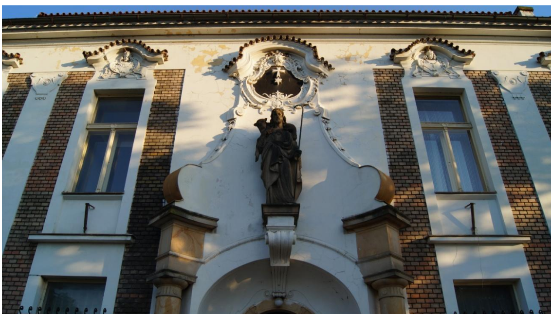
Obr. č. 145: Fara čp. 20. Detail severního průčelí fary se sochou Dobrého pastýře.
