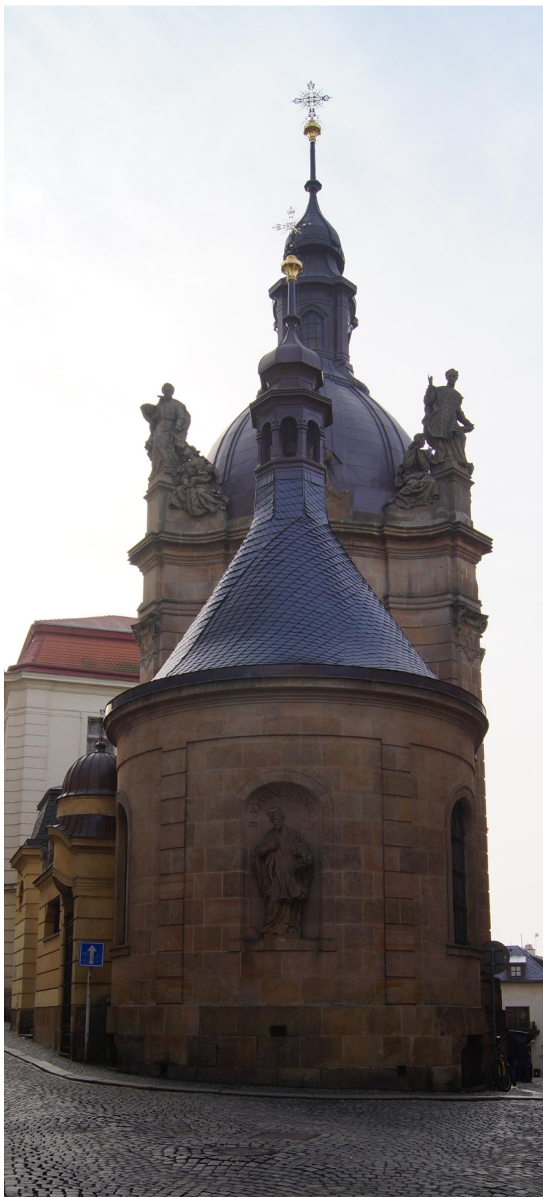
Obr. č. 134: Kaple sv. Jana Sarkandra (2016). Pohled od severovýchodu.
