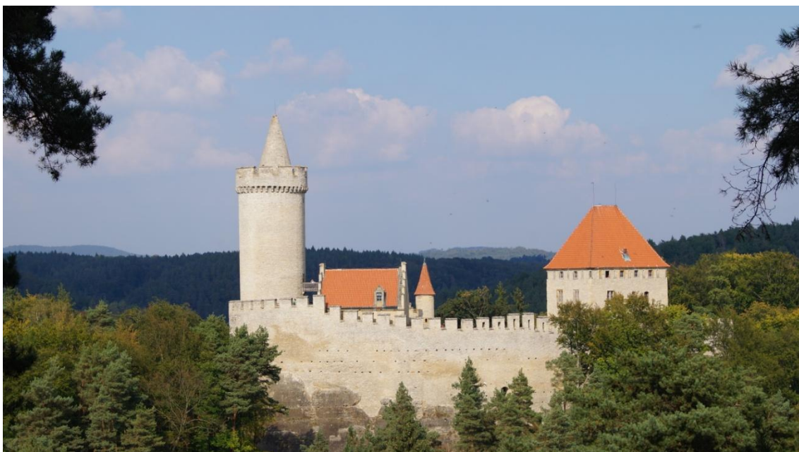
Obr. č. 49: Stav hradu Kokořina v roce 2016. Pohled od jihu.
