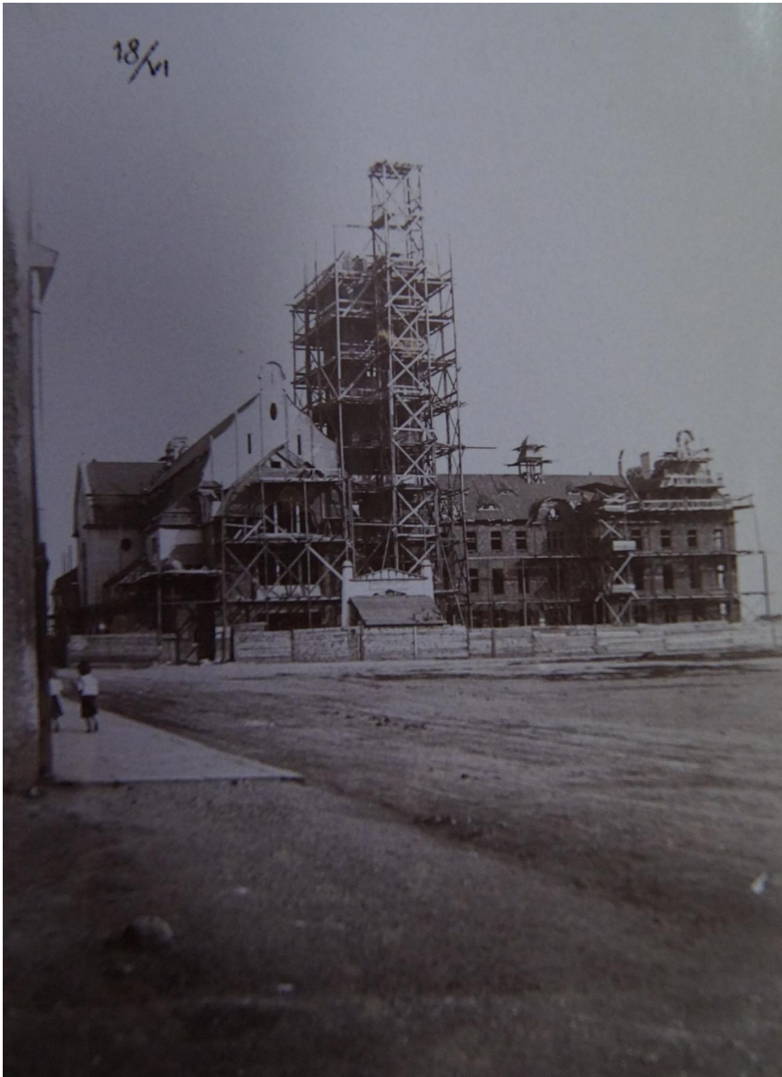
Obr. č. 93: Průběh stavby kostela Panny Marie Růžencové v letech 1912–1913 (7).
