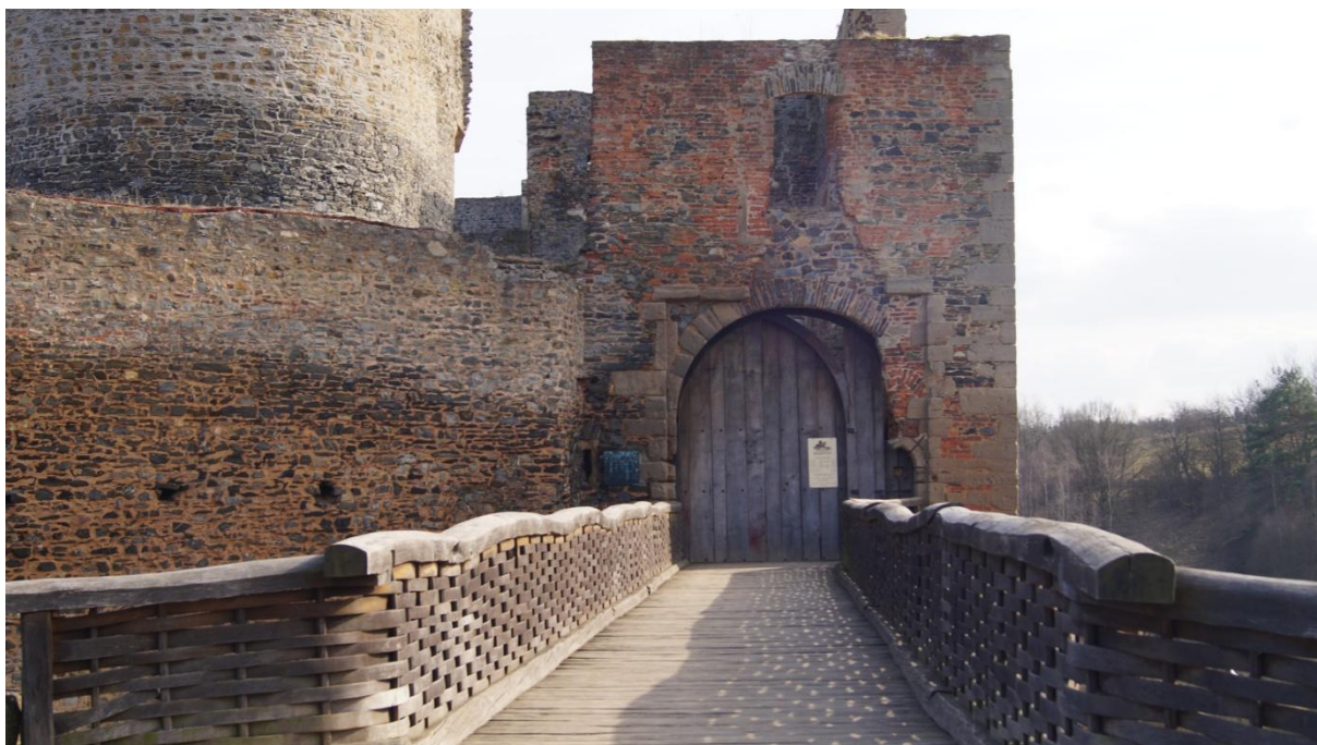
Obr. č. 40: Stav hlavní brány zříceniny hradu Krakovce v roce 2017.
