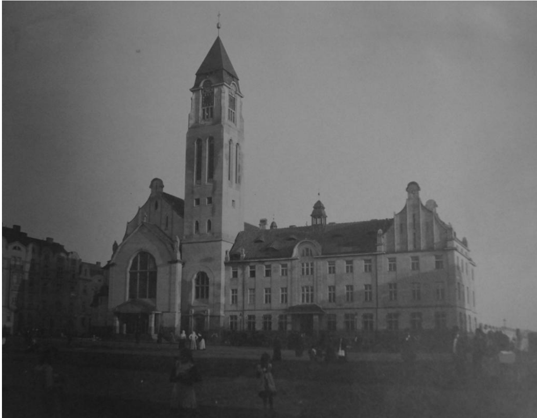
Obr. č. 95: Průběh stavby kostela Panny Marie Růžencové v letech 1912–1913 (9).
