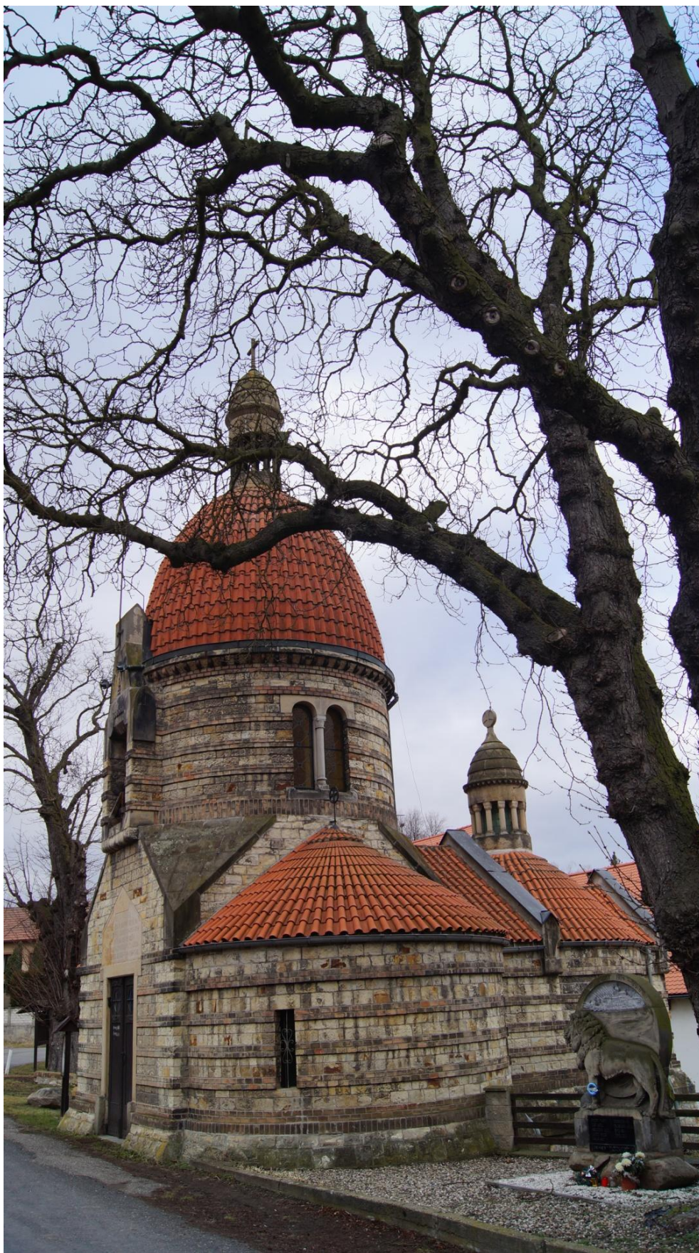
Obr. č. 66: Kaple sv. Václava: Pohled od severozápadu (2017).
