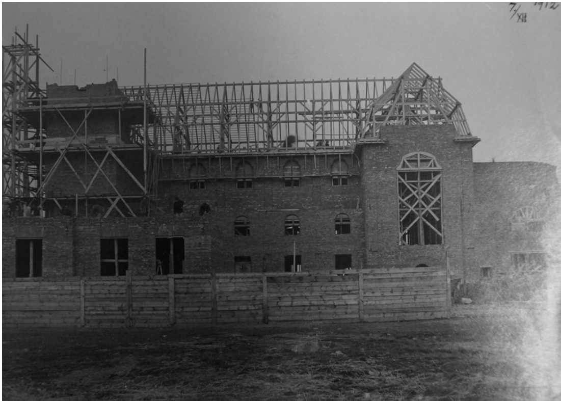
Obr. č. 91: Průběh stavby kostela Panny Marie Růžencové v letech 1912–1913 (5).
