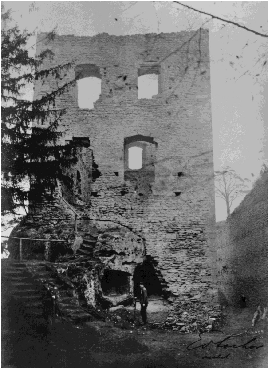
Obr. č. 45: Starý palác Kokořina před rekonstrukcí. Pohled od západu.
