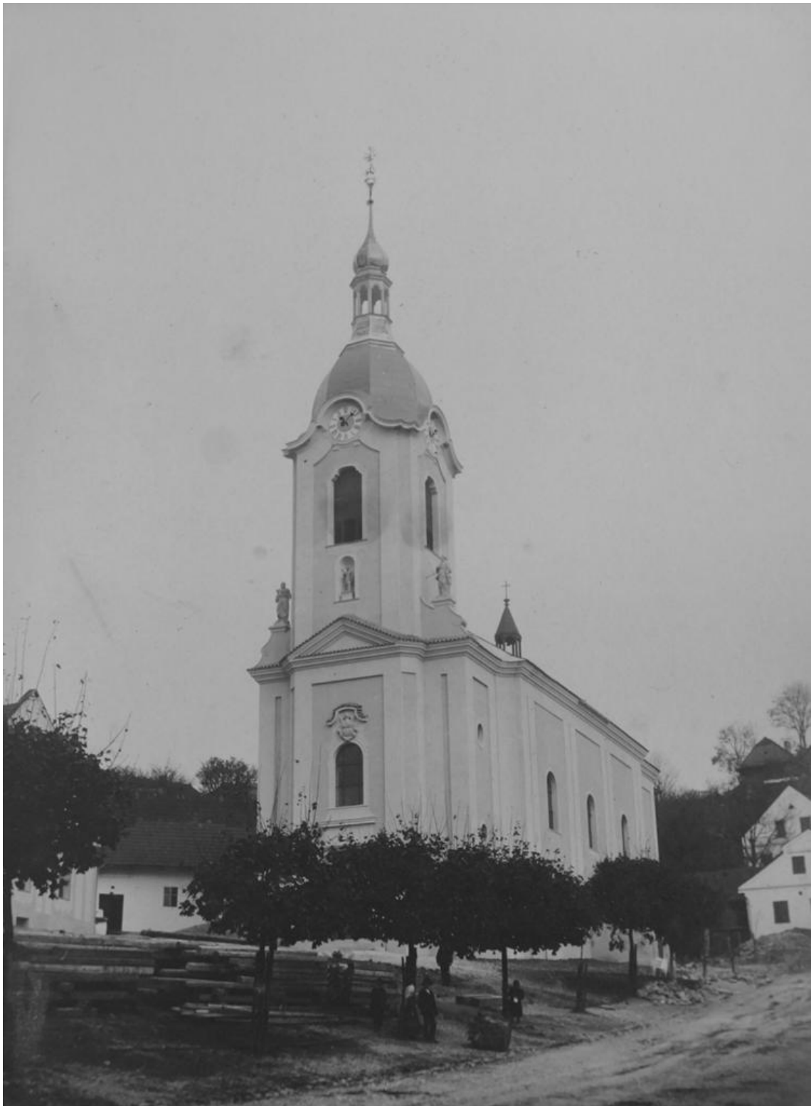
Obr. č. 122: Kostel sv. Jana Nepomuckého po dokončení stavby věže. Pohled od jihu.
