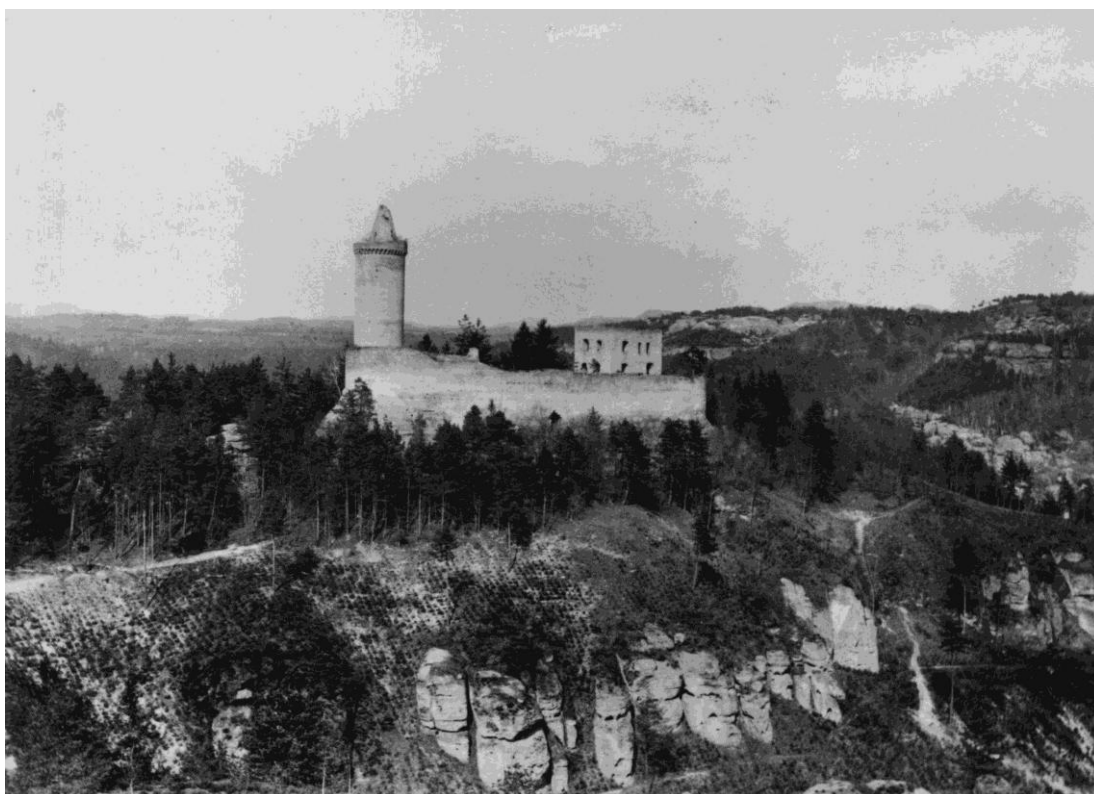
Obr. č. 43: Hrad Kokořín před obnovou. Pohled od jihozápadu.
