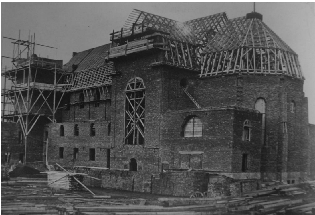
Obr. č. 92: Průběh stavby kostela Panny Marie Růžencové v letech 1912–1913 (6).
