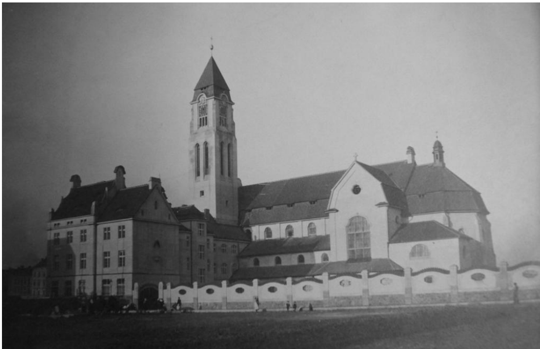
Obr. č. 96: Průběh stavby kostela Panny Marie Růžencové v letech 1912–1913 (10).
