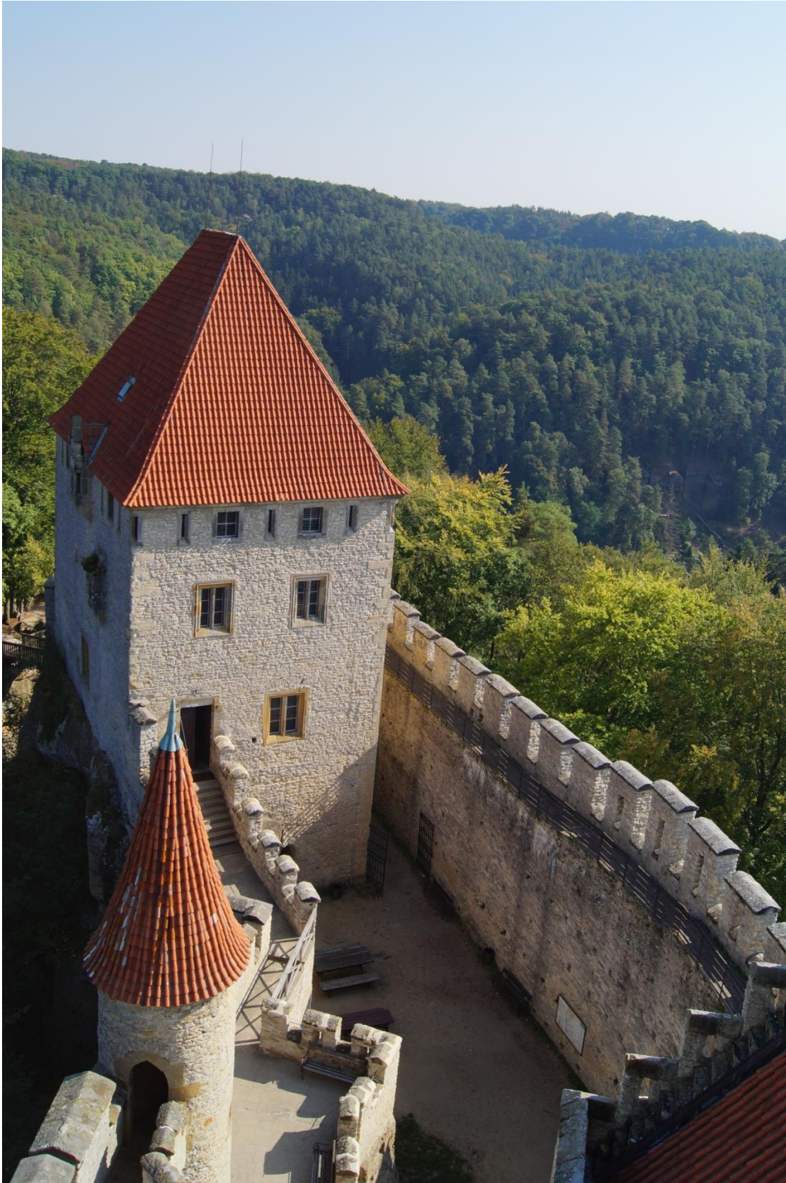
Obr. č. 51: Pohled z ochozu bergfritové věže Kokořína na starý palác.
