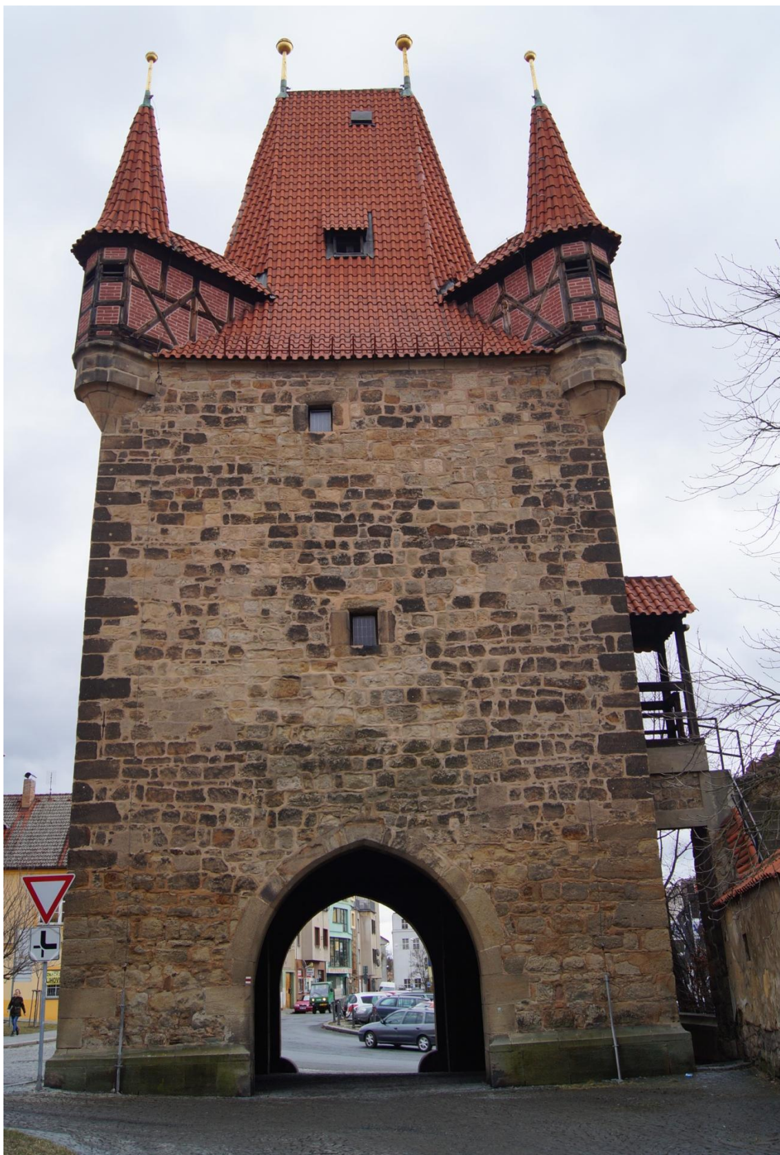
Obr. č. 26: Pražská brána v Rakovníku v roce 2017. Pohled od západu.
