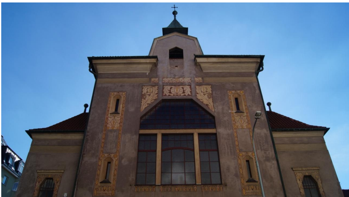
Obr. č. 104: Východní průčelí kostela sv. Anny na Žižkově (1).
