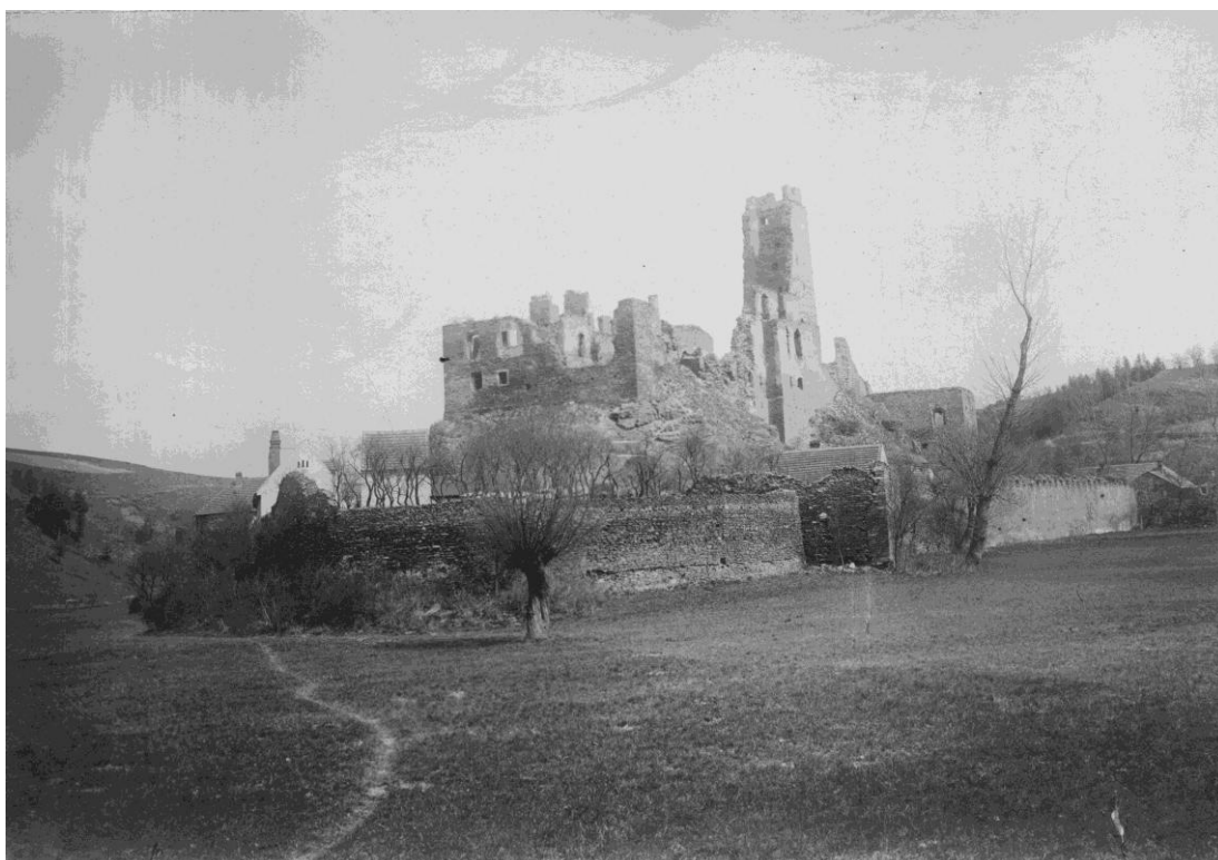
Obr. č. 56: Stav zříceniny hradu Okoře okolo roku 1920. Pohled od jihozápadu.
