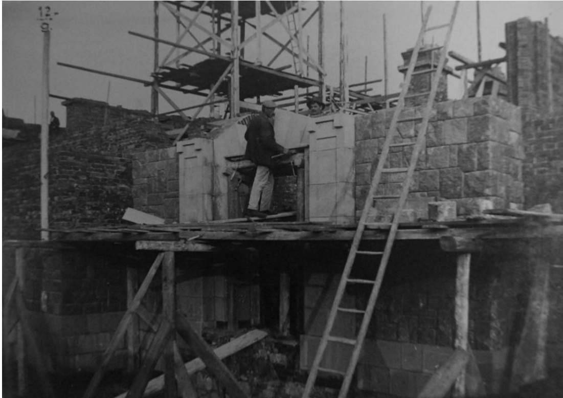
Obr. č. 89: Průběh stavby kostela Panny Marie Růžencové v letech 1912–1913 (3).
