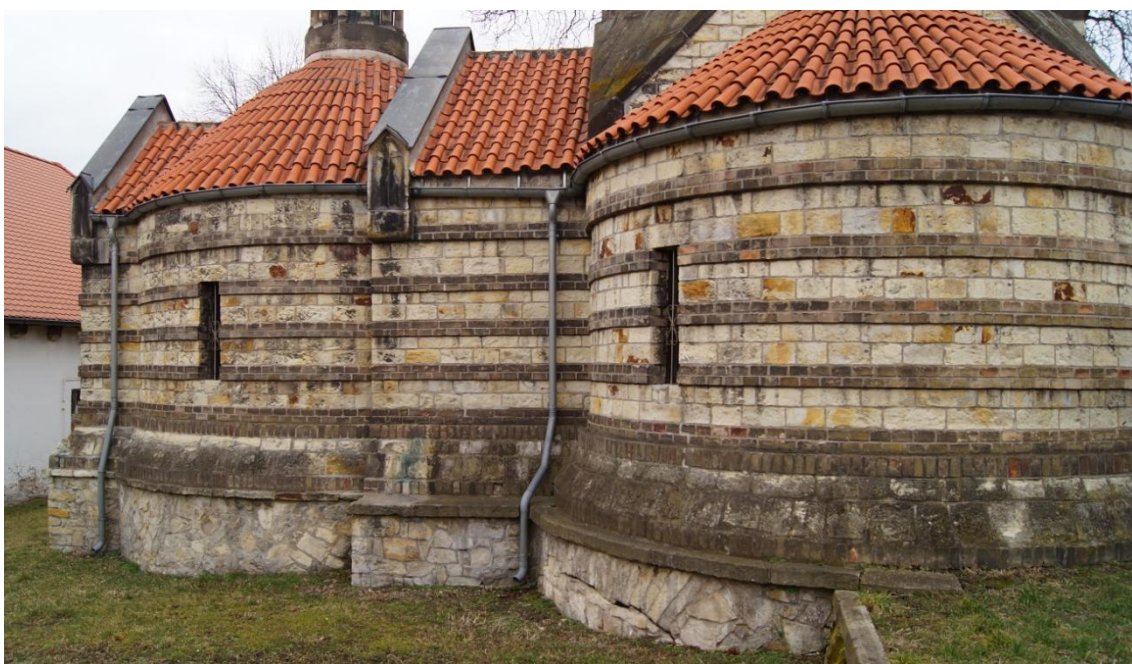
Obr. č. 68: Kaple sv. Václava. Detail překlenutí místa, kde dříve protékal potok.
