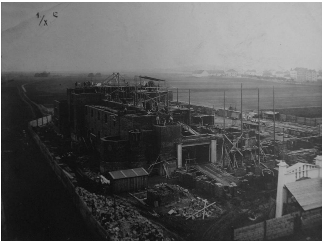
Obr. č. 88: Průběh stavby kostela Panny Marie Růžencové v letech 1912–1913 (2).
