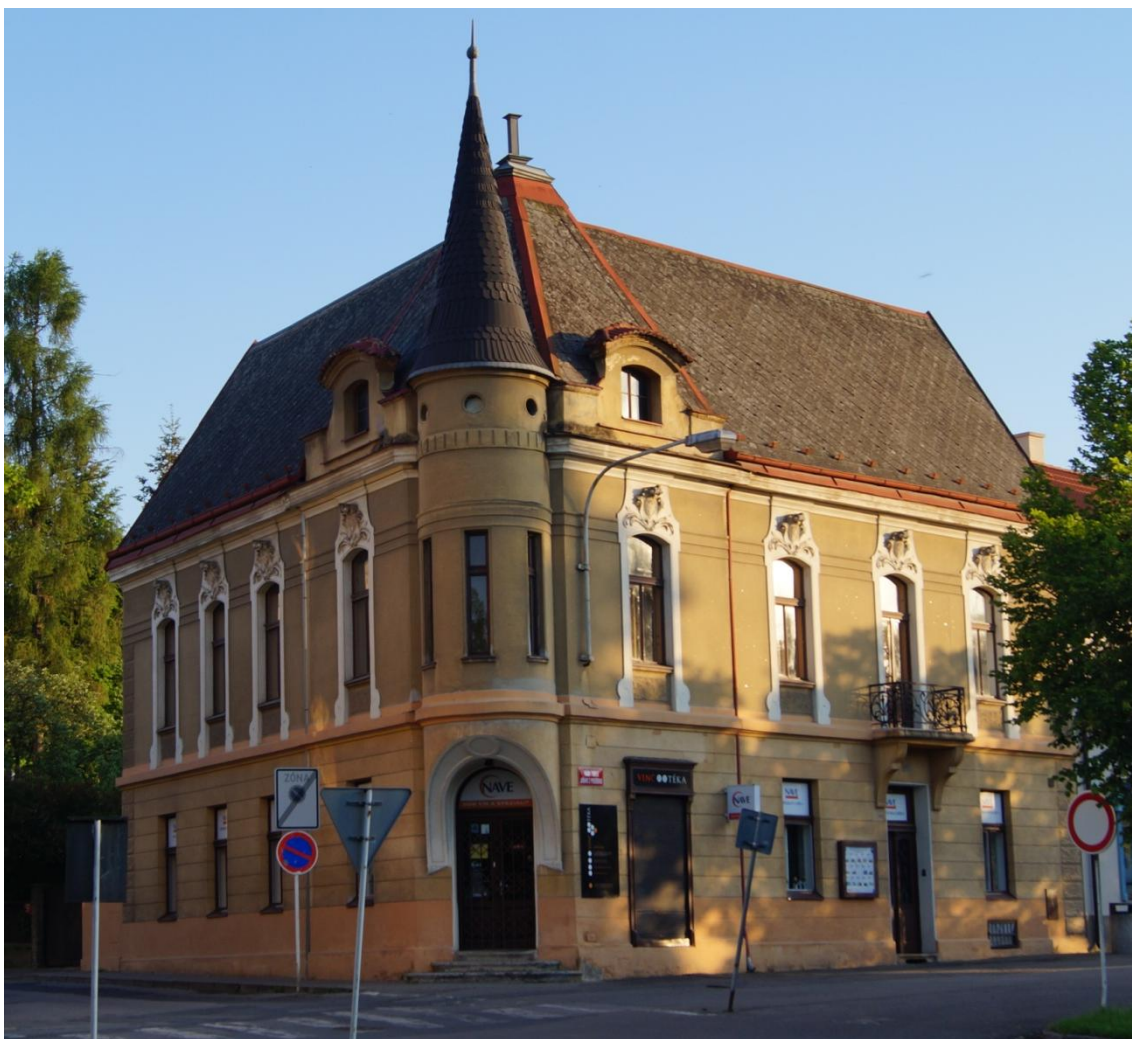
Obr. č. 154: Dominikánský dům čp. 25. Pohled na severovýchodní nároží domu (2017).
