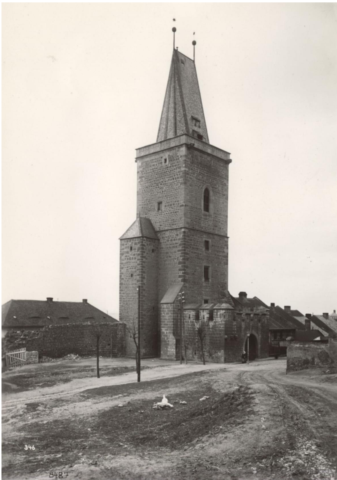
Obr. č. 30: Vysoká brána v Rakovníku po dokončení restaurace. Pohled od severovýchodu.
