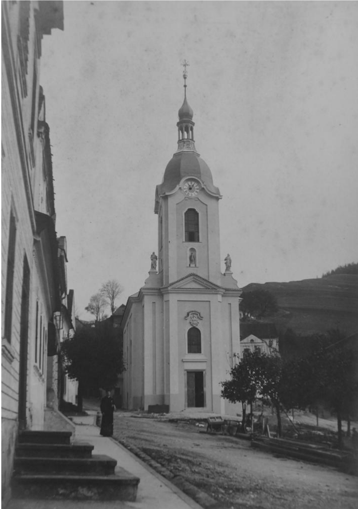
Obr. č. 121: Kostel sv. Jana Nepomuckého po dokončení stavby věže. Pohled od jihozápadu.
