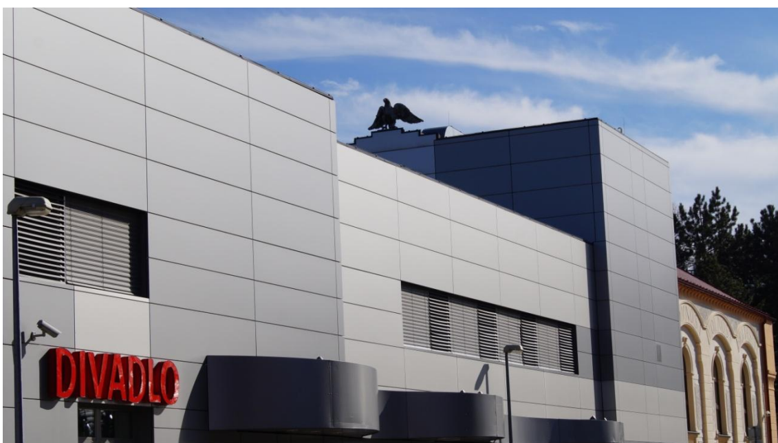
Obr. č. 22: Detail fasády divadla a sokolovny v Uhřetěvesi.
