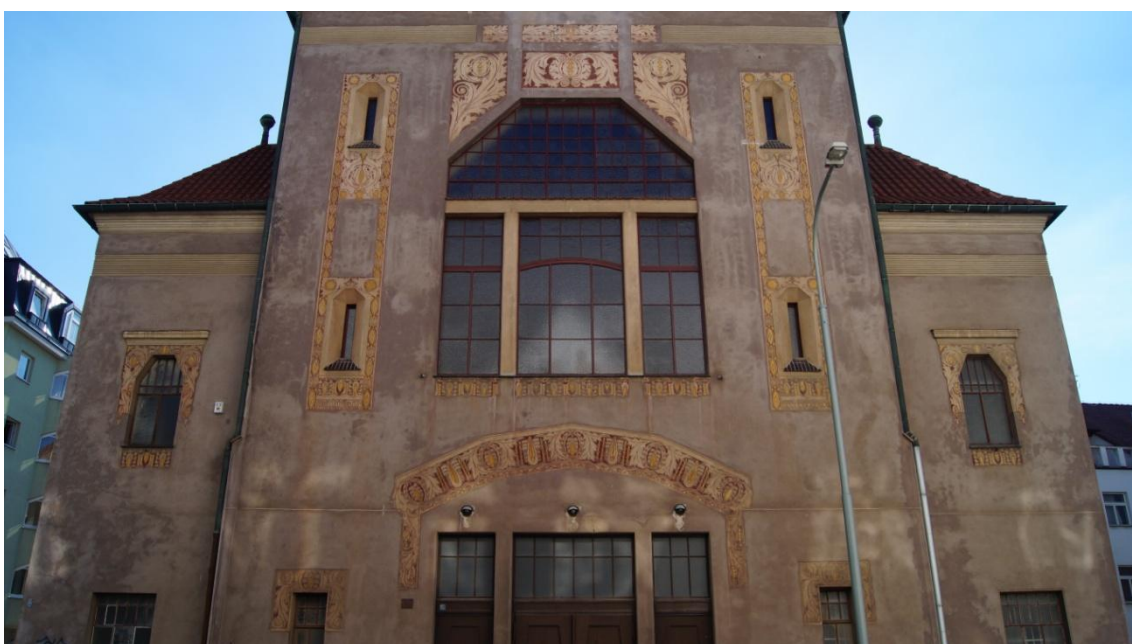
Obr. č. 105: Východní průčelí kostela sv. Anny na Žižkově (2).
