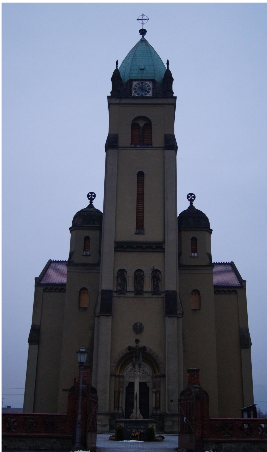
Obr. č. 111: Kostel Božského Srdce Páně v roce 2016. Pohled od západu.
