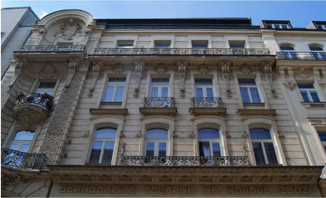
Obr. č. 14: Detail nápisu „Berndorfská továrna na kovové zboží“.
