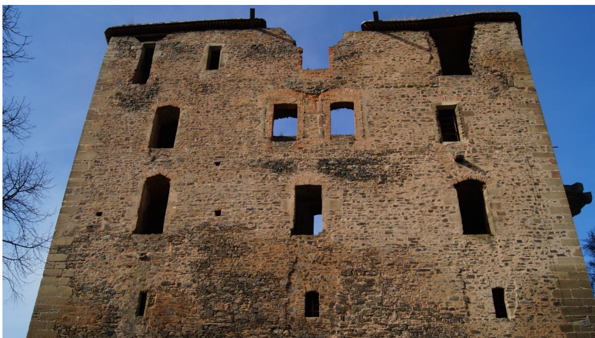
Obr. č. 41: Stav jižního průčelí zříceniny hradu Krakovce v roce 2017.
