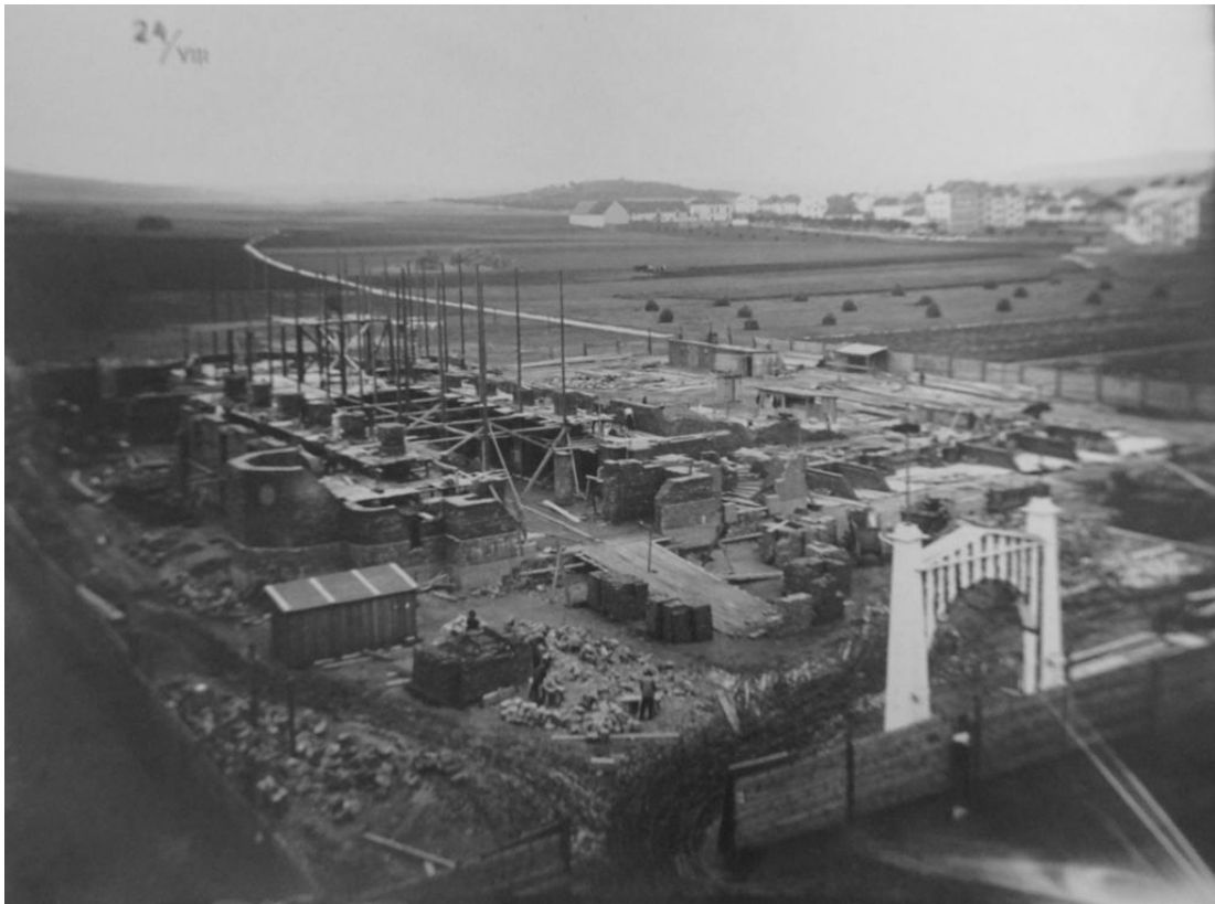
Obr. č. 87: Průběh stavby kostela Panny Marie Růžencové v letech 1912–1913 (1).
