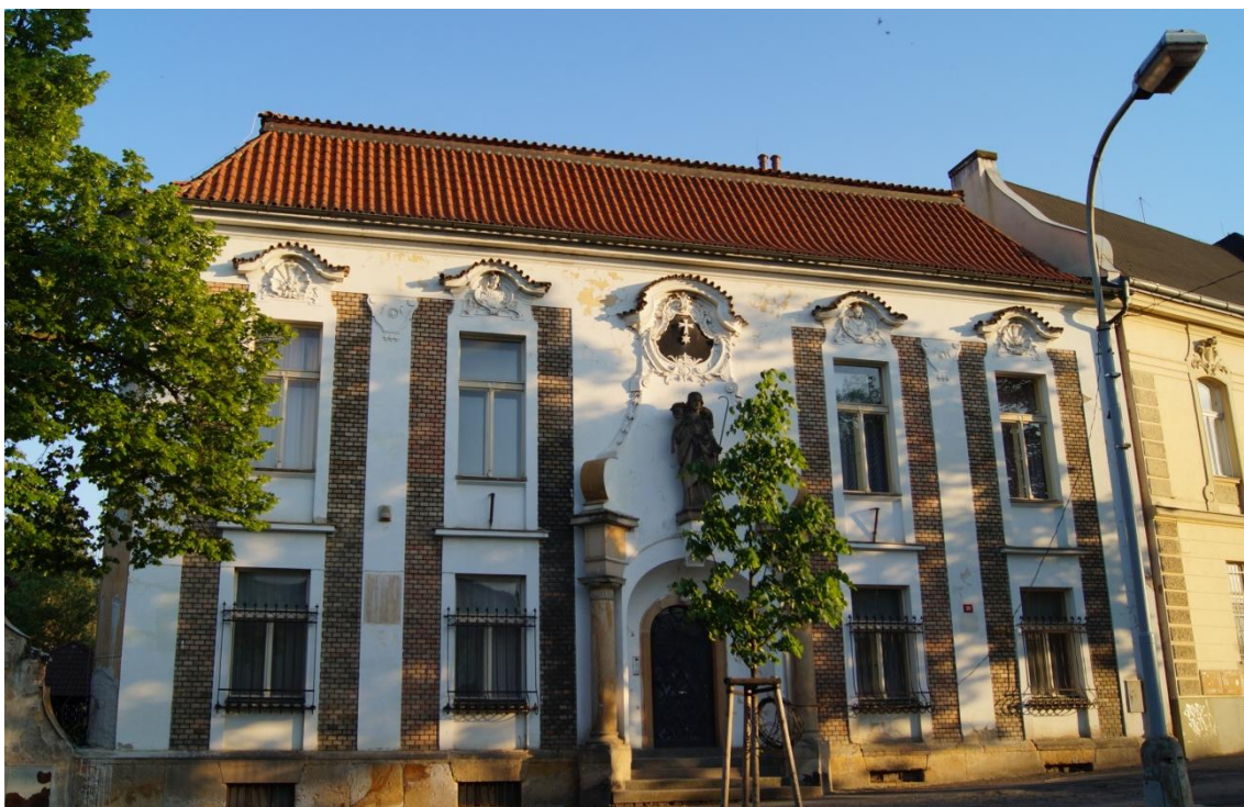
Obr. č. 144: Fara čp. 20. Severní průčelí fary v roce 2017.
