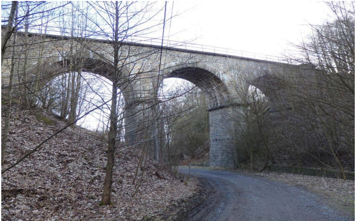
Obrázek 4 Křižanovský viadukt, (KPKŽ, 2017)
