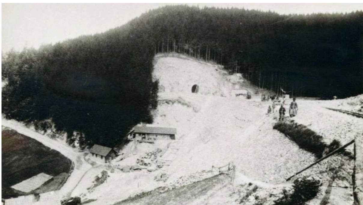
Obrázek 5 Stavba Mikulovského tunelu, (KPKŽ, 2017)
