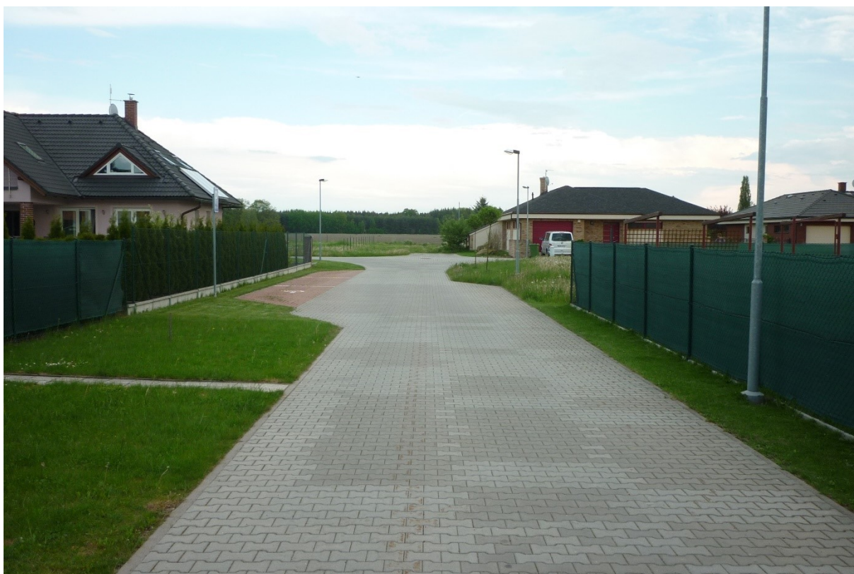
Pohled 2 – stávající komunikace v obytné zóně
