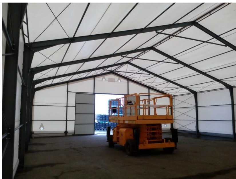
Obrázek 8 – Opláštění pomocí hi-tech membrány, vnitřní pohled (zdroj: Příloha 15)
