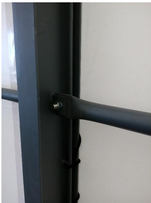
Obrázek 5 – Šroubový spoj podélného ztužení pomocí šroubu M16 (zdroj: Příloha 15)
