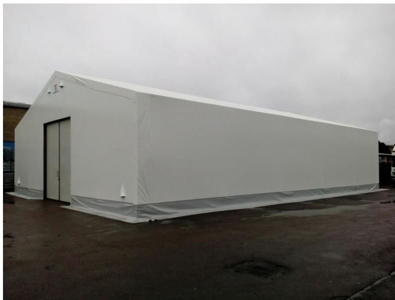
Obrázek 7 – Opláštění pomocí hi-tech membrány, vnější pohled (zdroj: Příloha 15)
