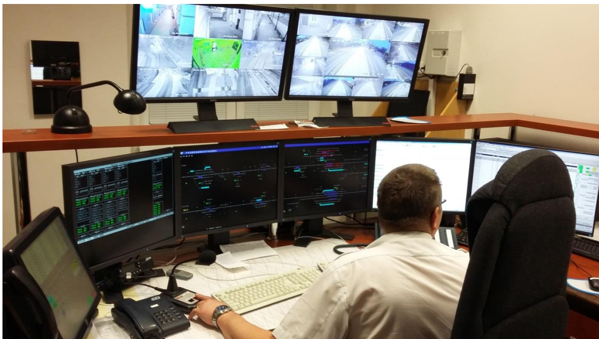
Obrázek 9: Pracoviště dispečera DOZ s elektronickým stavědlem ESA 44
