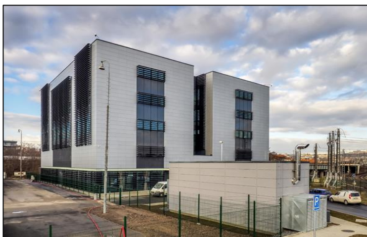
Obr. 10 Budova CDP Praha
