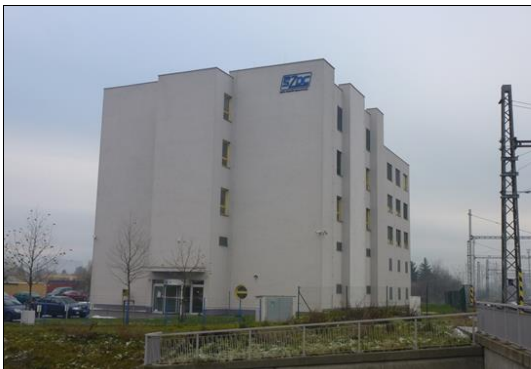
Obr. 7 Budova CDP Přerov
