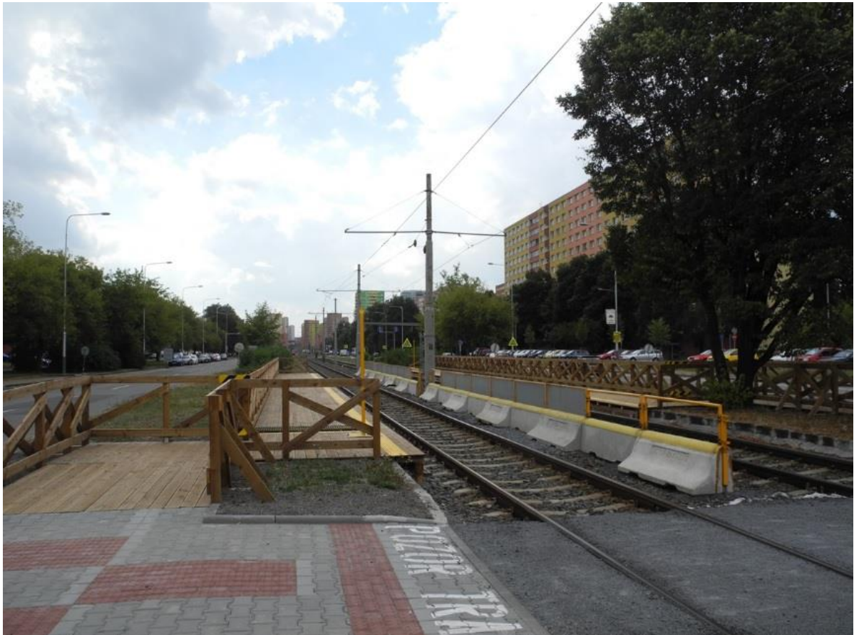
Obr. 11 Provizorní nástupiště z dřevěných latí
