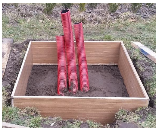
Obrázek 4-6 Příprava podstavce pro rozvaděč R1
