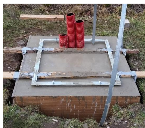
Obrázek 4-6 Příprava podstavce pro rozvaděč R1
