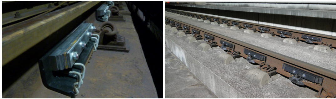
Obr. 31: Absorpční prvky použité na kolejnici (zdroj: railway-technology.com)
